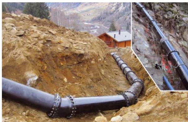
max. Betriebsdruck beträgt 23 bar. Die nach EN 545 als verstärkte Umhüllung geltende Polyurethan-Umhüllung der *ecopur*-Rohre erwies sich in diesem schwierigen Gelände als äußerst widerstandsfähig. Das Druckleitungssystem wurde auf der Baustelle einer Dichtheitsprüfung mit einem Prüfdruck von 32 bar während 24 Stunden unterzogen. Nach nur 16-monatiger Bauzeit konnte das Kleinwasserkraftwerk im Juni 2012 in Betrieb genommen werden. Die aktuelle Produktionsleistung beträgt 1.700 kW.
