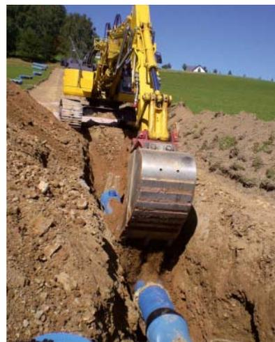
wirtschaftlich, weil zusätzliche Arbeitsgänge und Transportarbeiten entfallen können. Wegen des geodätischen Höhenunterschiedes wurde die Leitung für einen Betriebsdruck von PFA = 25 bar ausgelegt und vor Inbetriebnahme mit 30 bar geprüft.
