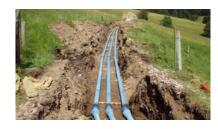
Beitrag zur ökonomischen und technischen Nachhaltigkeit. Bei der Verbindungstechnik vertraute man auf die bewährte längskraftschlüssige BLS®/VRS®-T - Steckmuffen-Verbindung, die auch hohe Drücke problemlos aufnehmen kann. Die Leitung wurde 2011 gebaut und Ende des vorigen Jahres in Betrieb genommen. Sie sichert nachhaltig die Trinkwasserversorgung der Stadt Todtnau mit ihren Ortsteilen.
