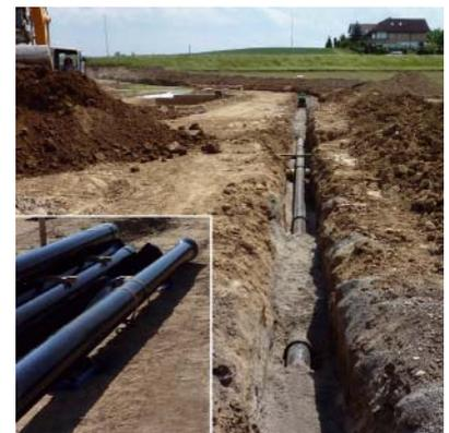
führung im Baugebiet wurden auch zahlreiche von *Rollecofit*-Formstücke mit integraler Epoxidharz-Beschichtung nach EN 14901 und RAL GZ 662 erforderlich. Insgesamt haben alle an diesem Projekt Beteiligten – Bauherr, Ingenieure und Rohrmonteure – das von *Rollecosys*-Vollschutzsystem aus duktilem Gusseisen mit der Steckmuffen-Verbindungstechnik von *Rollhydrotight* als äußerst einfach, zeitsparend sowie sicher einzubauen beurteilt und waren insgesamt sehr zufrieden.
