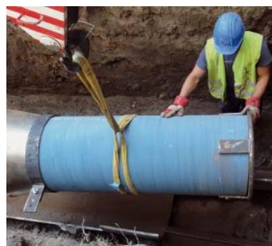
der Baufirma zur Verfügung gestellt. Positiv bewertet wurde die einfache Handhabung der BLS®-Steckmuffen-Verbindung und die Robustheit der mit Zementmörtel umhüllten Gussrohre. Die perfekte Einarbeitung der Bauarbeiter und die laufende Betreuung durch den Rohrhersteller vor Ort wurden als weitere Pluspunkte gewertet. Im nächsten Jahr wird eine weitere Strecke im Relining-Verfahren erneuert werden.
