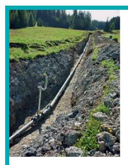
◆ Kernstück der neuen Beschneiungsanlage "Biathlon Arena Lenzerheide" ist ein System 1,8 km duktiler Gussrohre DN 100, Druckstufe PFA 64, mit Polyurethan (PUR)-Auskleidung und einer Umhüllung, bestehend aus einem Zinküberzug mit bituminösem Deckanstrich nach EN 545, sowie duktiler Formstücke. Die gesamte Beschneiungseinrichtung wird in zwei Bauabschnitten erstellt. Der
