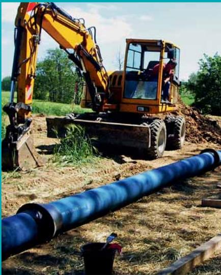
Auf der Insel Rügen musste eine alte AZ-Leitung DN 300 rehabilitiert werden. Die Trasse führt durch sumpfiges Gelände und einen tiefen Geländeeinschnitt an einem Bach. Deshalb entschied sich
