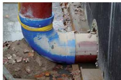
ination aus Dichtheit und Festigkeit des Materials, und somit des Systems, hat sich die KEVAG für duktile Gussrohre DN 500 nach DIN EN 598 System TYTON® und die dazugehörigen Formstücke entschieden.
