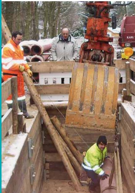
◆ Eingebaut wurden duktile Kanalrohre DN 250 nach DIN EN 598 mit längskraftschlüssigen Steckmuffen-Verbindungen und Zementmörtel-Umhüllung. Zur Übertragung hoher Zugkräfte entschied sich der Auftraggeber nach einer Ausschreibung für die bewährte TYTON® BLS® - Steckmuffen-Verbindung. Darüber hinaus wurde durch ein spezielles Verfahren die Schichtdicke der Zementmörtel-Umhüllung auf dem Rohrschaft soweit angehoben, dass die Rohrmuffe unter einer zylindrischen Außenkontur verschwindet.
