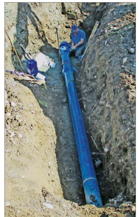
Feldkirchen entschied sich aufgrund der Langlebigkeit und Materialgüte für duktile Gussrohre der Tiroler Rohre GmbH in den Nennweiten DN 100, DN 125, DN 150 und DN 200.
