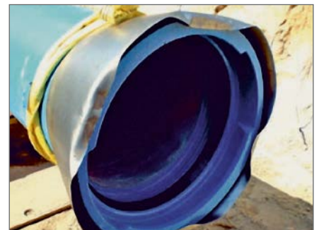
Blechkonus zum Schutz der Rohrmuffe während des Einzugs.
