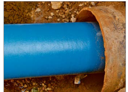
Der Rohrstrang wurde, auf dem Blechkonus schleifend, um jeweils 6 m in die alte Leitung gezogen.
