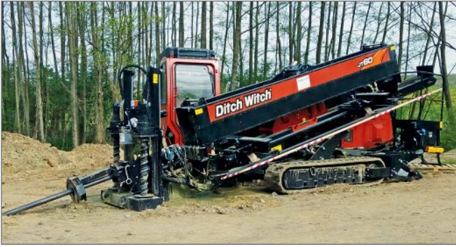
Mit einer „Ditch Witch JT60“ wurde das Bohrloch schrittweise auf 400 mm, 500 mm, 700 mm und schließlich auf 950 mm aufgeweitet.
