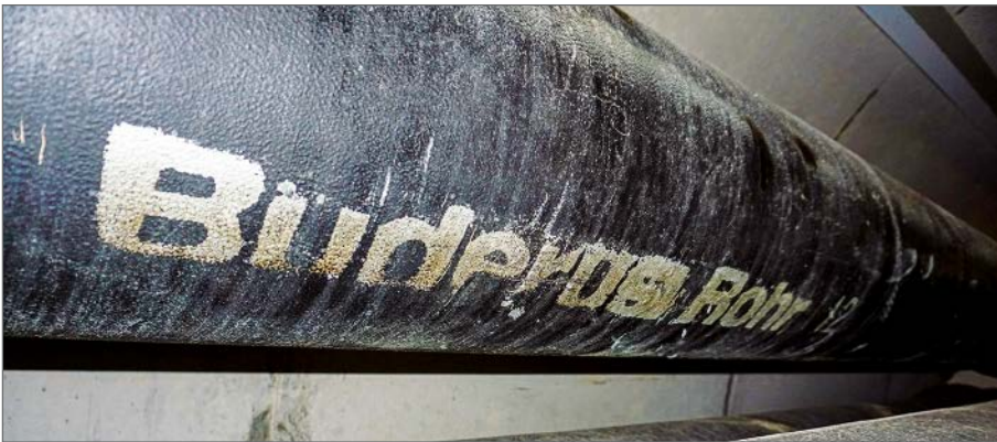
Duktile Gussrohre im Rheindüker.
