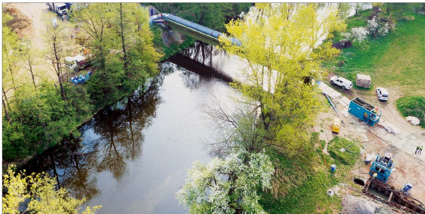
Blick auf die Baustelle rechts und links der Nežárka.
