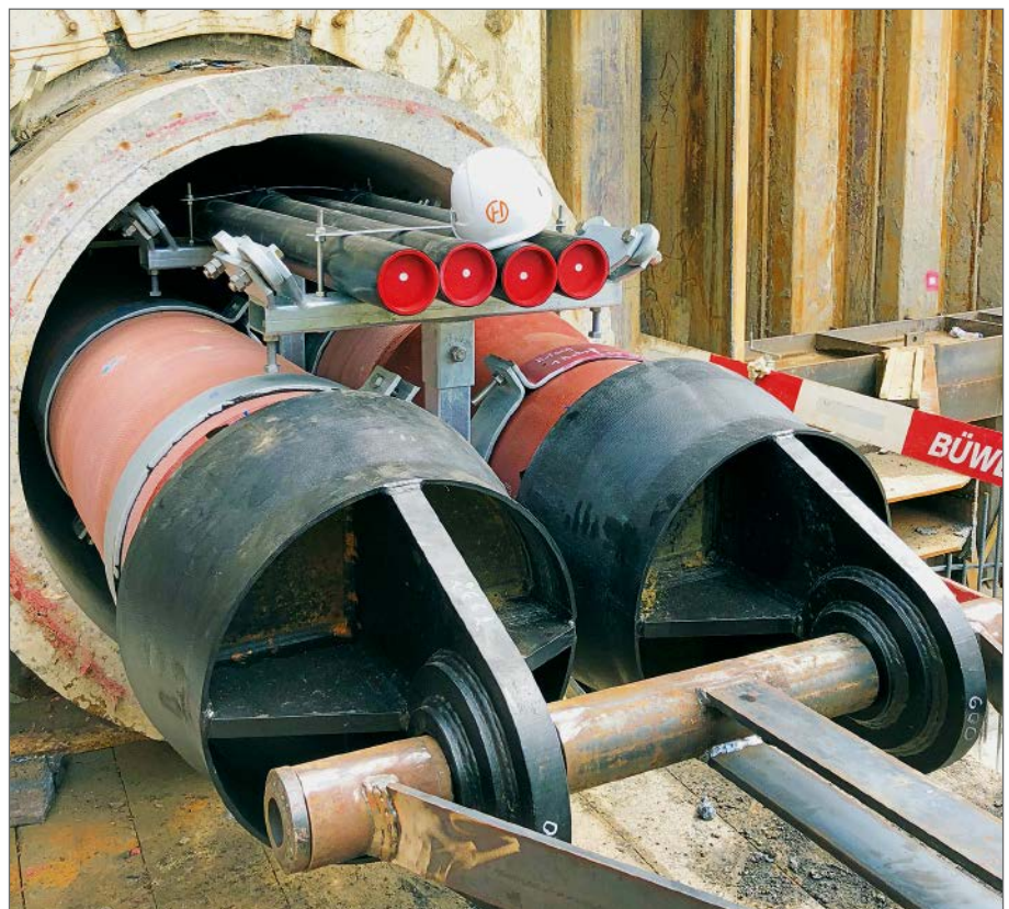
Ankunft am Zielschacht. Deutlich erkennt man die äußerst engen Platzverhältnisse im Microtunnel.
