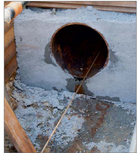
Einzug des Neurohres in die vorhandene alte Rohrleitung im Zugverfahren.
