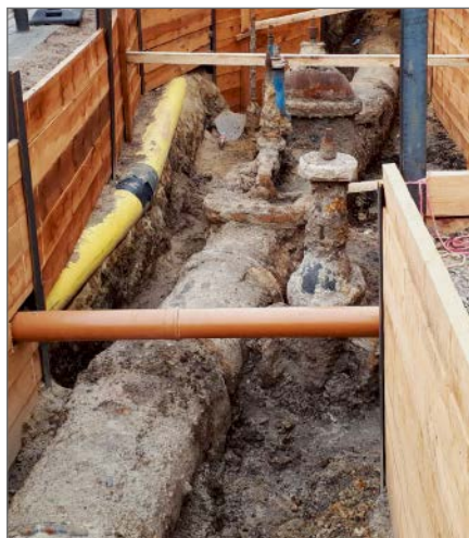
Nach 120 Jahren Betrieb ist die Graugussleitung DN 700 in einem sehr passablen Erhaltungszustand.
