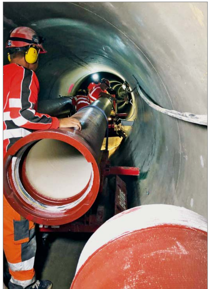
Rohrmontage DN 400 mit Epoxidharz-Deckbeschichtung an der Industriestraße.
