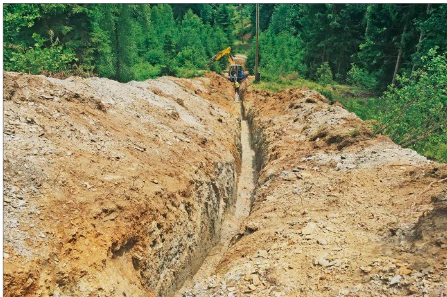
Bahnt sich den Weg nach unten: Der Bau des neuen Abwasserkanals von den Streusiedlungen auf dem Guggenberg zum vorhandenen Abwassernetz war nur mit einem Hydraulikbagger mit Schreitwerk samt Seilwindensicherung möglich.
