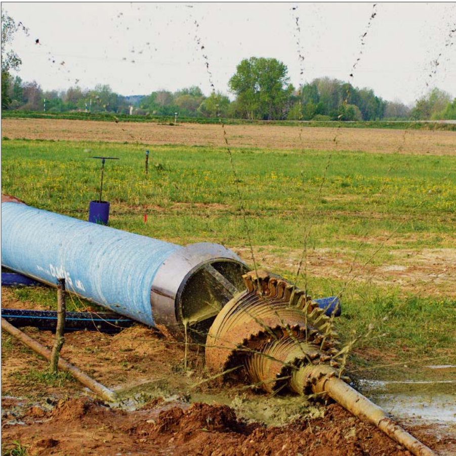
Funktionsprüfung des Bohrkopfes vor dem Rohreinzug.
