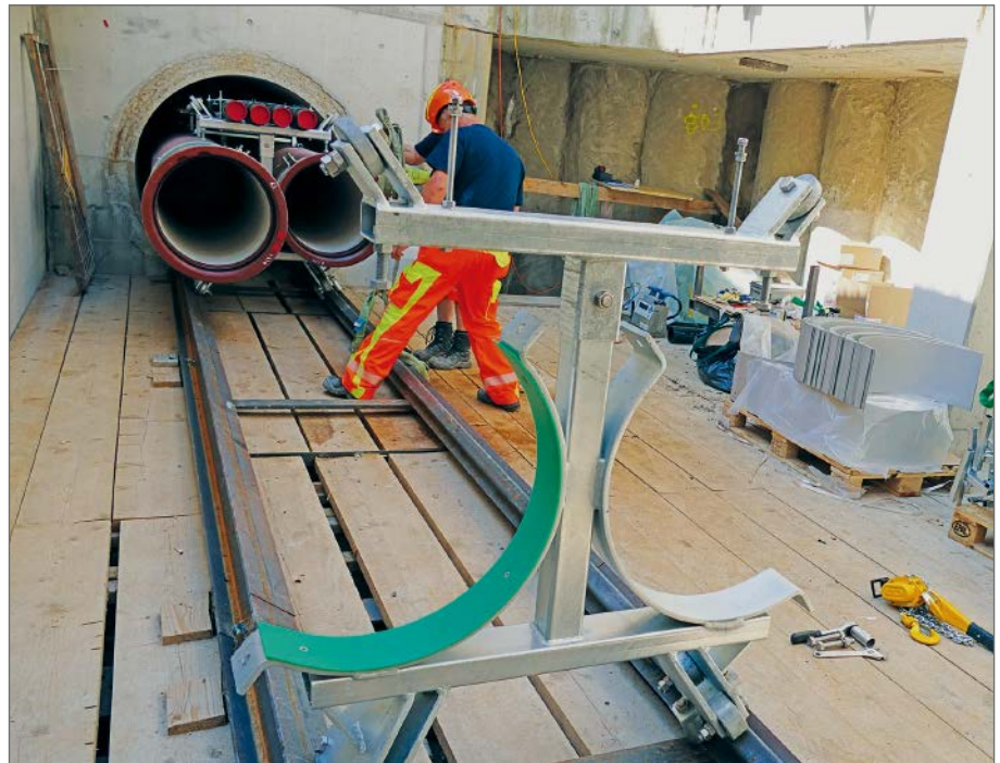
Einzug von zwei Gussrohren gleichzeitig mittels speziell entwickelten, fahrbaren Doppelrohrschellen.
