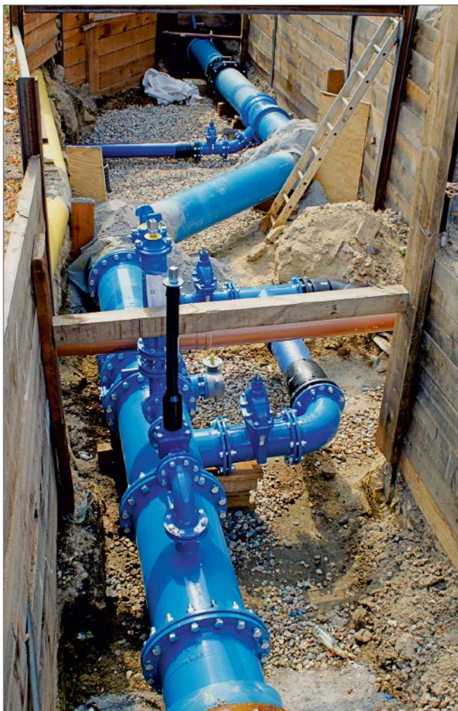
Punktuell wurde zur Einbindung von Armaturen und Hydranten ...
