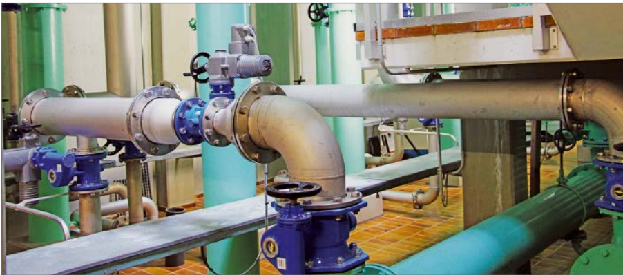
Pass- und Ausbaustück PAS10, Absperrklappen ERHARD ROCO wave mit aufgebautem E-Antrieb.
