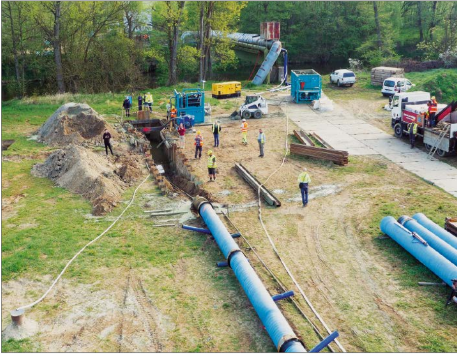
Im Hintergrund: Die in die Jahre gekommene, über die Nežárka-Brücke geführte Trinkwasserleitung; Bildmitte: Startgrube und der zum Einzug bereit liegende fertige Rohrstrang.
