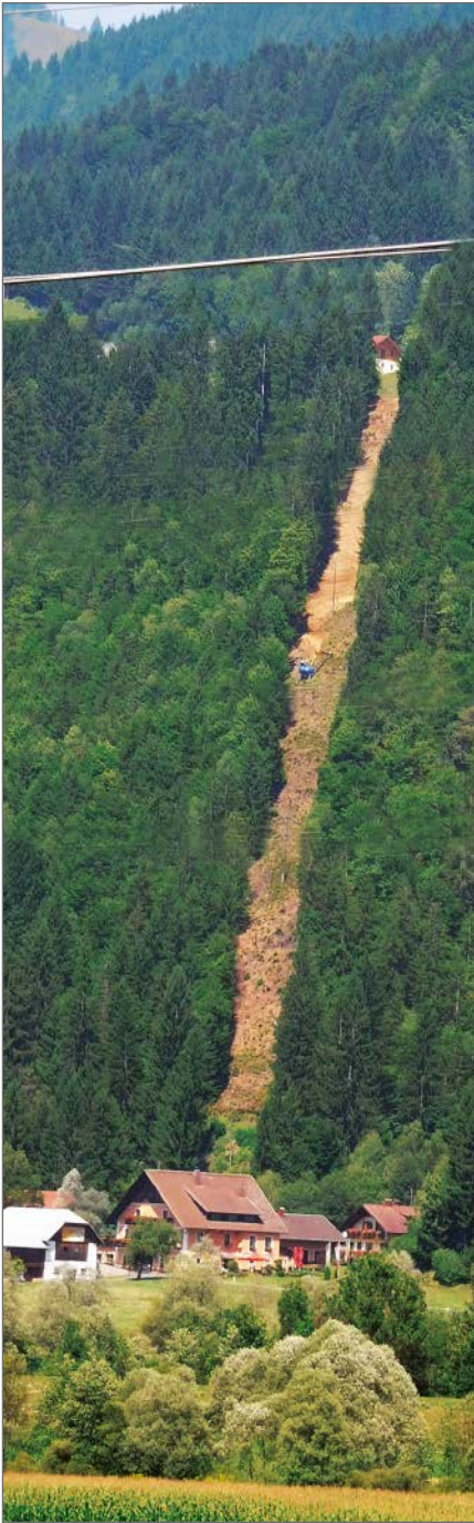
Der 1,5 km lange Abschnitt des Abwasserkanals im Steilhang. Dank der auffälligen blauen Farbe des Baggers ist dieser auf der Schneise durch den Wald erkennbar.
