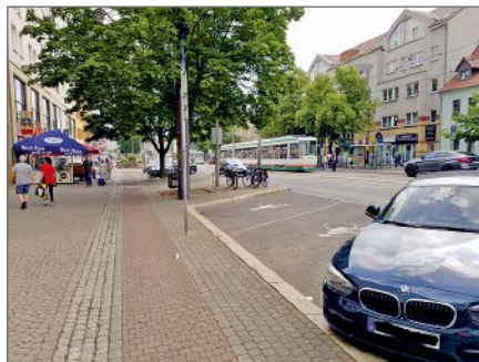
Die 2 bis 4-spurige Halberstädter Straße mit ihrem breiten Gehbereich, Radweg, Parkstreifen, Baumbestand, Straßenbahn und Busverkehr vor Beginn der Sanierungsarbeiten.
