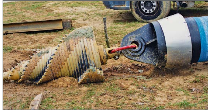
Anschluss des Aufweitungskopfes an den Rohreinzugskopf DN 600.
