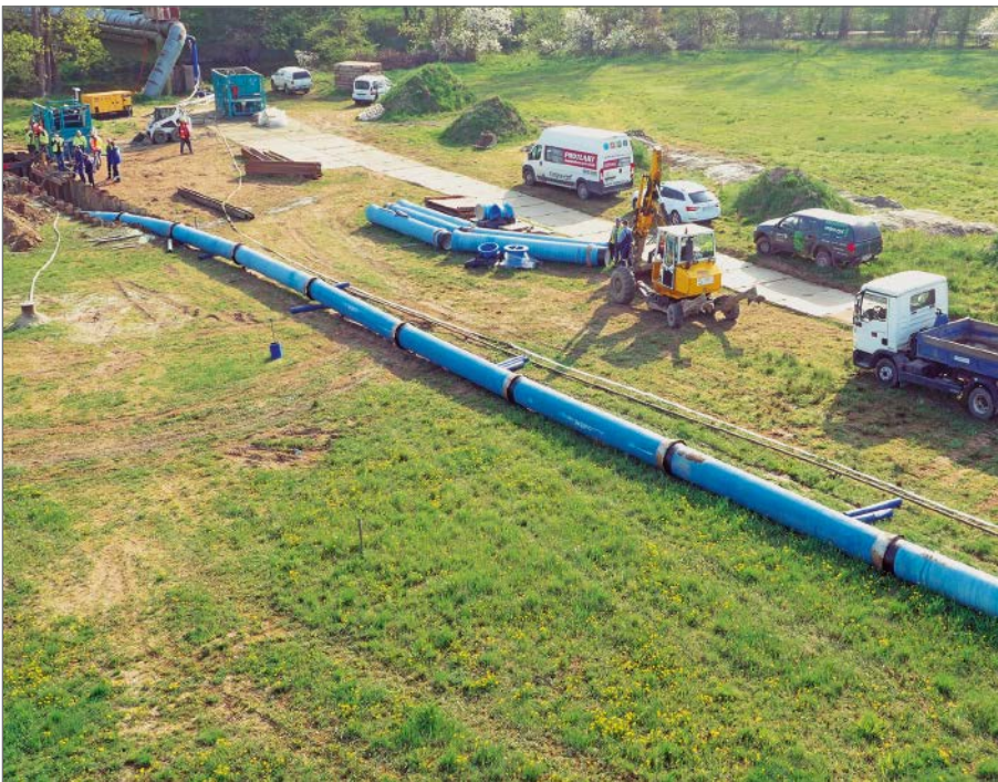
Der Rohrstrang wurde in einem Stück eingezogen.
