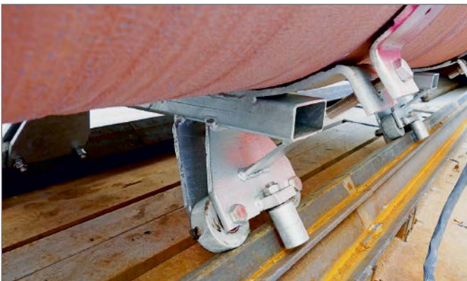
Auf vormontierten Schienen rollen die von der anderen Seite aus gezogenen Rohrschellen langsam durch den Tunnel.
