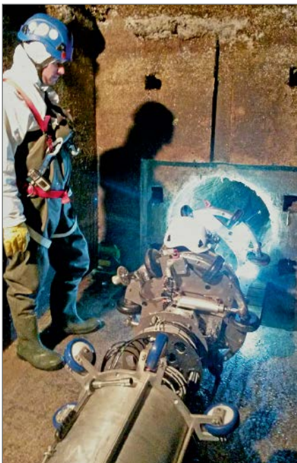
Positionierung des Scanners an der Dükeröffnung.
