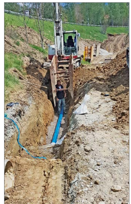
5.750 m Gussrohre der Tiroler Rohre GmbH wurden in den letzten drei Jahren eingebaut. Sie ersetzen die in die Jahre gekommenen Rohre aus PVC.
