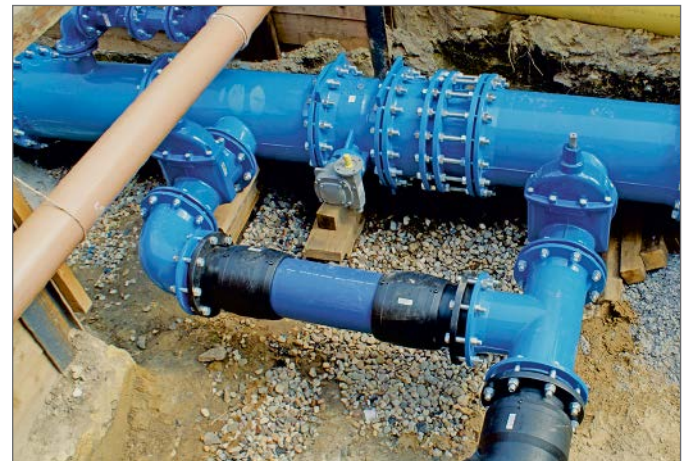
... sowie Abzweigen und Anschlüssen der Einbau in offenen Baugruben notwendig.
