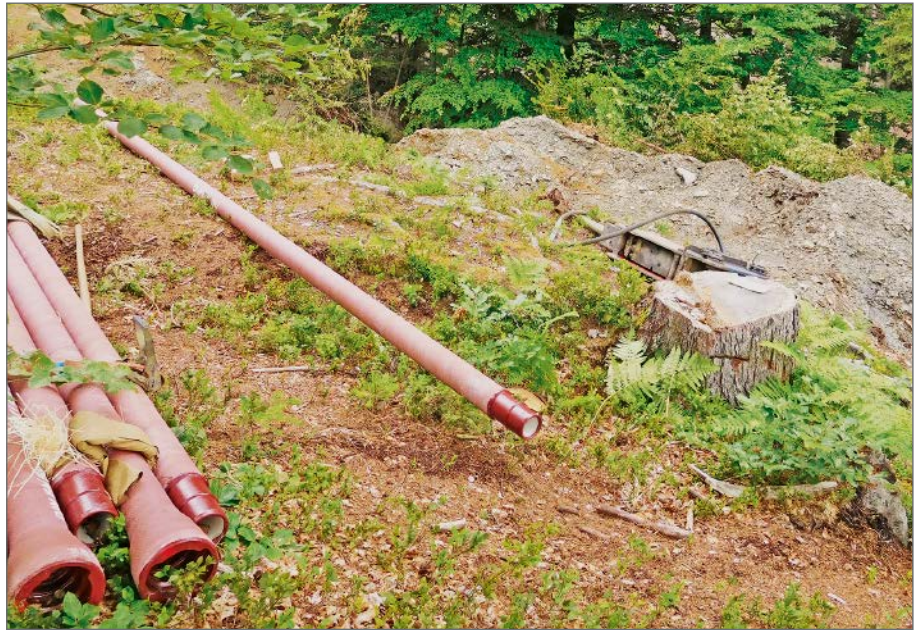
Duktile Gussrohre mit der längskraftschlüssigen VRS®-T Steckmuffen-Verbindung punkten zusätzlich mit der Abriebfestigkeit der Zementmörtel-Auskleidung (ZM-A), die sogar bei hohen Strömungsgeschwindigkeiten, wie sie bei Steilstrecken auftreten, gewährleistet ist.
