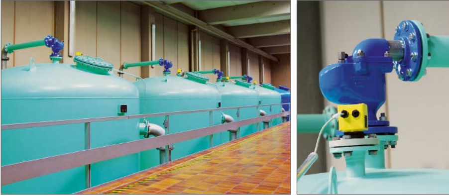
Behälter Einschichtfilter mit aufgebautem TWIN-AIR Be- und Entlüftungsventil.
