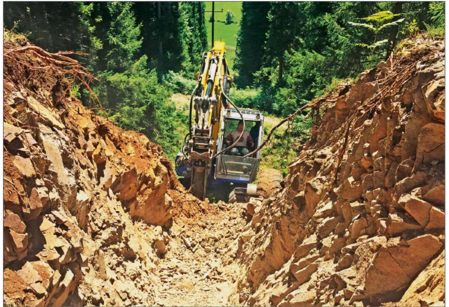
Die „Spinne“ erledigte nicht nur die Erdbauarbeiten, sondern transportierte auch die Rohre.
