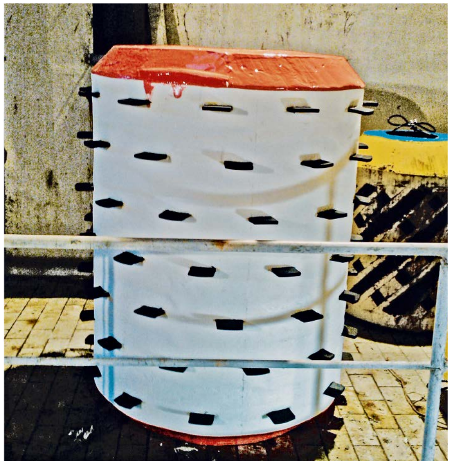
Sehr zeitaufwändig: Die intensive Rohrreinigung mit dem Molch (pro Rohr arbeitete das Team vier Tage im 24-Stunden-Betrieb).
