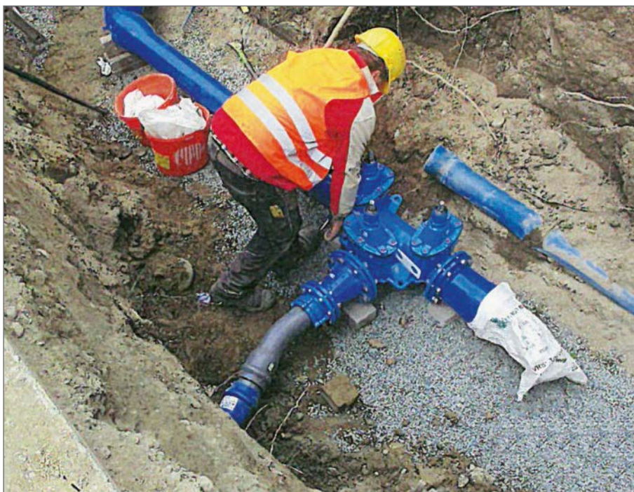
Einbau von Schiebern, Armaturen und Hydranten in das Leitungsnetz.
