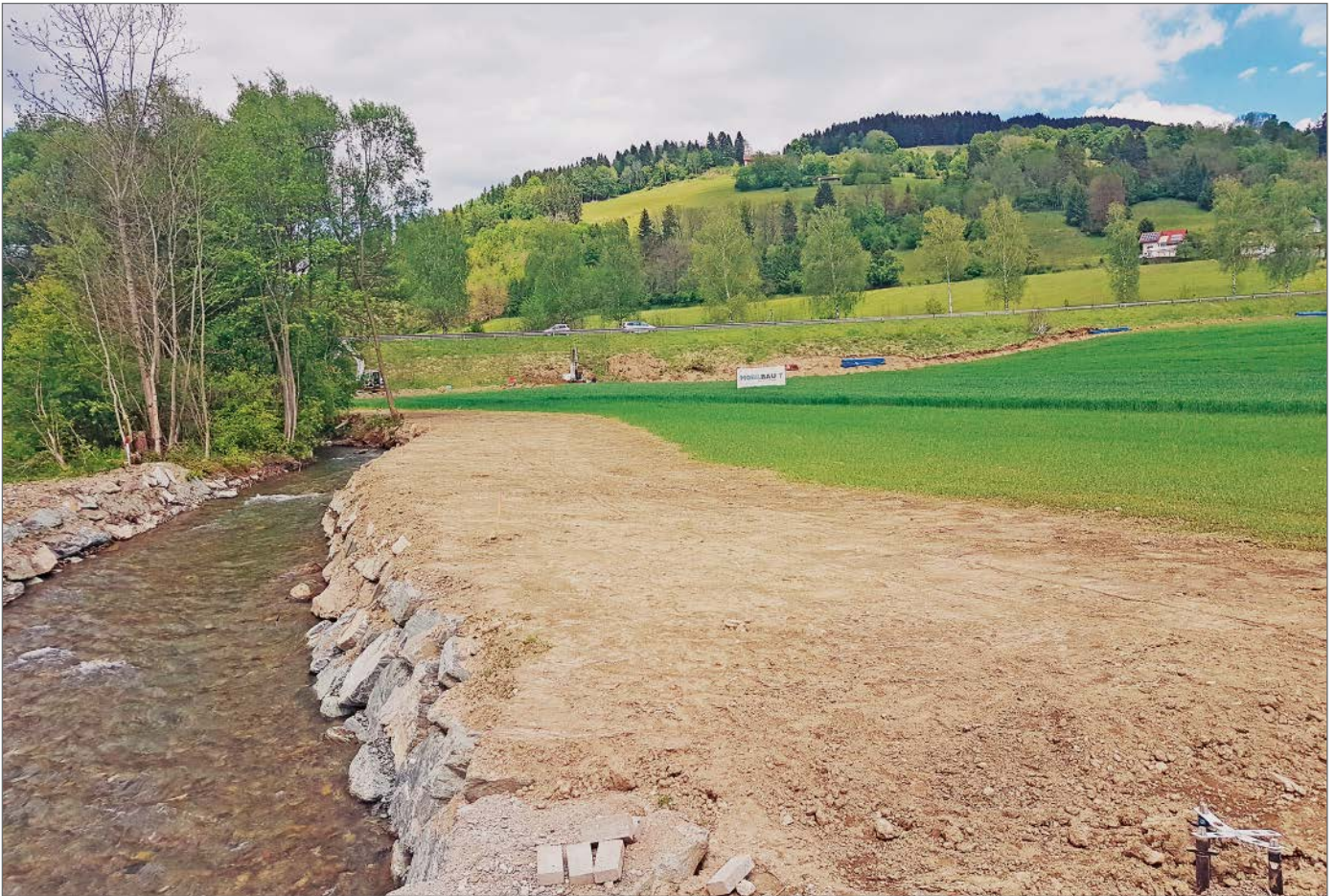
Einige Bachquerungen mussten im Zuge der Bauarbeiten durchgeführt werden. Problematisch war dabei der rasche Wasseranstieg in den Baustellen kurz nach Unwettern mit Starkregen.
