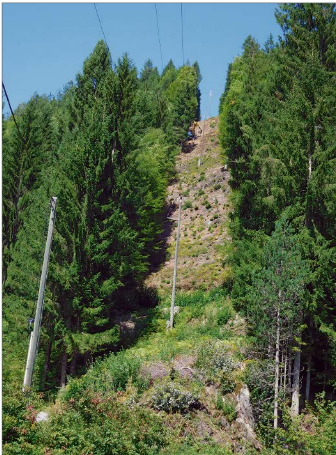
Um duktile Gussrohre vor äußeren Einflüssen zu schützen, wurden Rohre mit Zementmörtel-Umhüllung (ZM-U) eingesetzt. Eine Zuführung von herkömmlichem Bettungsmaterial war am steilen Hang nicht möglich.
