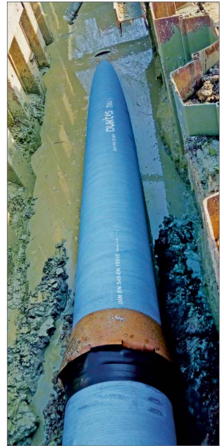
Einzug des Rohres in das Bohrloch.
