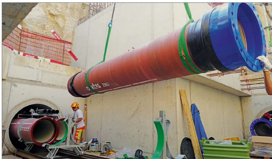
Auf der Einbauseite des Tunnels herrschten sehr beengte Platzverhältnisse. Im Bild: Montage eines Rohres auf die Transportschellen.
