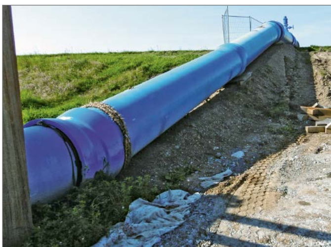
Verlauf der Interimsleitung DN 800 über den Deich zwischen Rohrbrücke über den Fluss Mulde und dem Wasserwerk Canitz
