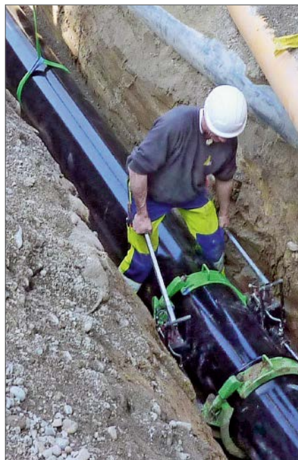
Einbau unter erschwerten Bedingungen bei Leitungsquerung
