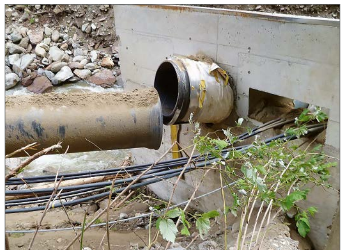
Nicht längskraftschlüssige Steckmuffen-Verbindung, die während der Unwetterkatastrophe herausgezogen wurde
