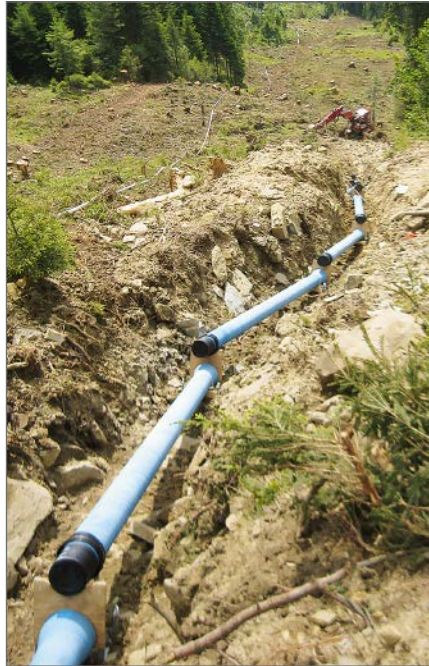
Duktile Gussrohre nach dem Einfliegen per Helikopter, vorbereitet zur Montage von unten nach oben
