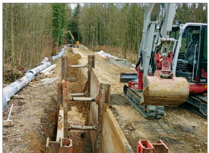
Leitungstrasse entlang eines Flurwegs
