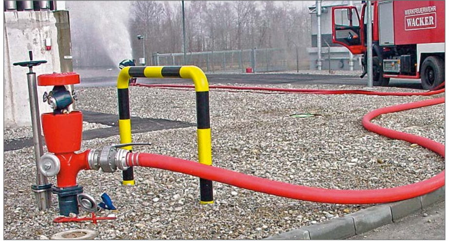
Industriehydrant für die Löschwasserversorgung in Industrieanlagen
