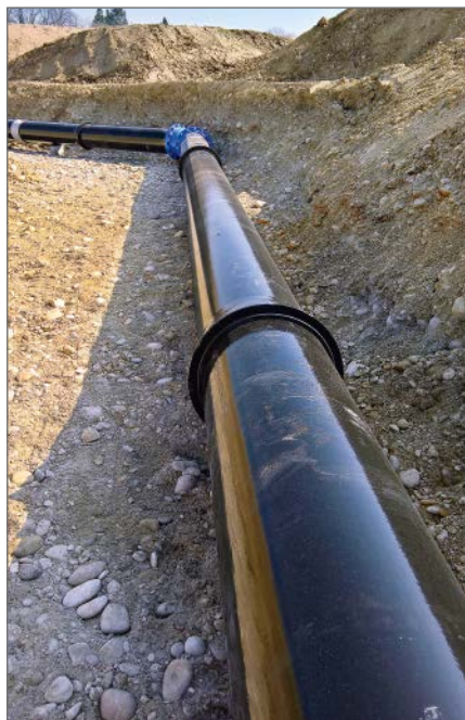
ECOPUR-Rohr DN 400 längskraftschlüssig gesichert mit Schubsicherung (Fig. 2807A)
