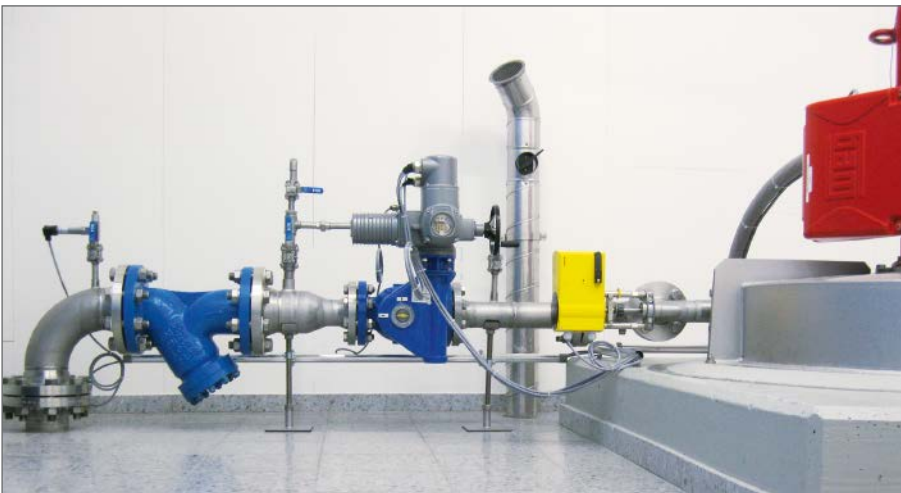
Anschluss der Turbinenleitung an die Turbine mit einem Schmutzfänger und einem Kugelhahn jeweils PN 64
