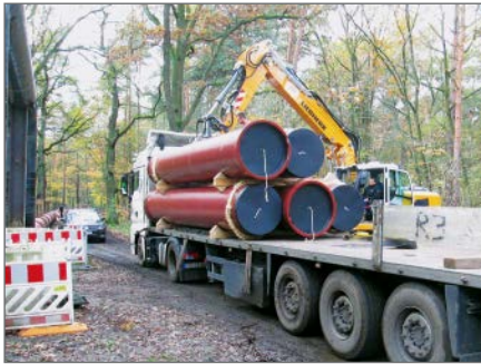
Die 6 m langen Rohre werden per LKW direkt auf die Baustelle geliefert
