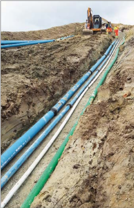
Einbau der duktilen Turbinen- und Versorgungsleitung im selben Graben
