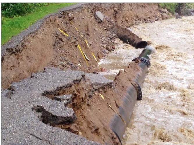
Neben einem Bachbett eingebaute Kraftwerksleitung, die zunächst freigespült wurde, worauf die nicht längskraftschlüssige Steckmuffen-Verbindung herausgezogen wurde.
