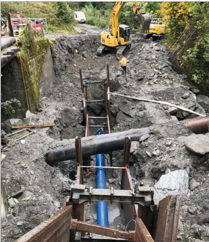
Die Unterdükerung im Rahmen der Bachquerung stellt eine Herausforderung dar.
