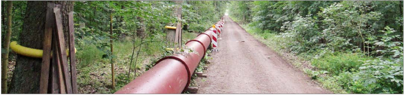
Umweltschonender und platzsparender Bau der Interimsleitung entlang eines Forstwegs
