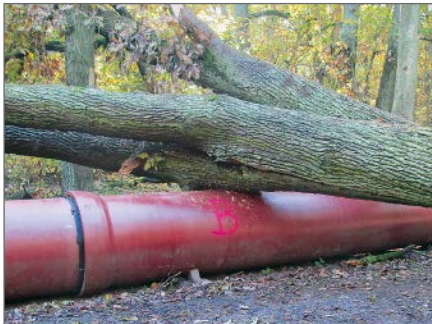
Eine entwurzelte Eiche, die auf die Interimsleitung gefallen war, hatte keine Betriebsstörung zur Folge
