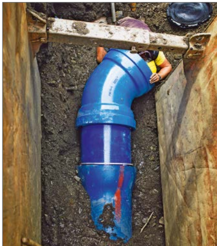
Beim Bau der Kraftwerksleitungen kommen auch Formstücke zum Einsatz.
