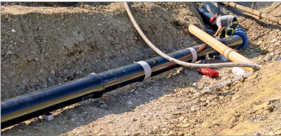
Erschwerte Montage der neuen Transportleitung DN 400 bei Unterquerung bestehender Werkleitungen
