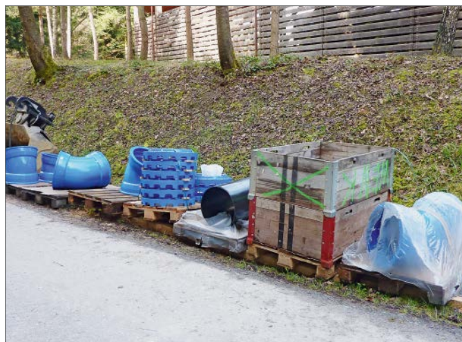
Formstücklager auf der Baustelle
