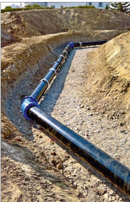
Umlegung einer Transportleitung DN 400 wegen eines neuen Kreisverkehrs
