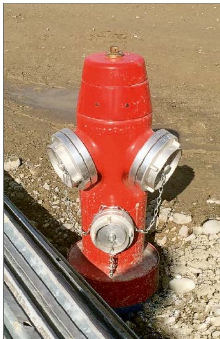
Hochleistungs-Industriehydranten vonRoll (Fig. 5530) mit seitlichen Abgängen Storz 110 mm und Zentralabgang Storz 75 mm
