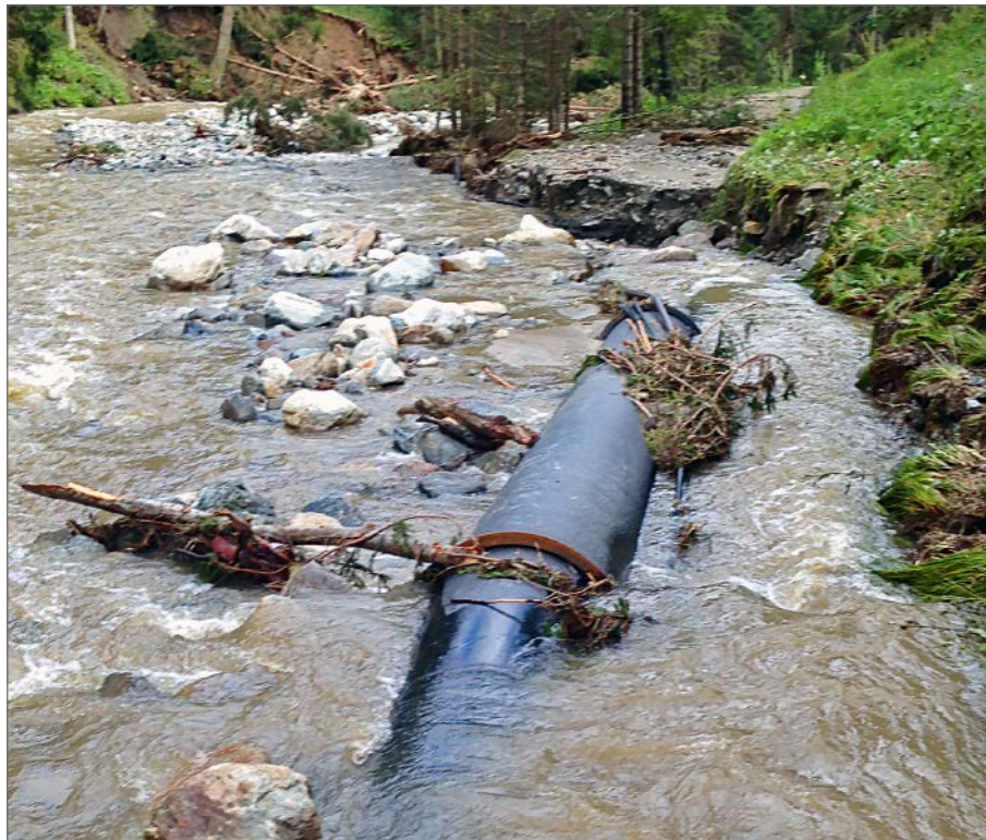
Die Unwetter im obersteirischen Sölkatal führten zur Zerstörung so mancher Druckrohrleitung. Herkömmliche, nicht längskraftschlüssige Steckmuffen-Verbindungen hielten den extremen Belastungen nicht stand.
