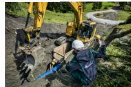
Zusammenbau der Druckleitung mit längskraftschlüssiger Steckmuffen-Verbindung VR5®-T im Leitungsraben
