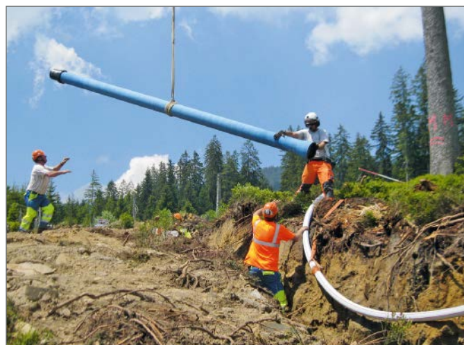
Einflug der Gussrohre DN 200 im steilen Gelände
