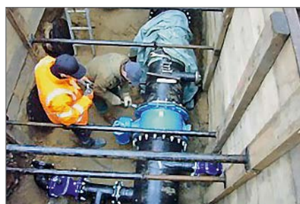
ROCO wave mit Losflansch senkrecht in einer Anlage oder als Rohrnetzarmatur
