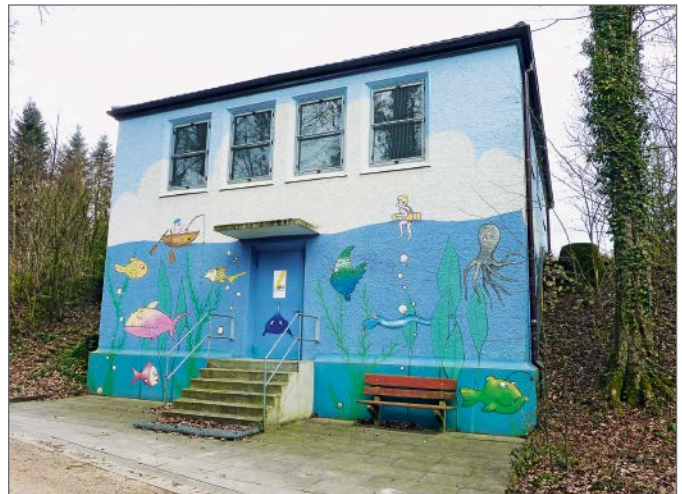
Betriebsgebäude des alten Wasserreservoirs Gönhard
