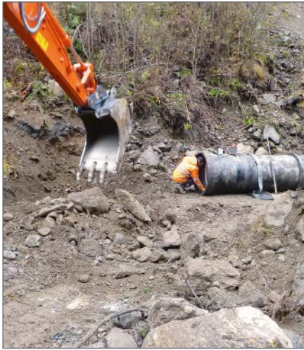
Nach dem Unwetter: Aufwändige Reparaturen zur Wiederherstellung der Druckrohrleitungen
