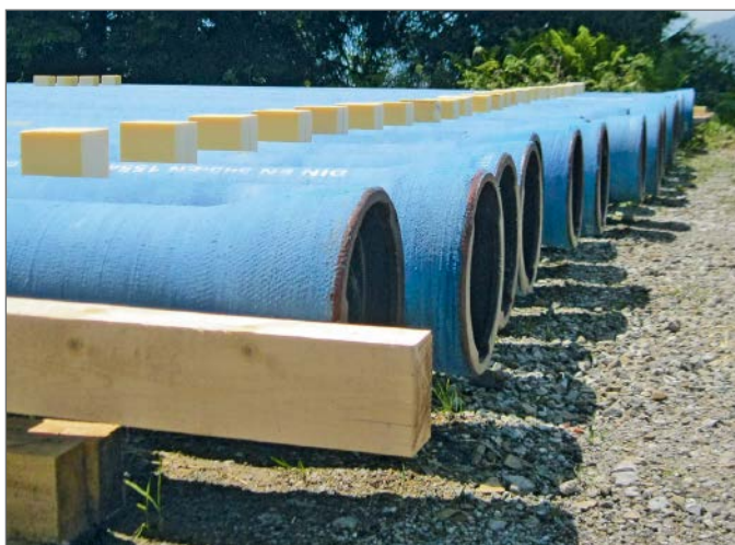
Lager mit duktilen Gussrohren bereit zum Transport und Einbau mittels Helikopter
