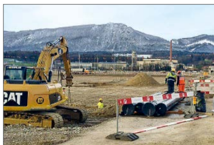
Blick nordwärts über das Bauareal Biogen Luterbach
