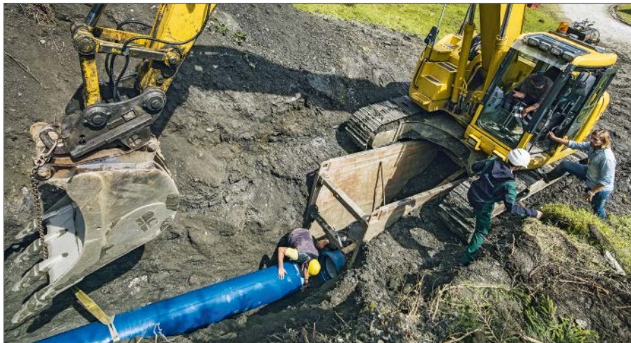
Der Baufortschritt ist beachtlich: 5 bis 6 duktile Gussrohre baut das Team von Rumpf Bau pro Tag ein.
