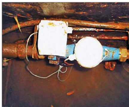
Fernauslesbarer Wasserzähler mit einem bidirektionalen 433 MHz Nahfunkmodul
