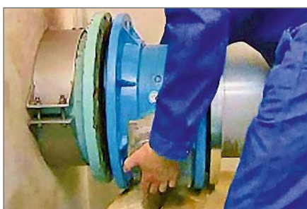
Einfachere Montage mit Hilfe des einseitigen Losflansches
