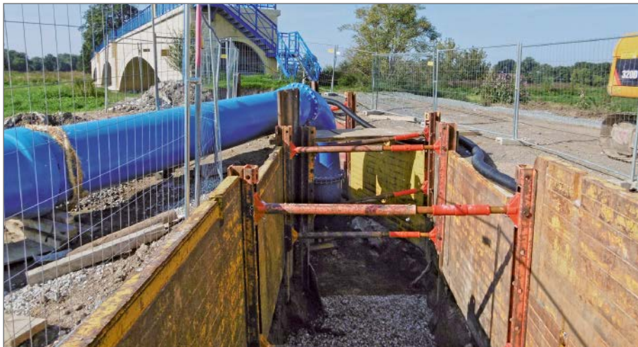
Baugrube mit abgehender Interimsleitung DN 800 an der Rohrbrücke über den Fluss Mulde
