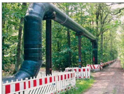
Rohrbrücke aus Stahlrohren zur Sicherstellung der Zugänglichkeit zum Forst
