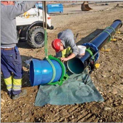
Vormontage eines Doppelmuffenbogens ECOFIT DN 400 außerhalb des Grabenprofils mit hydraulischem Verlegegerät
