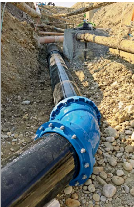
Doppelmuffenbogen DN 400 mit anschließender Unterquerung bestehender Werkleitungen
