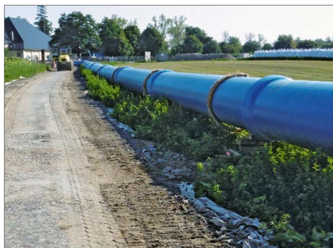
Geradliniger Verlauf der Interimsleitung entlang der Baustraße zum Wasserwerk Canitz
