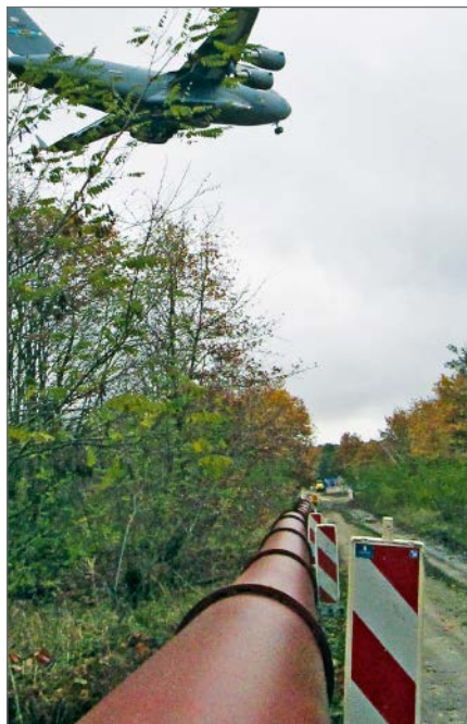
Interimsleitung entlang der Trasse der zu sanierenden Abwasserdruckleitung in der Einflugschneise des Flughafens Berlin Tegel
