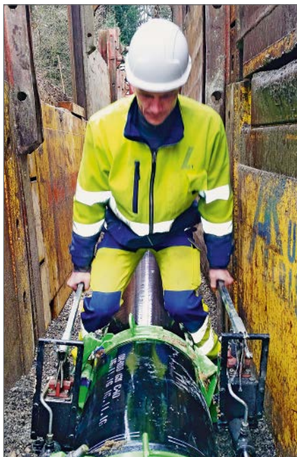
Montage einer HYDROTIGHT Steckmuffen-Verbindung mit hydraulischem Verlegegerät
