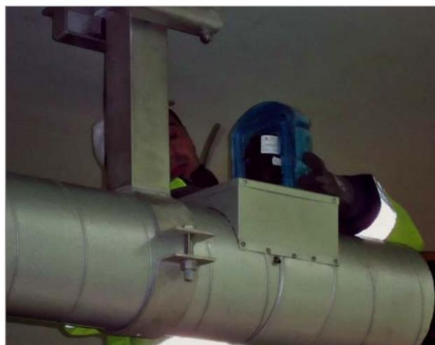
**Bild 10:** Werkseitig gedämmter 1,5"-IG-Abgang mit Absperrmöglichkeit und Entlüftungsventil mit Wärmedämmung
