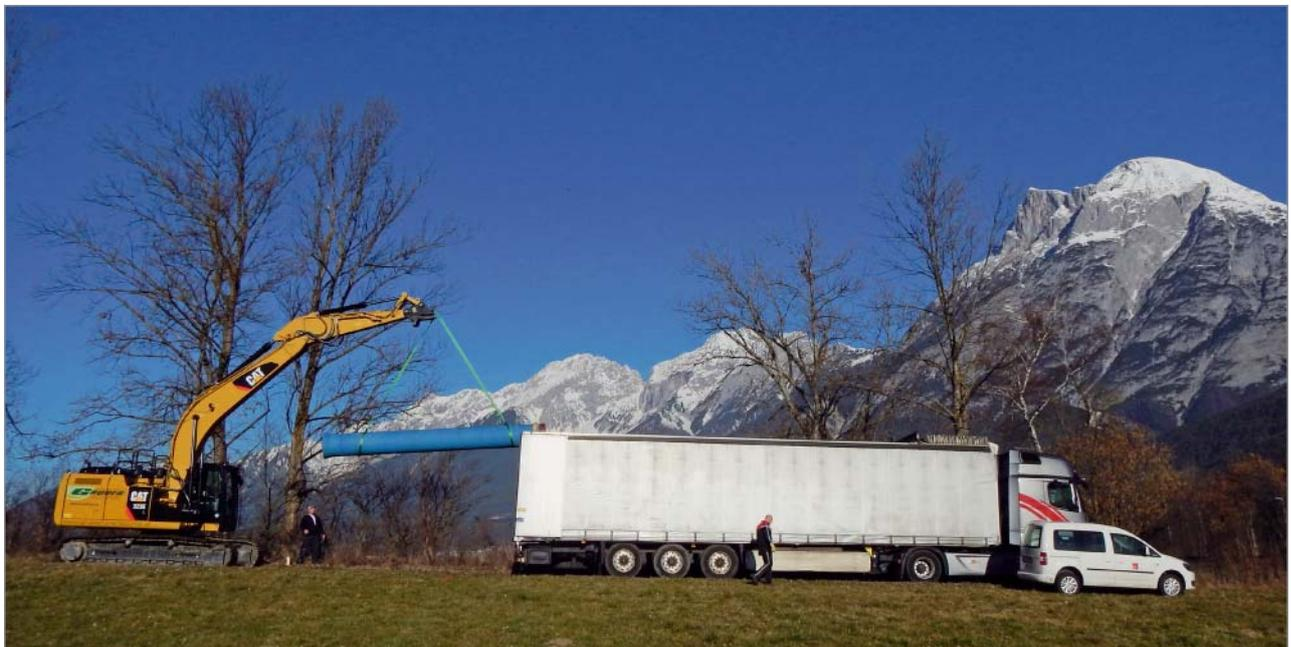
**Bild 1:** Anlieferung der duktilen Gussrohre für die Turbinenleitung des neuen Wasserkraftwerks am Kanzingbach (Tirol)
