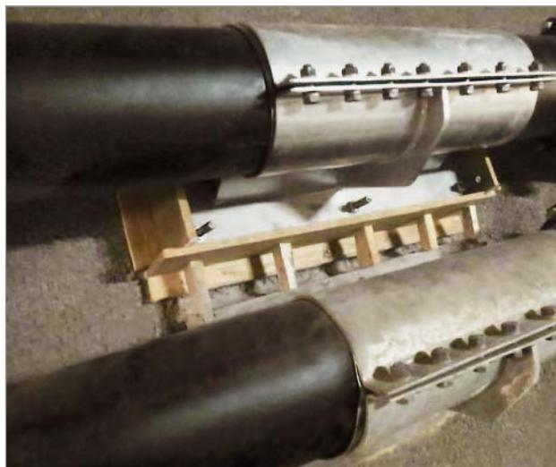
**Bild 8:** Abschaltung Fixpunktconsolen für das nachträgliche Hintergießen mit Fließmörtel
