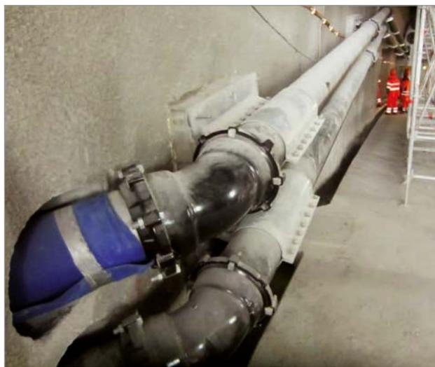
**Bild 7:** Wanddurchführung durch Stollengewölbe mit Fixpunktconsolen im Eingangsstollen Tierfehd
