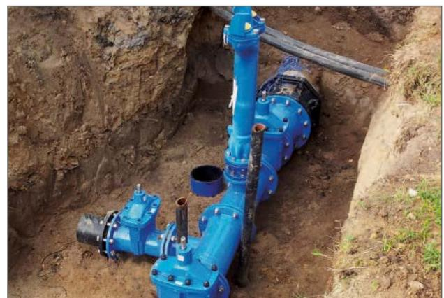
**Bild 3:** Einbau einer neuen Trinkwasserleitung DN 150
