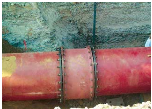
Bild 8: Zusammenfügen zweier Teilstücke mit Überschieber
