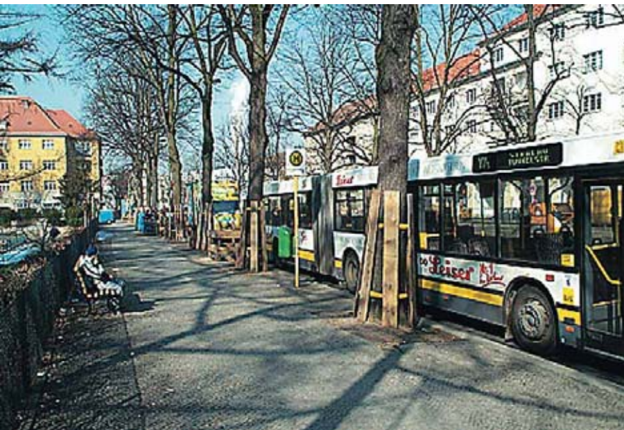
Bild 2: geschlossene Bauweise ohne Beeinträchtigung des Verkehrs
