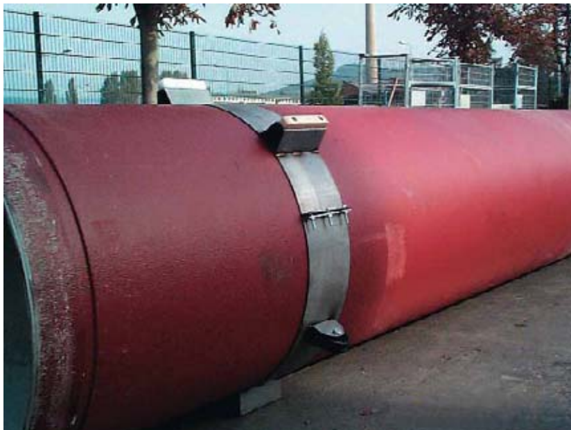
Bild 4: Rohreinzug auf Gleitkufen
