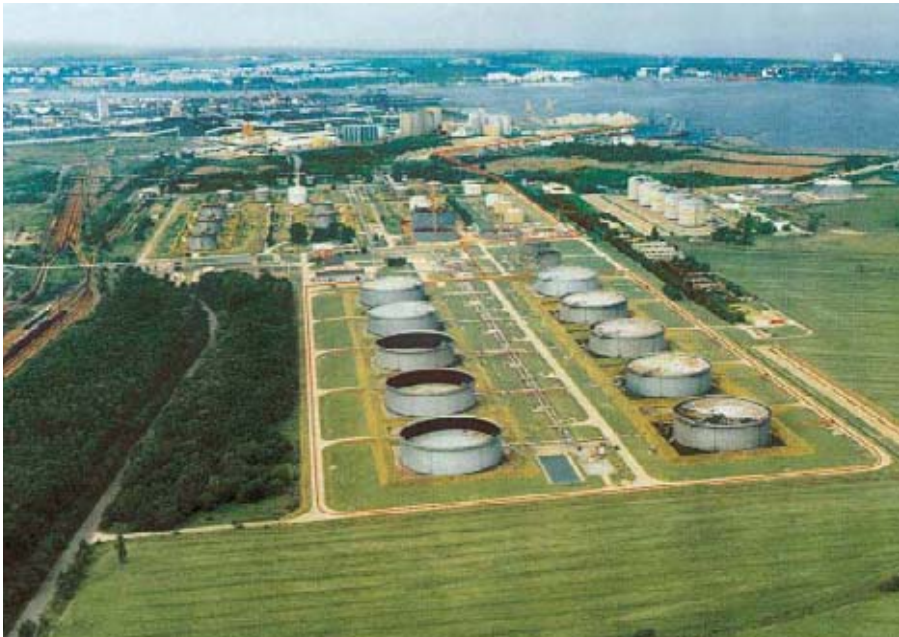
Bild 8: Löschwassersystem des Tanklagers und Ölterminals Rostock
