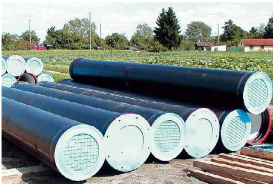
Bild 3: Die Baumaßnahme stellte hohe Anforderungen an das Material. Nach Prüfung aller Kriterien stellten duktile Gussrohre die einzige Lösung dar. (Bild: WWA Nürnberg)
