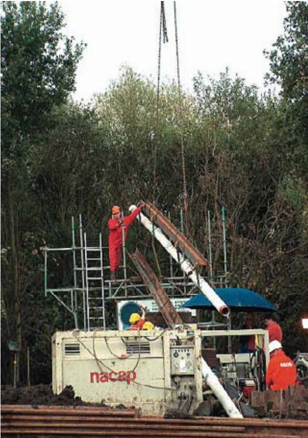
Bild 5: Mit einer Traverse werden die vormontierten Rohrstränge von jeweils drei Rohren auf die Einzugsschiene gehoben. (Foto: S. Buchholz)
