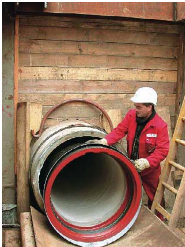
Bild 2: Muffe des zuletzt eingezogenen Rohres
