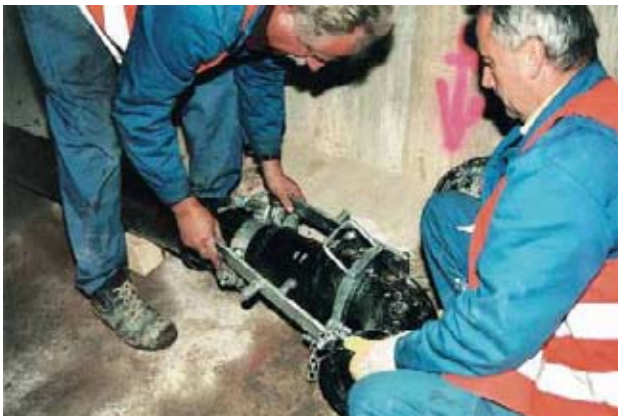
Bild 1: Einfache Montage mit Formstücken
