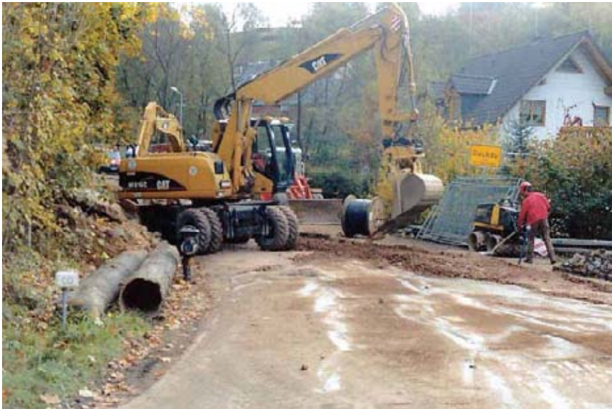
Bild 5: Ausbau der Stahlrohre
