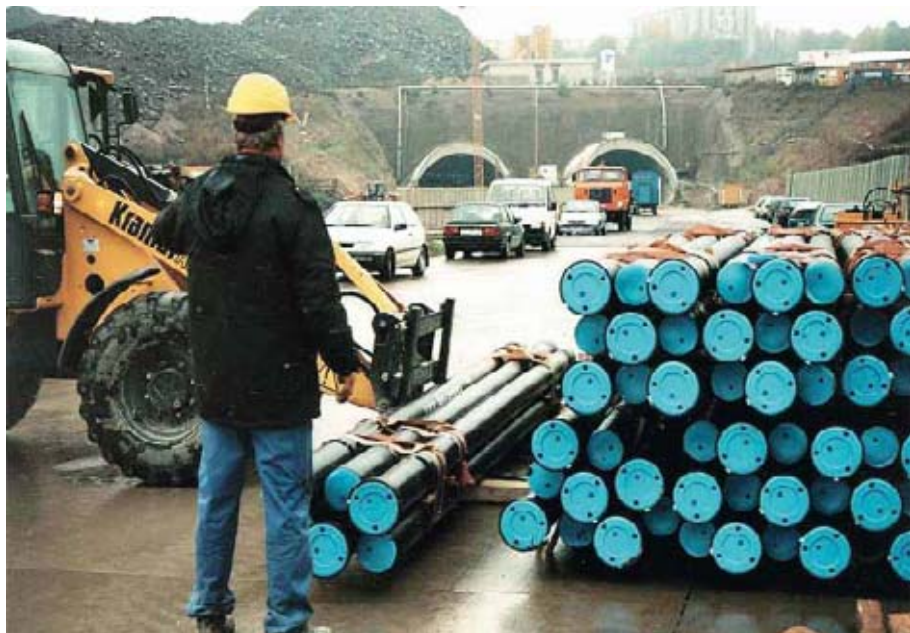
Bild 6: Rohre vor dem Portal des Autobahntunnels Dölz-schen
