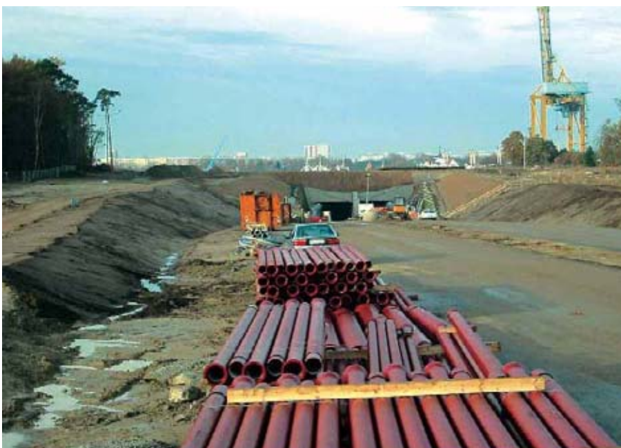
Bild 7: Rohre vor dem Warnowtunnel in Rostock
