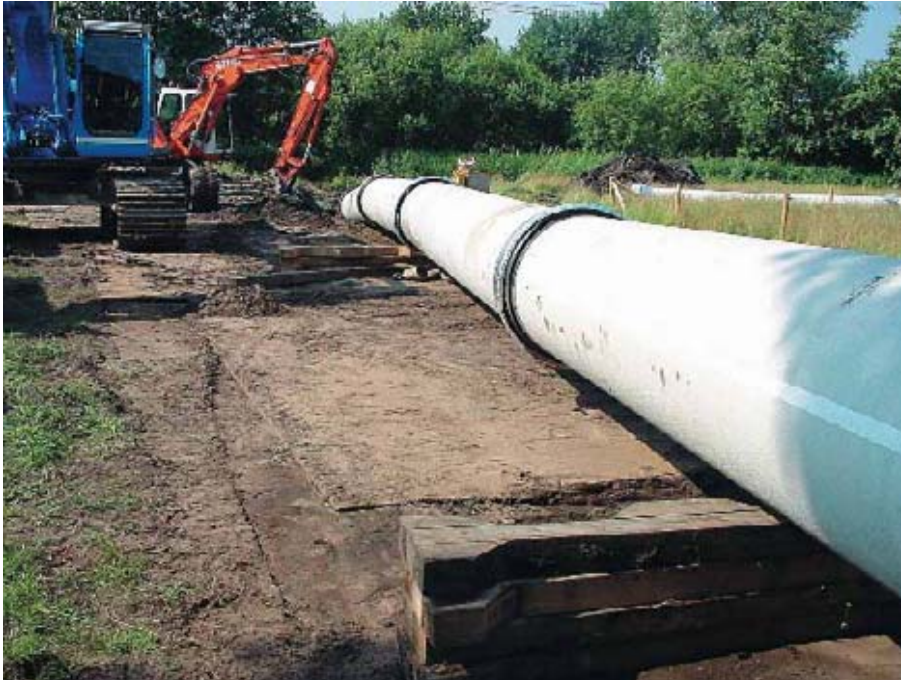
Bild 3: Der Rohrstrang wird mit einem Bagger über den Holzbock gehoben
