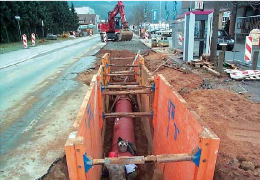
Bild 5: Kurze Baustelle in offener Bauweise
