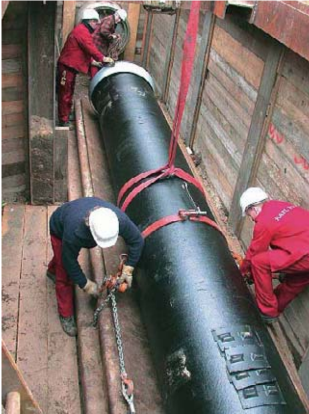
Bild 7: Montage der Rohrverbindung
