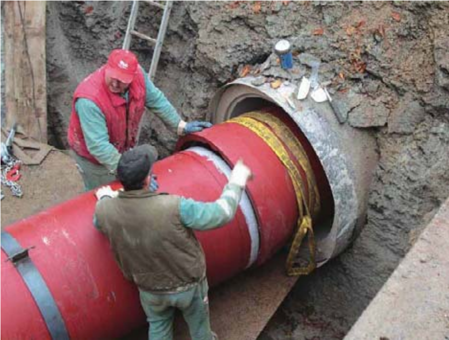
Bild 9: Rohreinzug mit zugfester Verbindung TKF DN 900
