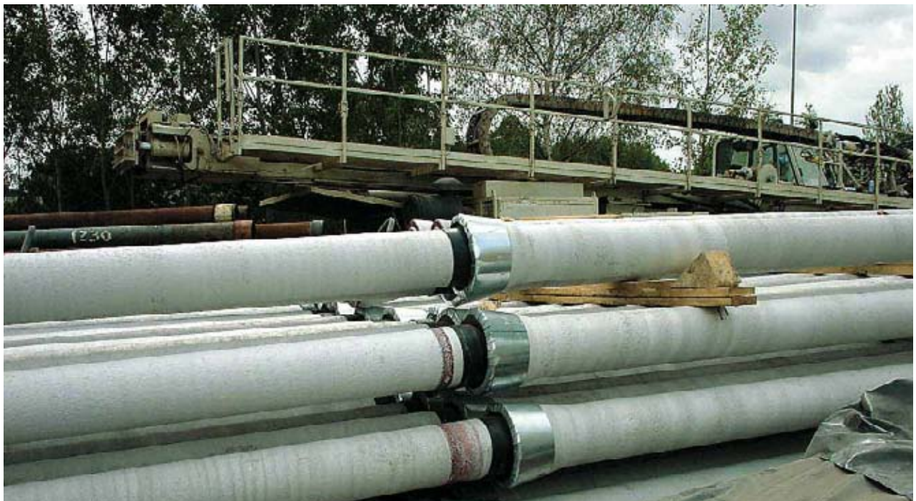
Bild 4: Lagerung der vormontierten Rohrstränge
