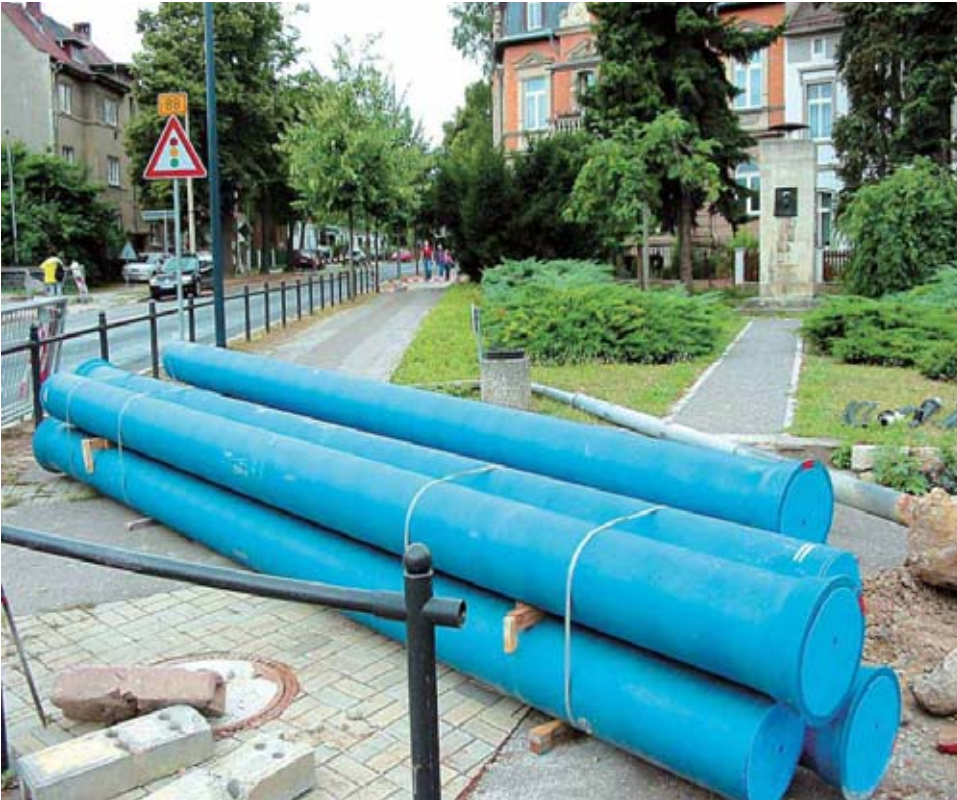
Bild 3: Rohre vor dem Einbau
