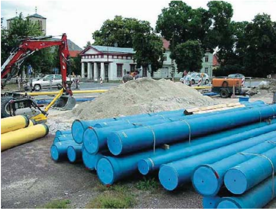
Bild 4: Baustelle am Salztor
