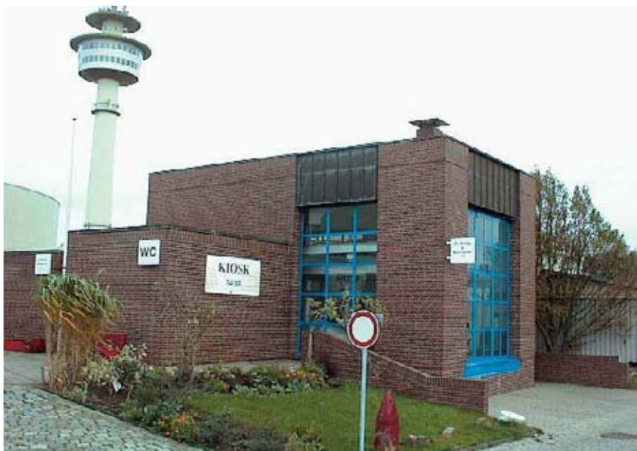
Bild 1: Vereinigungsbauwerk für Druckrohrleitungen Hauptpumpwerk und PW-Borriesstraße
