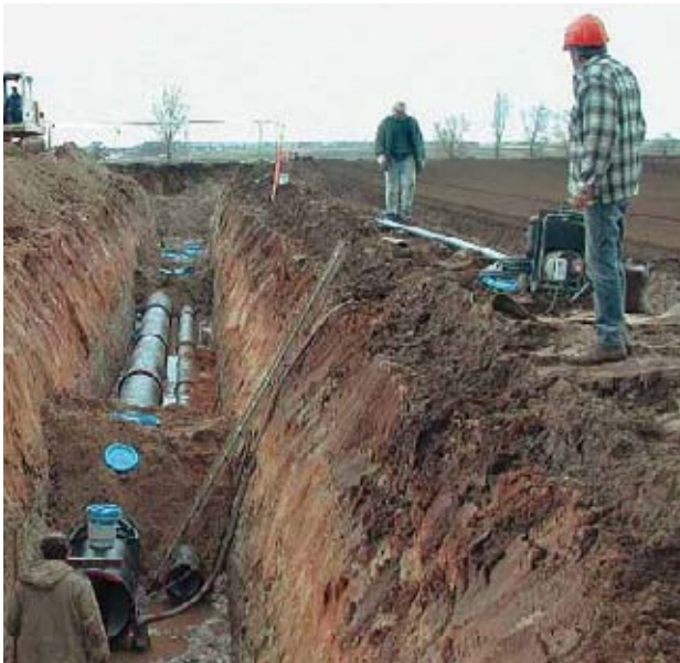
Bild 6: Durch den Verzicht auf den Einbau einer Sandbettung konnte Zeit und Geld gespart werden. (Bild: WWA Nürnberg)
