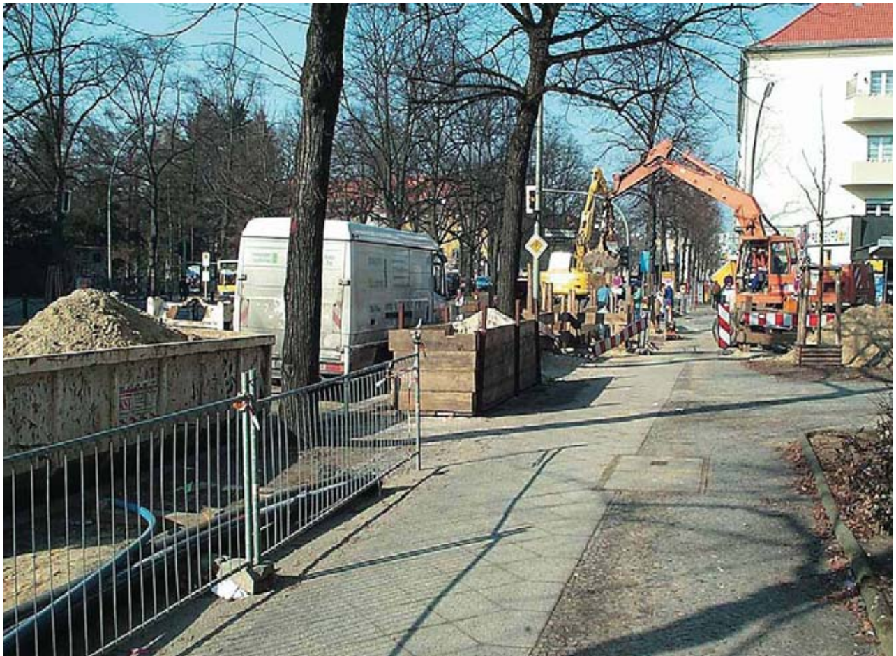
Bild 1: Platzbedarf und Verkehrsbehinderungen bei der offenen Bauweise
