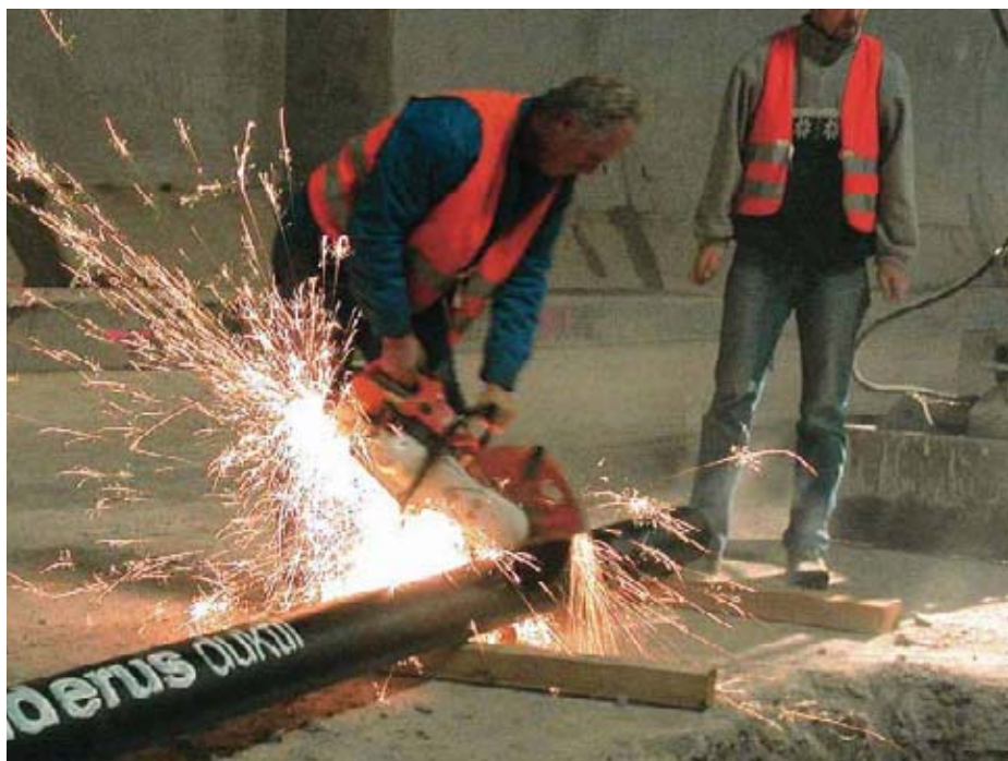
Bild 2: Ablängen eines Rohres
