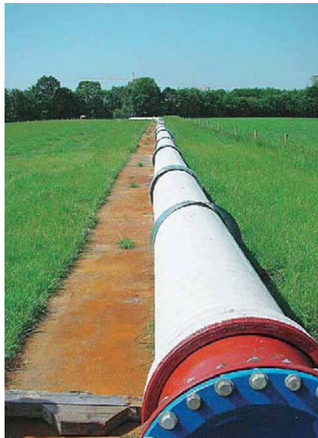
Bild 2: Rohrstrang vor dem Einziehen
