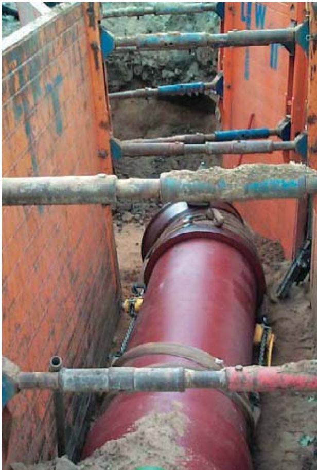
Bild 7: Enge Leitungsführung zwischen zwei Kanälen
