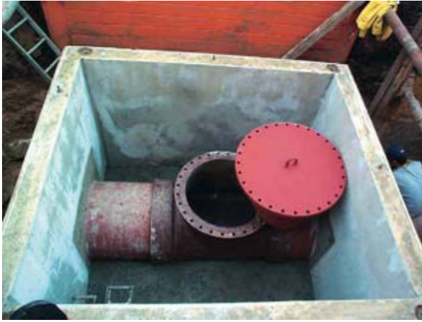
Bild 3: Reinigungsformstück mit Totraumverschluss
