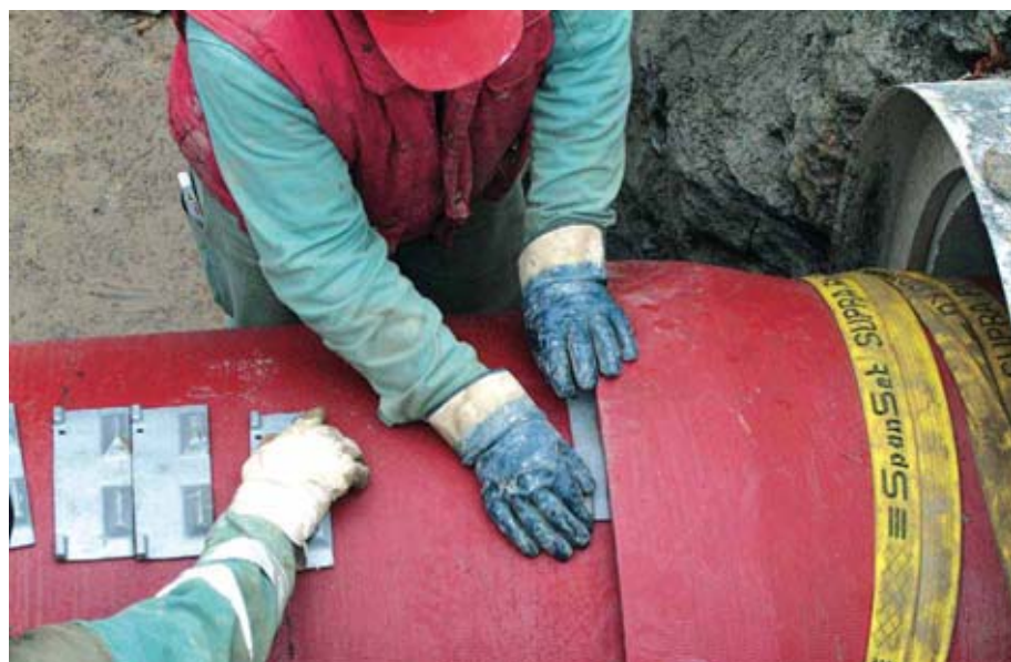
Bild 10: Montage der TKF-Verbindung
