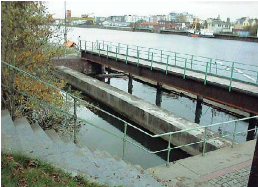
Bild 2: Schleuse Neuer Hafen mit kreuzender Druckleitung
