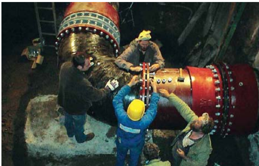
Bild 5: Umschlussarbeiten, oben neue Leitung DN 900; rechts Altleitung DN 1.000
