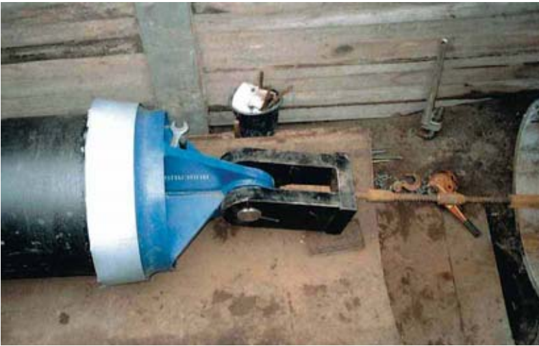
Bild 5: Einzug des ersten Rohres
