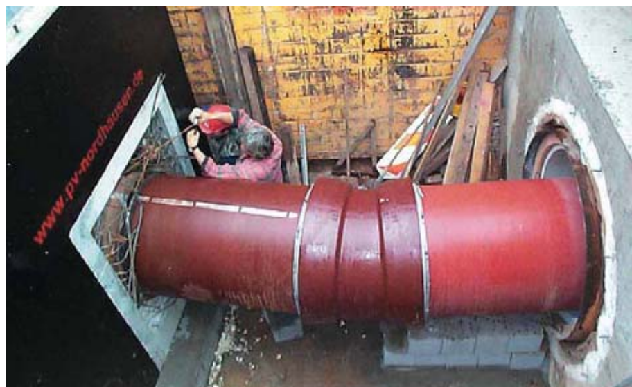
Bild 6: Winkelpunkt mit Muffenbogen
