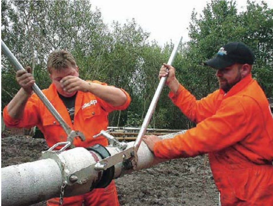
Bild 3: Schnelle Montage der TIS-K-Verbindung synchron zum Wechsel des Zuggestänges
