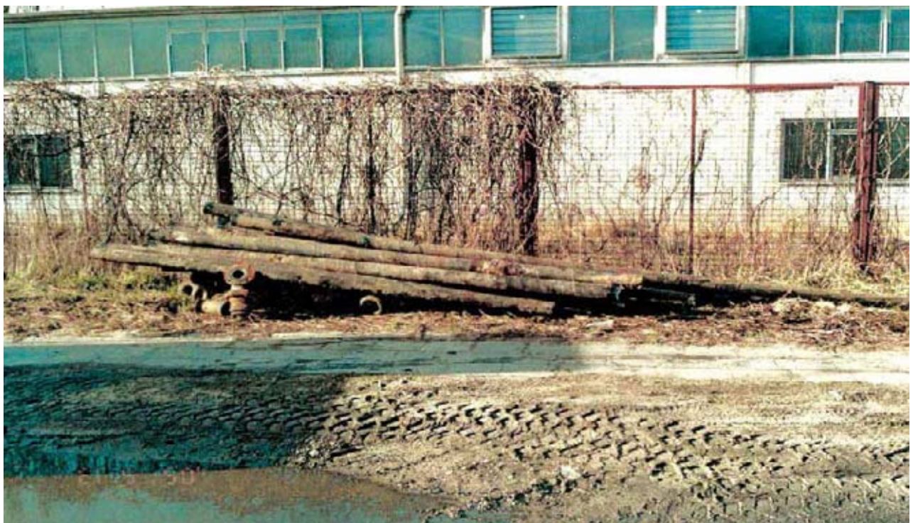
Bild 5: Alte Stahlrohre in ganzer Länge nach dem Ausbau
