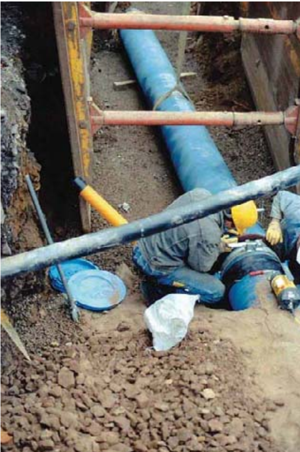
Bild 7: Einbau der neuen Rohre DN 400 aus duktilem Gusseisen
