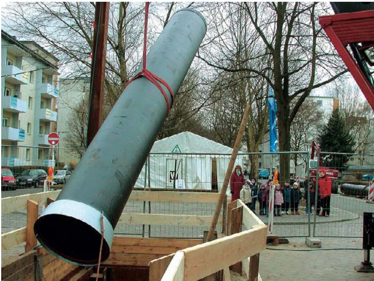
Bild 6: Ablassen eines Rohres in die Rohrbaugrube
