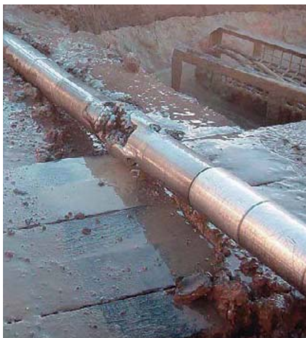
Bild 2: Die beiden Bohrköpfe der Pilotbohrung erreichen die Zielbaugrube. (Foto: R. Stutzki, HSE)
