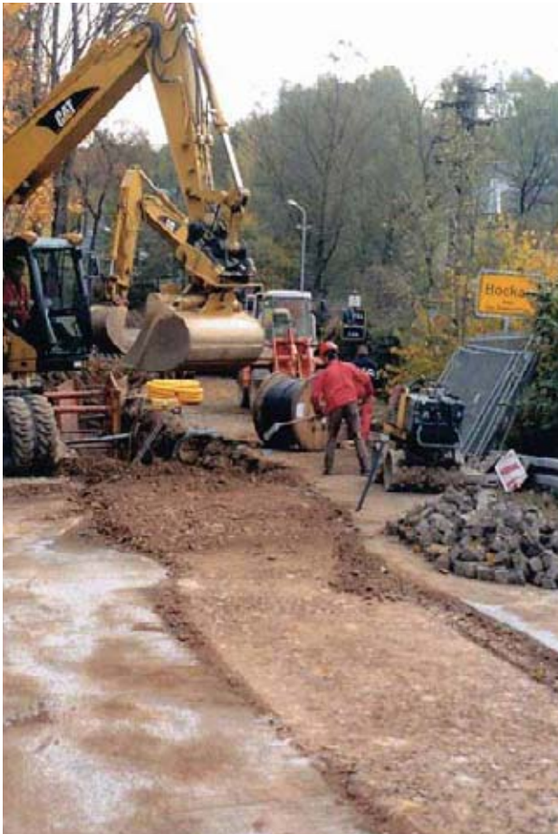
Bild 8: Nach dem Einbau der neuen Rohre DN 400 sofort wieder verfüllter Rohrgraben
