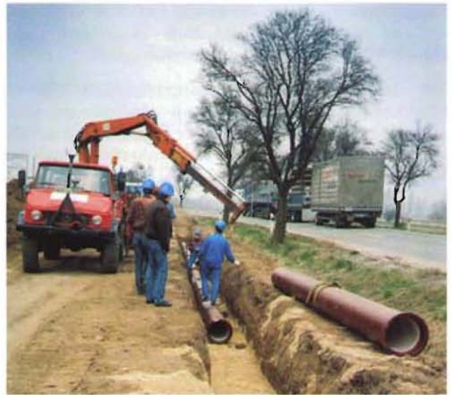
Bild 7: Rohrtrasse kurz vor der Einbindung in die Kläranlage Pfütztal bei einer Verlegetiefe von 1,5 m
