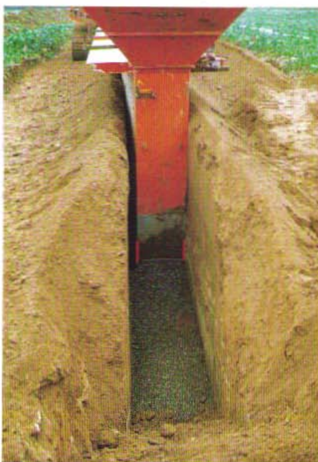
Bild 5: Herstellen des Rohrauflegers
