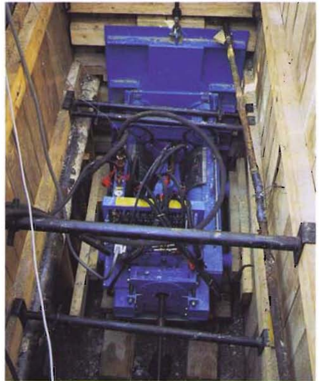
Bild 3: Zieheinheit im Graben
