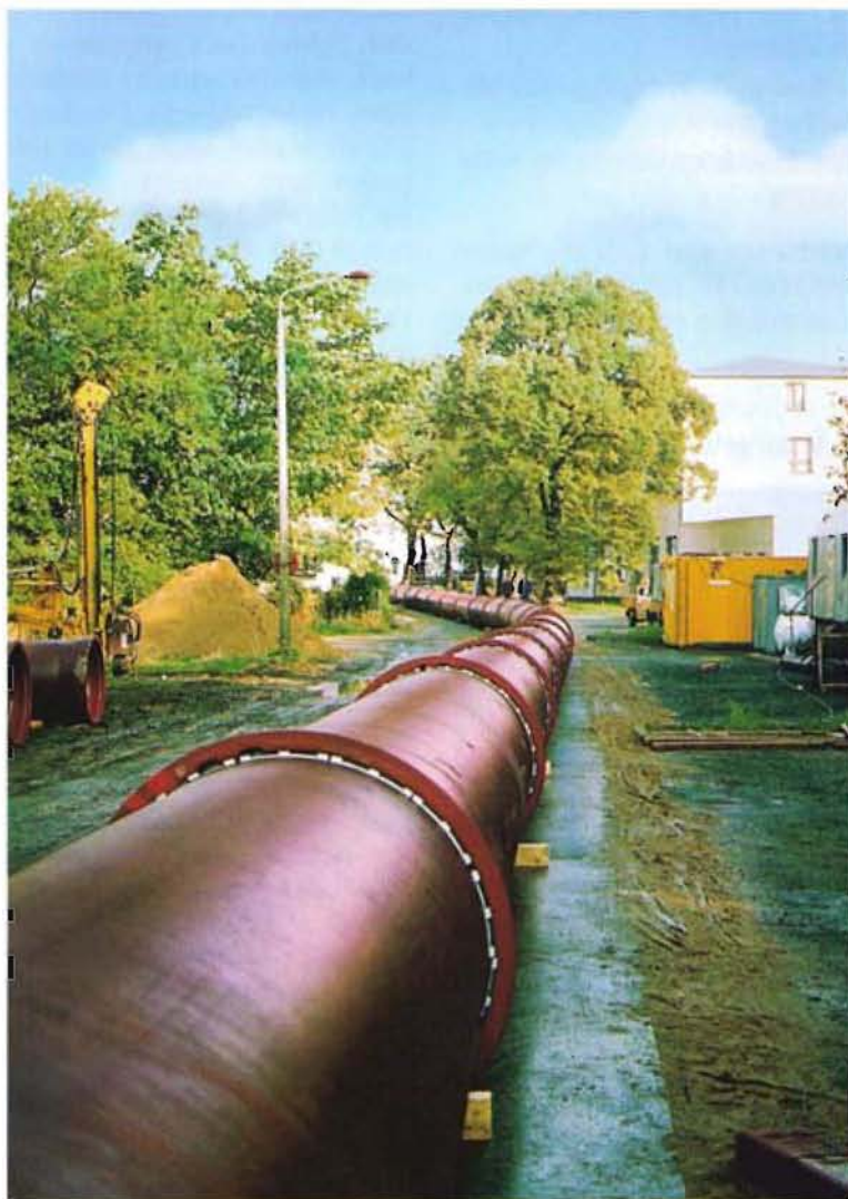
Bild 5: Zusammenbau des Rohrstranges auf dem Feldweg
