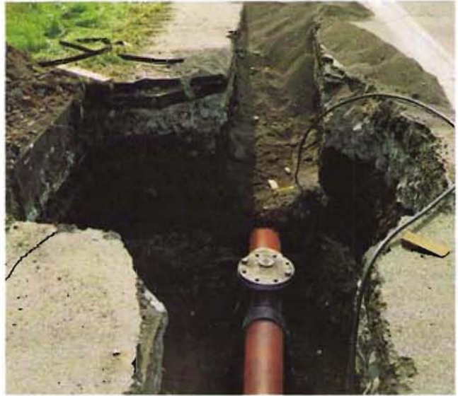
Bild 5: Revisionsöffnung im Seitenstreifen
