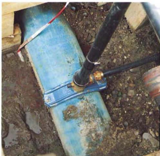
Bild 8: Anbohrung mit Spezialanbohrarmatur auf dem gezogenen Rohr
