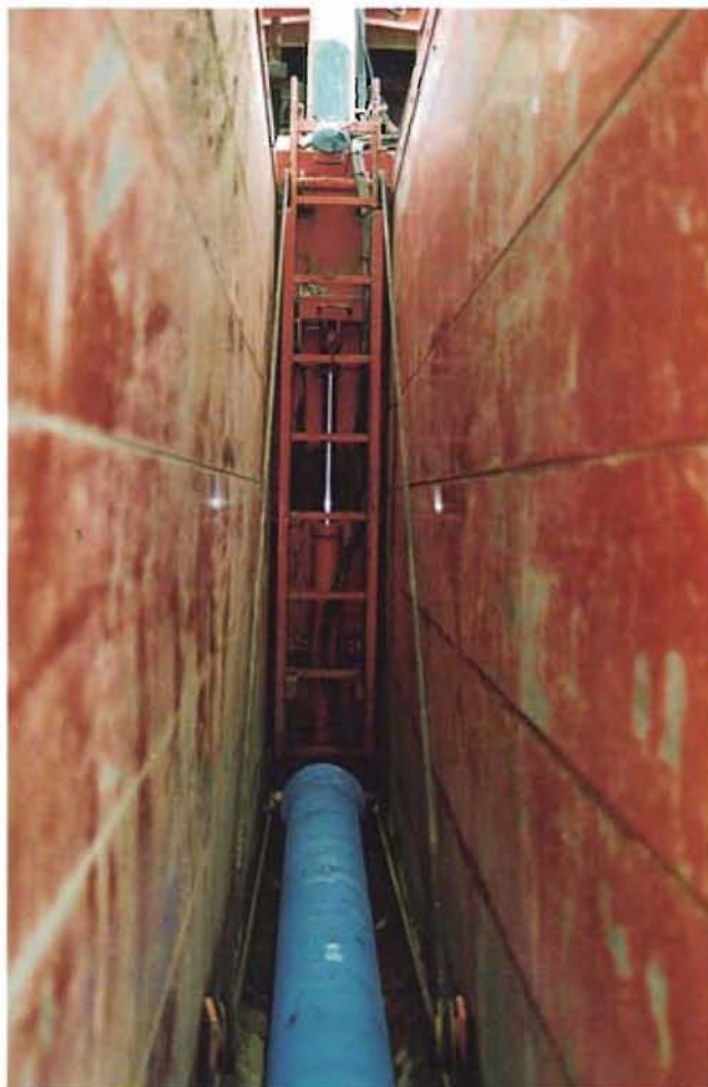
Bild 3: Ablegen der Gußrohre auf Führungsschienen
