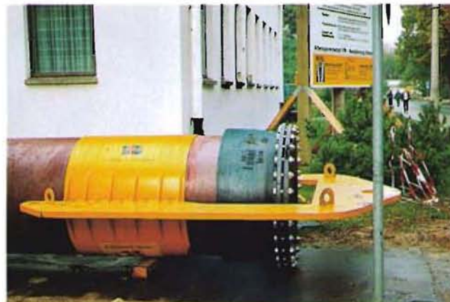
Bild 6: Verschluss mit Ziehkopf
