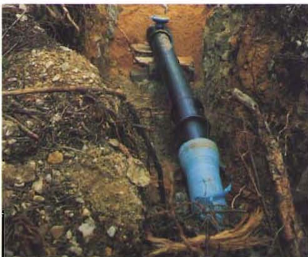
Bild 5: Vertikal-Bogen und Flanschanschluß für Lüfter
