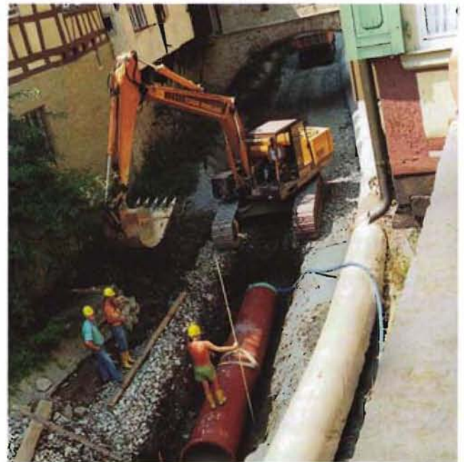
Bild 5: Verlegearbeiten am Malerwinkel
