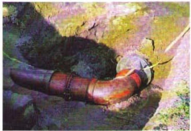
Bild 4: Straßenquerung, Rohrdurchführung im Schutzrohr
