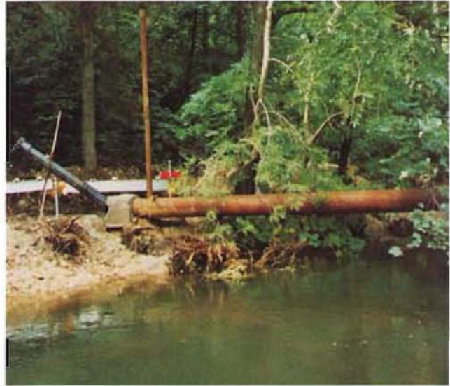
Bild 8: Düker aus duktilem Gußrohr im Schutzrohr aus Stahl, mit Zementmörtel verdämmt
