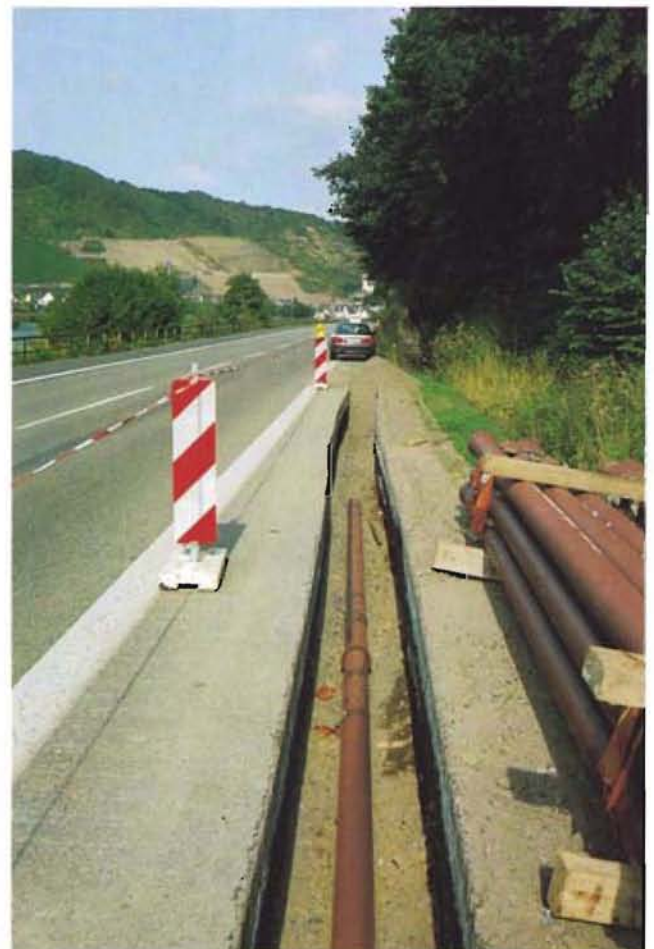
Bild 4: Gefräster Graben mit DN 150 GGG
