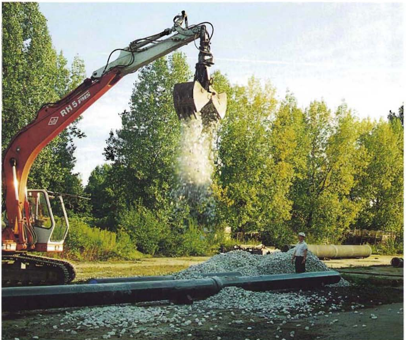
Bild 1: Schlagbelastungstest durch Aufschütten von Schotter
