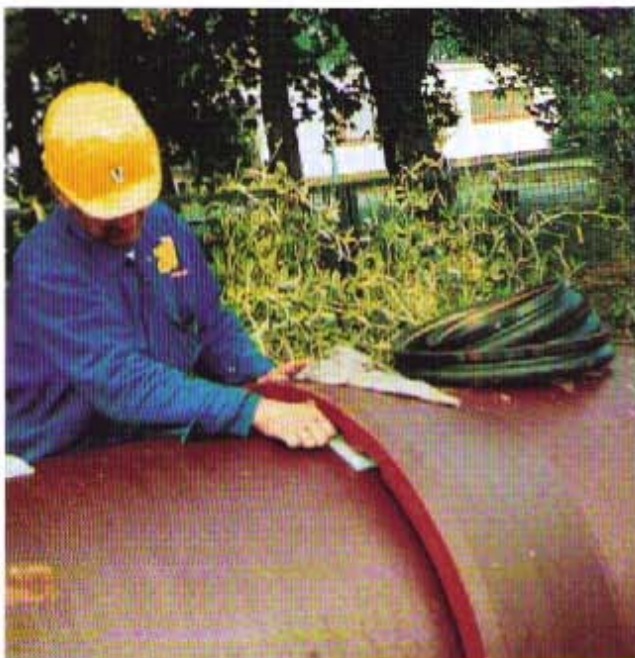
Bild 3: Einschieben der Verriegelungssegmente
