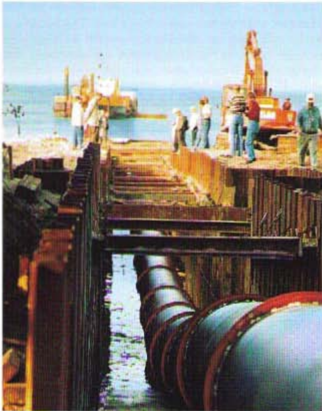
Bild 7: Abwinkelung der Verbindungen beim Einziehvorgang im Bereich des Höhenunterschiedes
