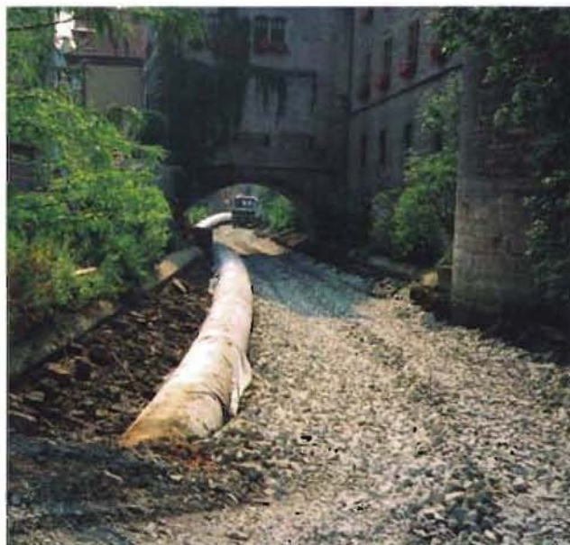
Bild 8: Fahrspur im trockengelegten Bachbett des Breitbaches
