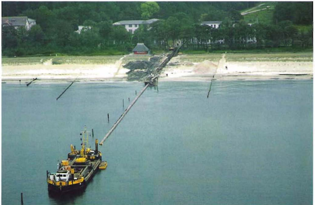
Bild 10: Luftaufnahme des Einziehvorganges
