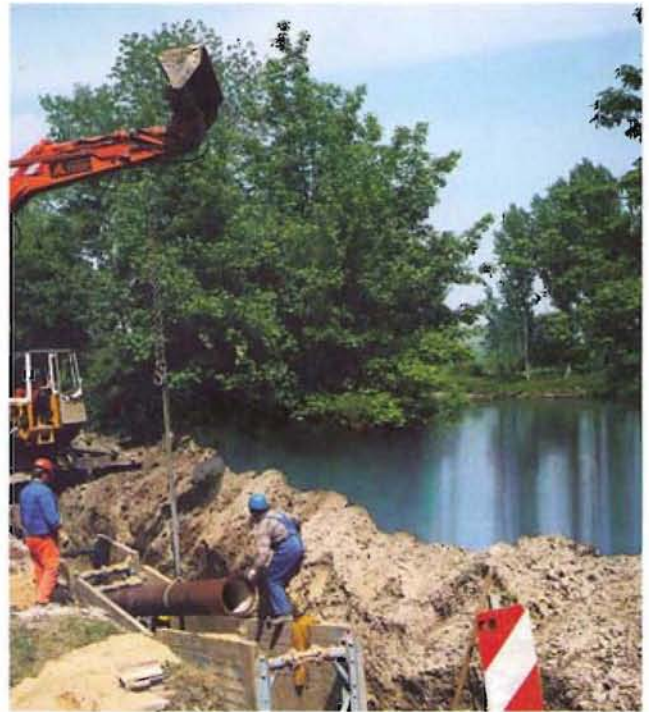
Bild 2: Rohrtrasse im beengten Bauraum bei größtmöglicher Umweltschonung. Abstand zum Saale-Ufer ca. 5m
