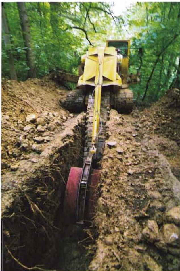
Bild 4: Grabenfräse im Einsatz
