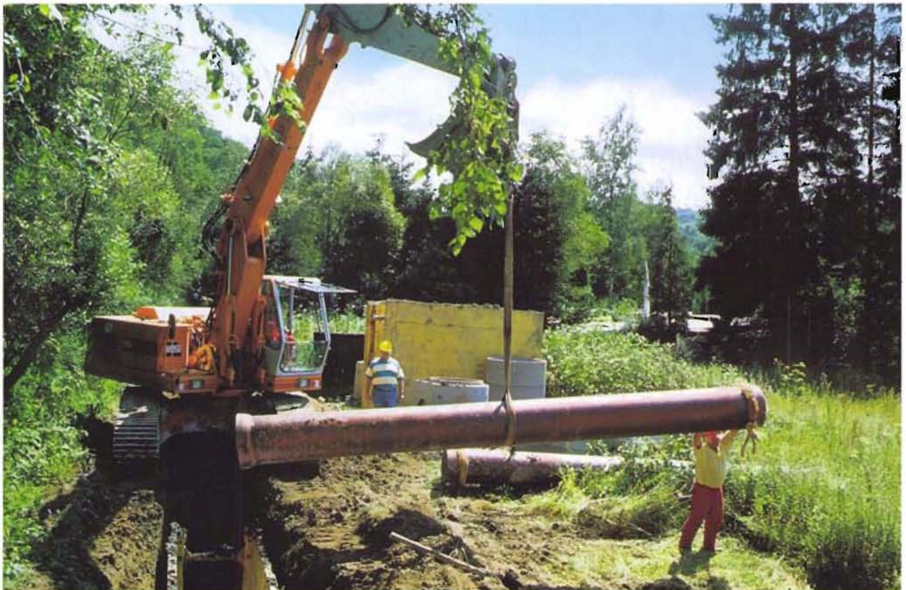
Bild 2: „Der Vor-Kopf-Einbau erwies sich ...“
