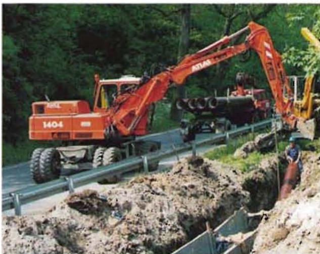
Bild 6: Einfädeln einer 6 m-Gußrohrlänge: problemloser, als oft diskutiert
