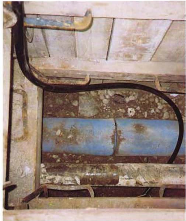
Bild 9: Gezogener Rohrstrang in einer Zwischenbaugrube
