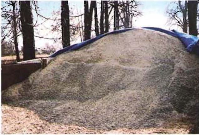
Bild 2: Bevorratung des fertigen Mischgutes zur mineralischen Kapselung
