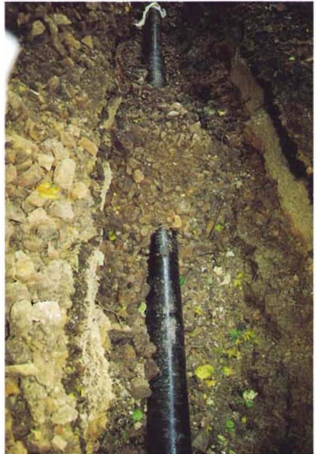
Bild 5: Verfüllung des Rohrgrabens mit steinigem Aushubmaterial
