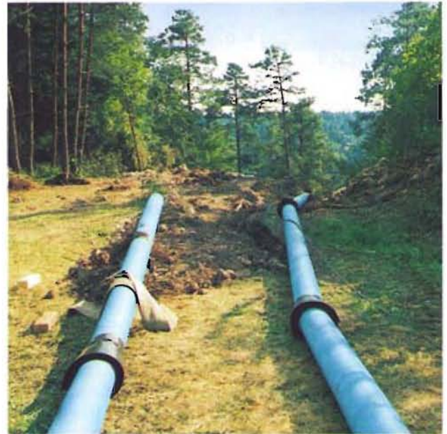
Bild 6: Vormontierte Stränge mit zusätzlichem Muffenschutz
