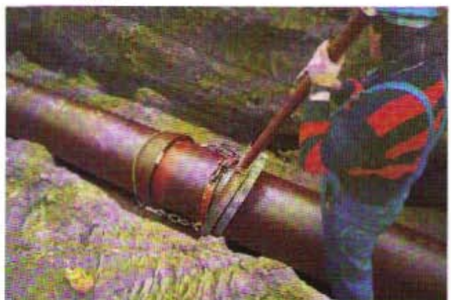
Bild 5: Verlegung mit Verlegegerät im beengten Bau- raum
