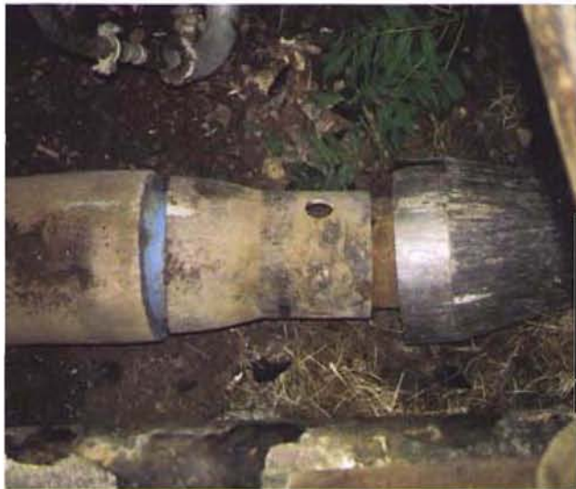
Bild 2: Adapter mit Übergangsmuffe
