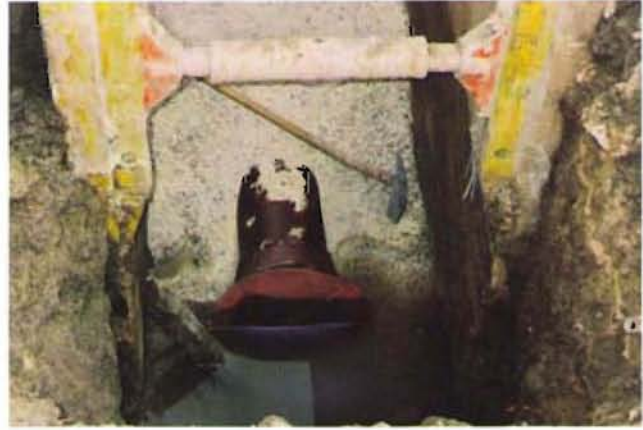
Bild 4: Rohrverlegung mit unterirdischer Kapselung
