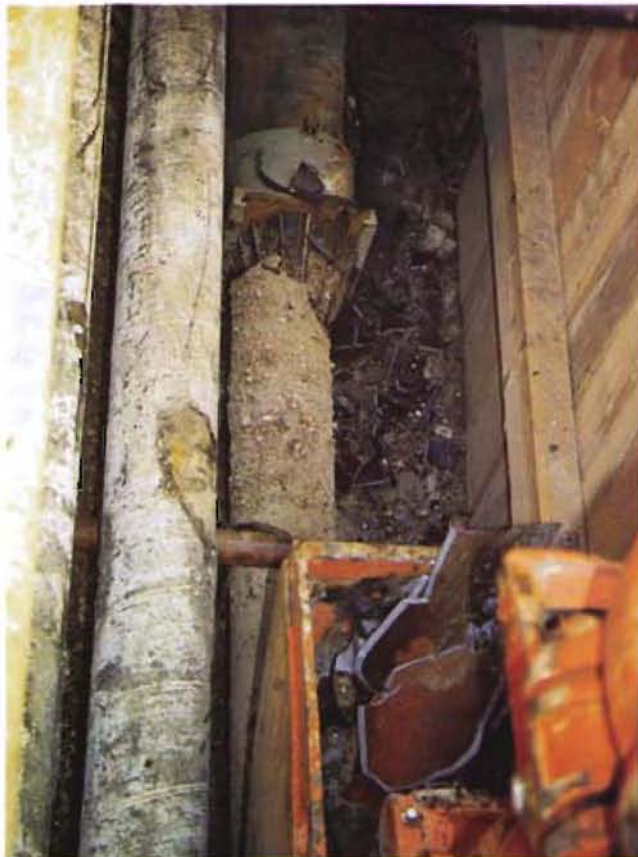
Bild 5: Spaltkeil in einer Zwischenbaugrube
