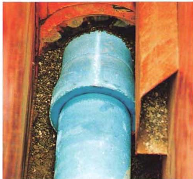
Bild 4: Herstellen der Muffenverbindung in der Pipebox
