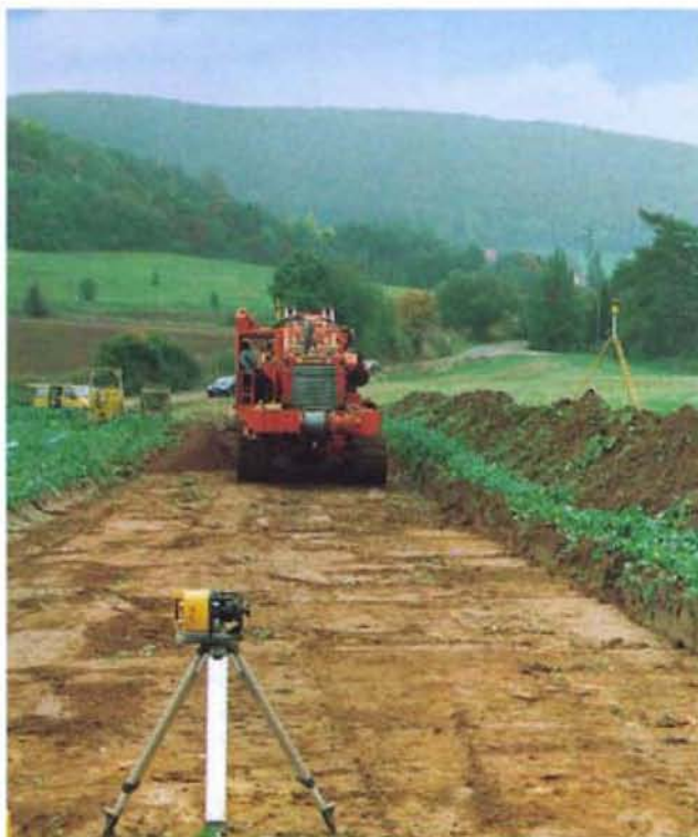
Bild 6: Richtungs- und Höhenlaser zur Erzielung einer genauen Rohrlage
