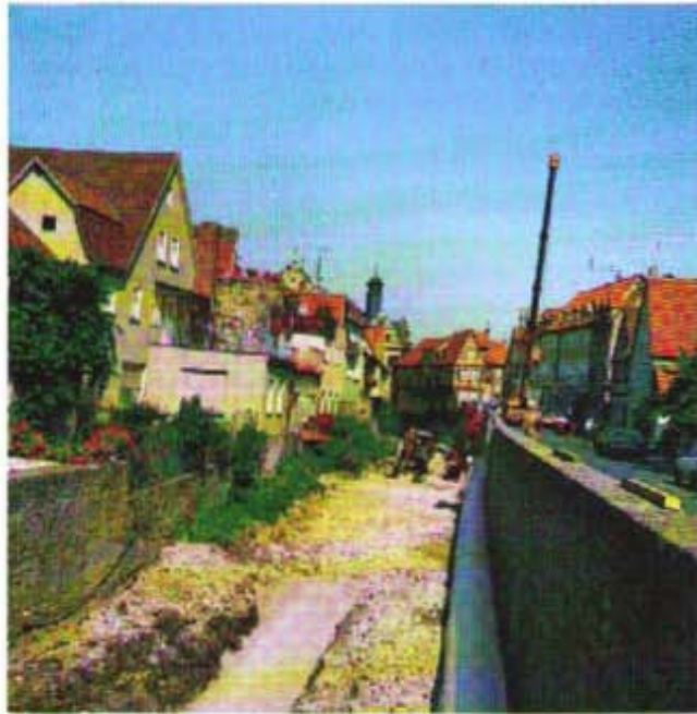
Bild 6: Rohrtrasse in Bachmitte
