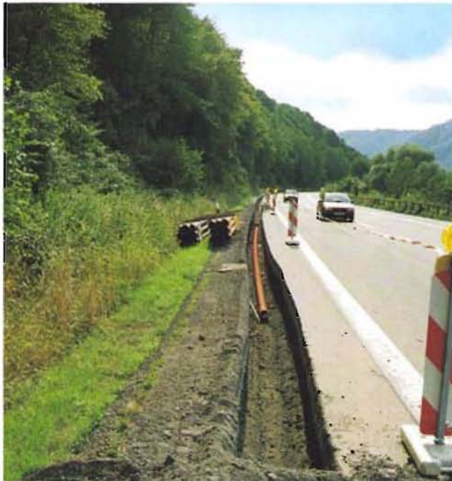
Bild 3: Bau eines Verbindungssammlers
