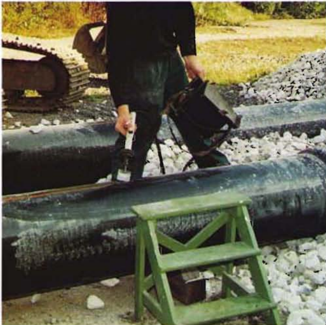
Bild 2: Funkenprüfung mit 25 kV
