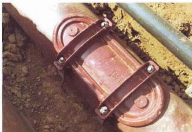
Bild 3: Rohrreinigungs-/Inspektionsdeckel
