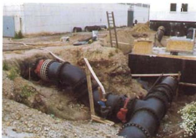
**Bild 3:** Fertiggestellte Einbindung mit Blick auf den Meßschacht.
