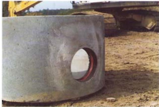
Bild 2: Fertigteilschacht mit TYTON-Schachtanschlußstück
