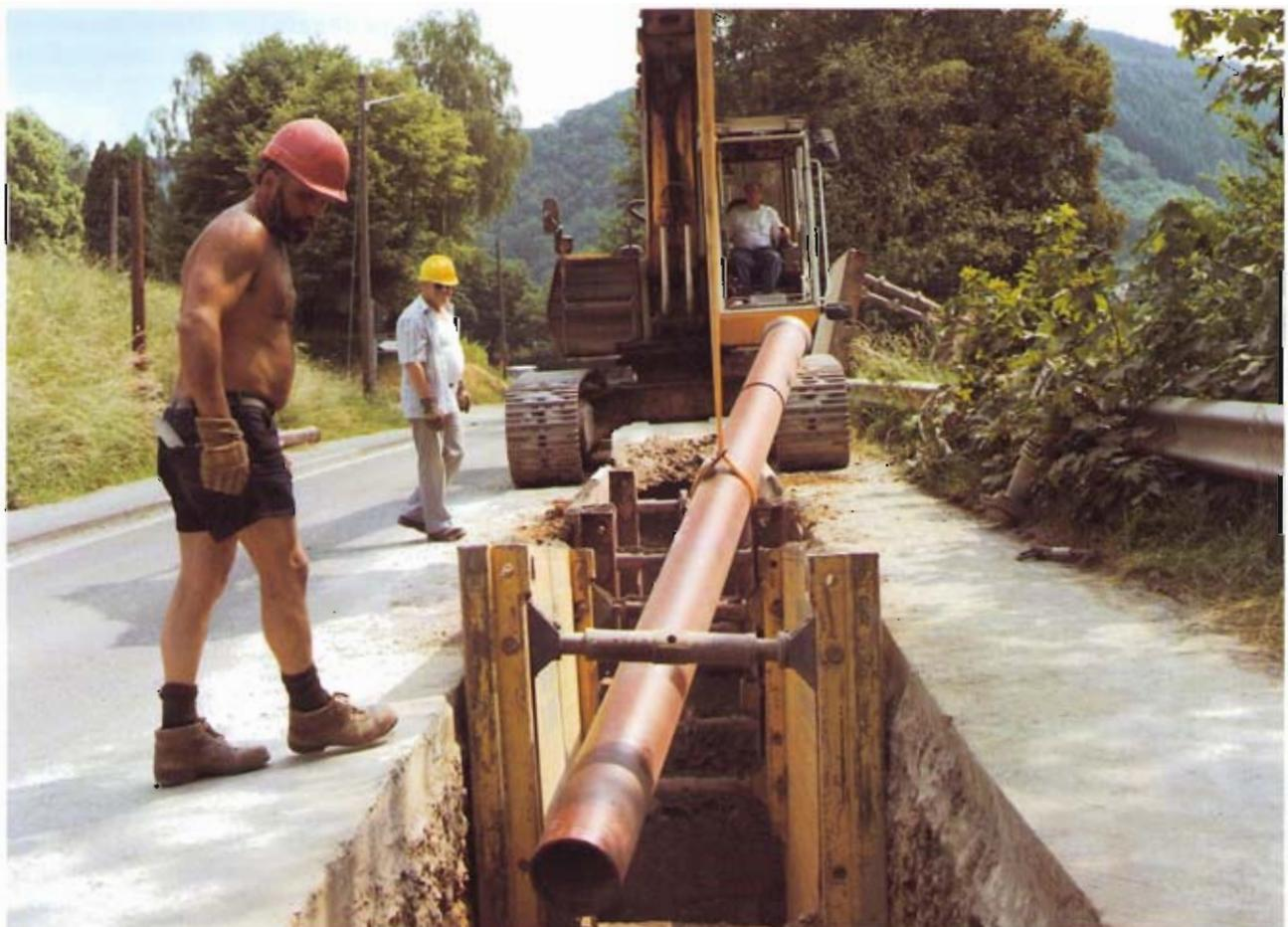
sene Hausanschlußleitungen ebenfalls der Druckprüfung unterzogen.
