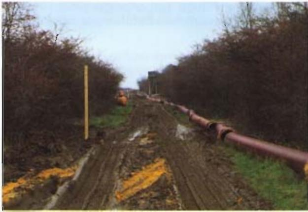
Bild 4: Kanalgußrohre DN 600 auf der Trasse der Freispiegelleitung
