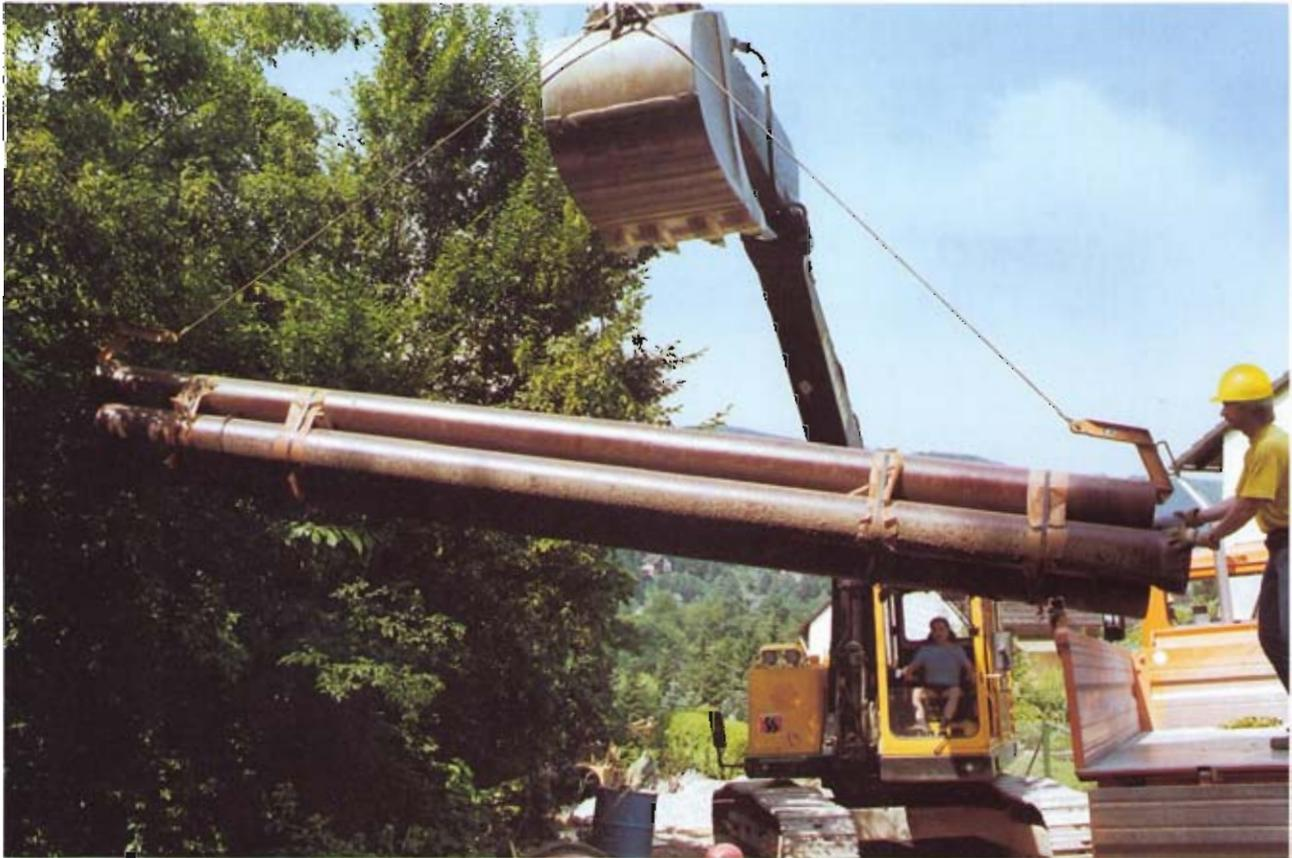
Bild 5: Abladen der duktilen Rohre für die Schmutzwasserleitung
