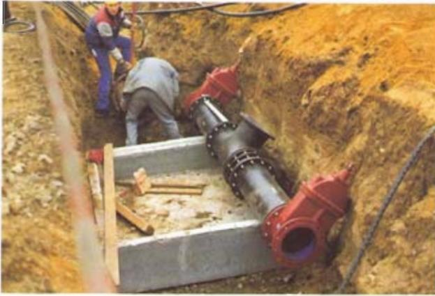
Bild 3: Schacht für Druckleitung im Bau
