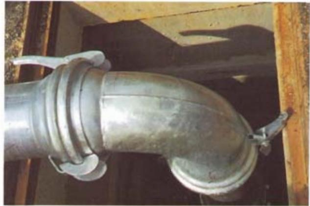
Bild 4: Schacht mit angeschlossener Notleitung DN 250
