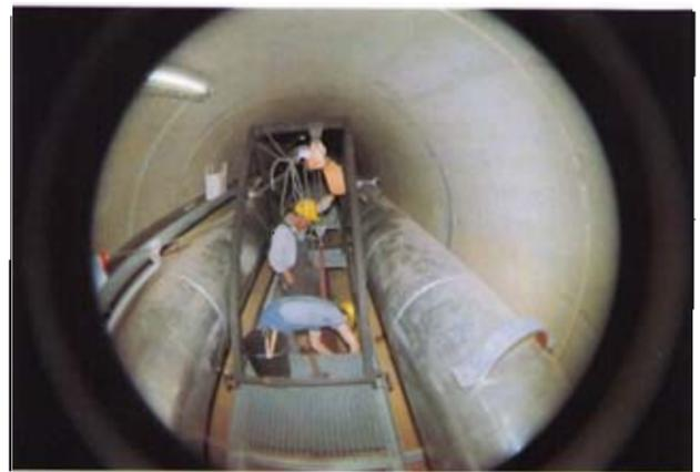
Bild 6: Montagearbeiten mit Hilfe des Portalkrans
