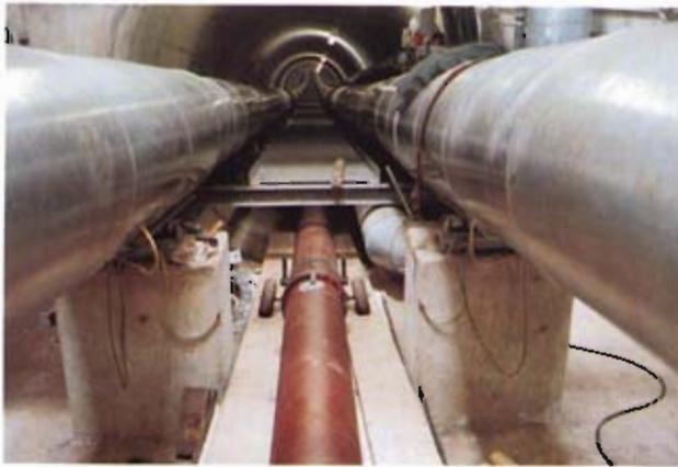
Bild 4: Einfahren eines Rohrstrangs in den Tunnel
