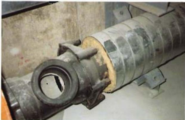
Bild 3: Einbau eines Abzweigformstückes (hier mit der schraubengesicherten TIS-Verbindung). Man erkennt die PU-Ausschäumung.
