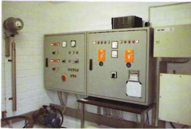
Bild 6: Steuerschrank der Meß- und Regelstation im Zentrum des RÜB
