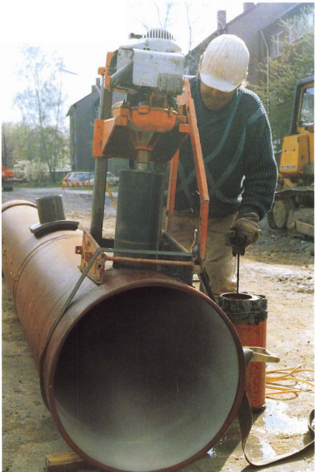
Gußhauptleitungsrohr mit den vormontierten Abgängen auf die Grabensohle abgelassen und dort mit dem zuletzt verlegten Rohr verbunden werden (Bild 9).
