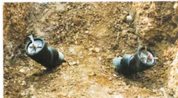
Neben dem Setzen von Dichtkissen zum Abdichten wurden auch Preßkolben und Steckscheiben auf ihre Verwendbarkeit geprüft und für gut befunden.
