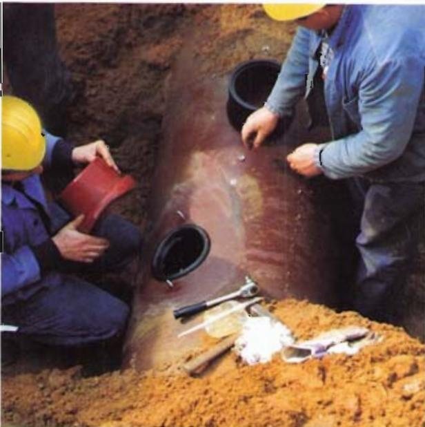
Bild 4: ... Dichtung und Anschlußstück aufgesetzt, verschraubt...
