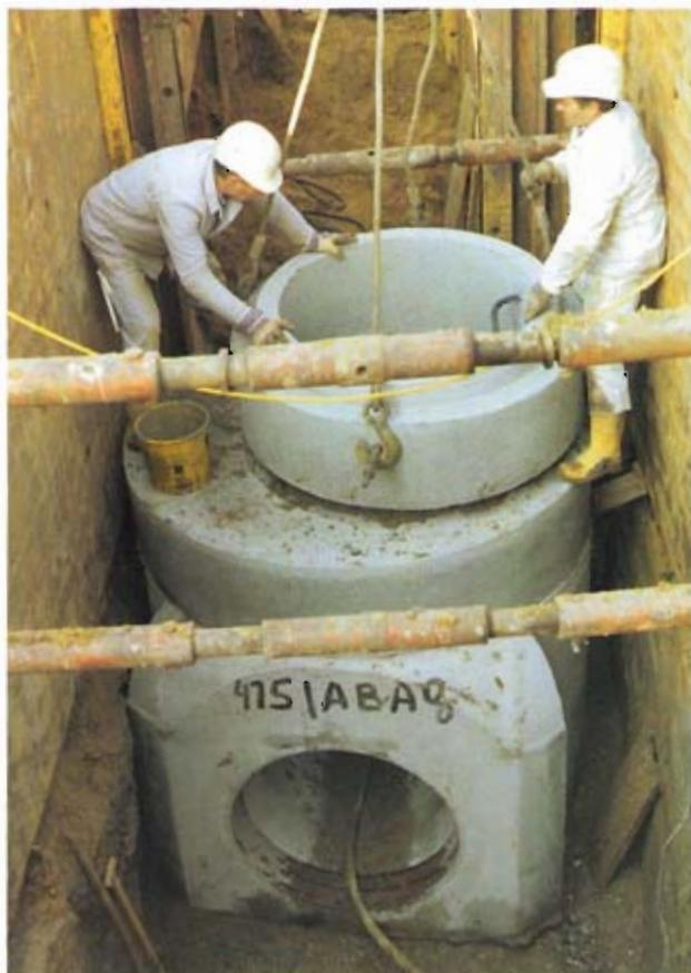
mension mit lichten Weiten von 1000 bis 1500 mm neu gesetzt. In die kompletten Schachtgrundkörper waren seitens des Schachtherstellers werkseitig die vom Gußrohrhersteller beigestellten Schachtanschlußstücke eingebaut worden (Bild 6).
