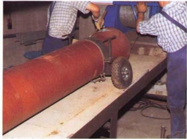
Bild 3: Ankoppeln des vormontierten Rohrstrangs
