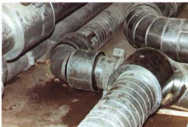
Für den Einbau der notwendigen Be- und Entlüftungsorgane sowie der Entleerungen wurden vor Ort Stützen DN 25 und DN 50 auf die duktilen Gußrohre aufgeschweißt. Nach dem Anbringen des Blechmantels wurden auch diese Stützen eingeschäumt.
