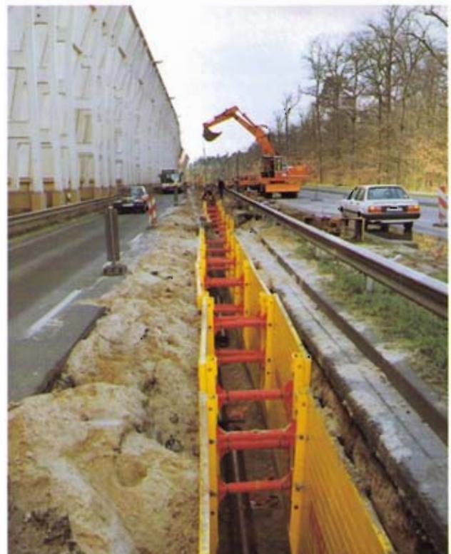
lich mußten die Bauarbeiten unter Aufrechterhaltung des Verkehrs mit möglichst minimalen Behinderungen durchgeführt werden. Dies bedeutete zwansläufig sehr beengte Bau- und Lagerflächen. Zusätzlich erschwert wurden die Arbeiten durch eine Vielzahl kreuzender Ver- und Entsorgungsleitungen, so daß erst nach umfangreichen Sondierungen die endgültige Trassierung festgelegt werden konnte.
