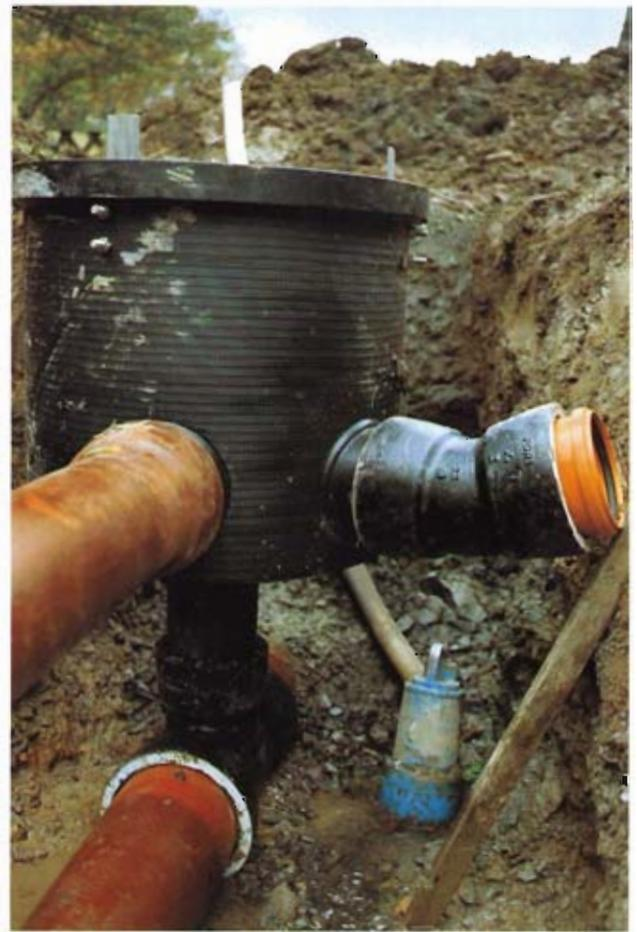
Bild 10: Aufnahmeschacht mit zwei Zuläufen
