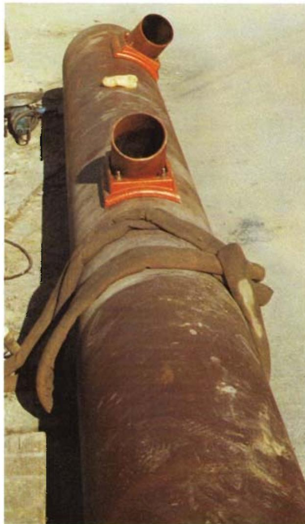
Bild 9: Leitungsrohr mit vormontierten 45°-Abgängen
