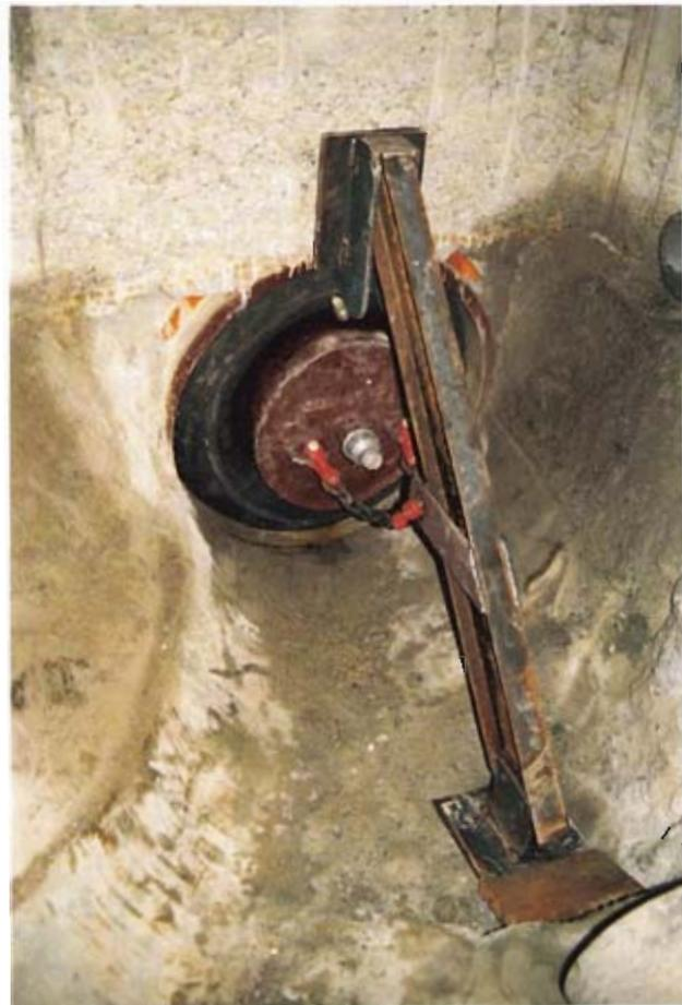
Bild 6: Fixierung einer Dichtblase
