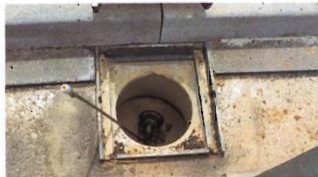
Bild 7: Straßeneinlauf – das Einfüllventil zum Setzen des Rohrdichtkisses ist sichtbar – siehe Prinzipbild 3
