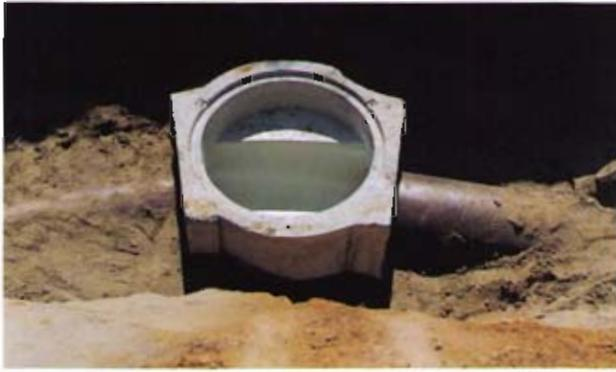
Bild 6: Betonschacht
