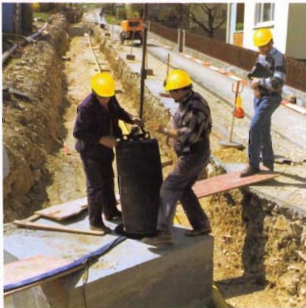
Bild 4: Einbringen einer Dichtblase DN 500 bis DN 1200 in einem Schacht
