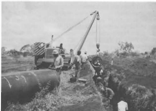
Bild 5: Zur Verlegung werden Kettenfahrzeuge mit Seilenbaum eingesetzt
