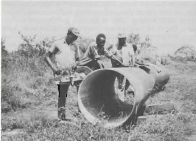
Bild 4: Mit Trennschleifgeräten werden die Rohre auf gewünschte Längen geschnitten
