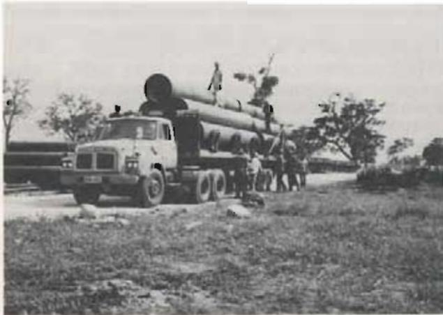
Bild 2: Die Rohre werden vom Zwischenlager zur Trasse befördert
