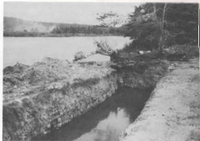
Bild 6: Das Wasser wird durch einen Reinigungsgraben in ein Absetzbecken geleitet und dann zur Druckprobe entnommen
