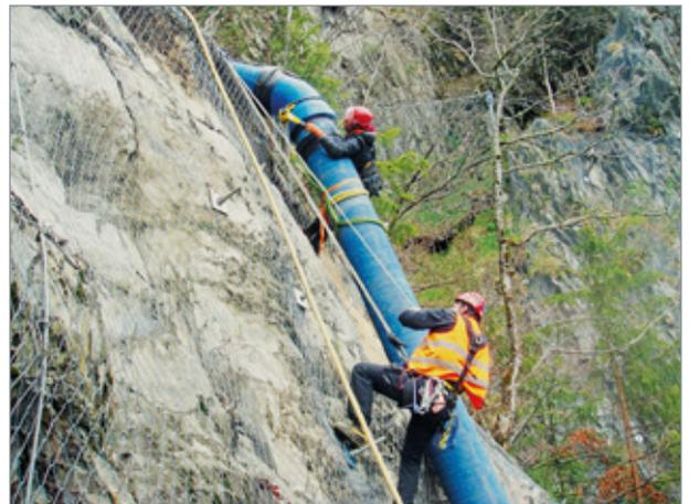
Voller Körpereinsatz in steilstem Gelände. Die BLS®-Verbindung von Hagenbucher nimmt die senkrecht wirkenden Zugkräfte problemlos auf. Die Rohre wurden per Helikopter angefliegen.
