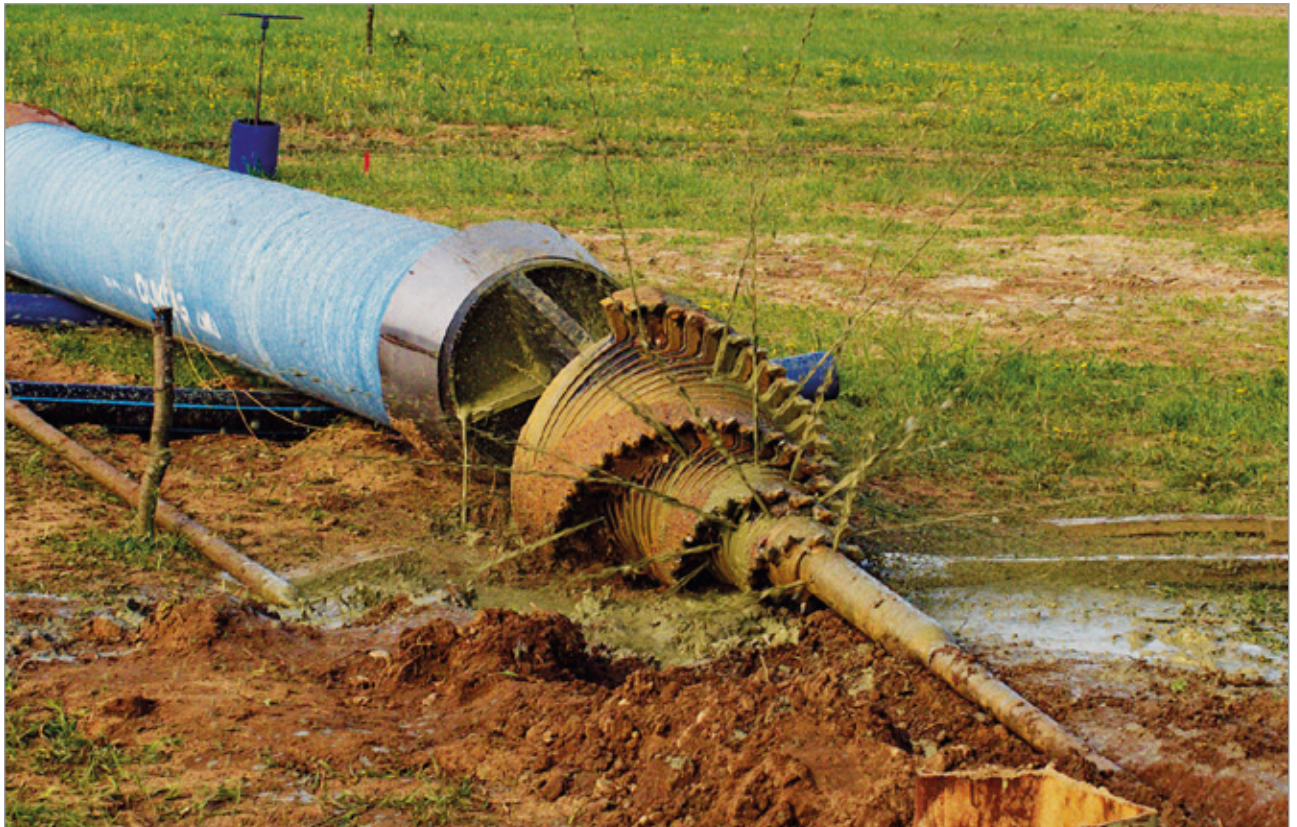
Funktionsprüfung des Bohrkopfes vor dem Rohreinzug.
