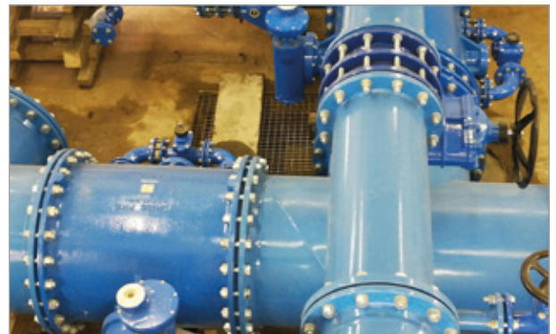
Finale Situation nach der Sanierungsmaßnahme.
