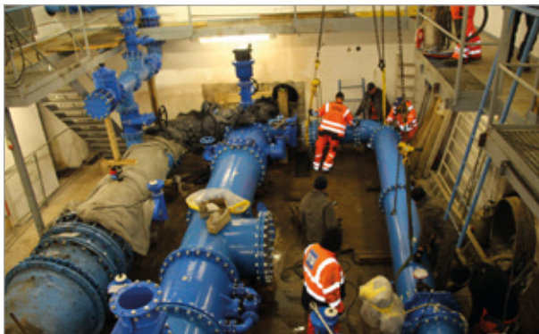
Einbau der ERHARD Absperrklappen montiert an die Rohrleitung.
