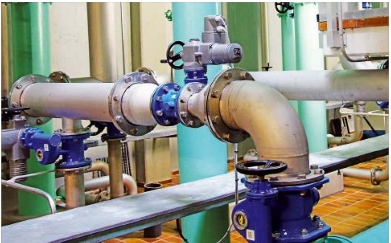
Pass- und Ausbaustück PAS10, Absperrklappen ERHARD ROCO wave mit aufgebautem E-Antrieb
