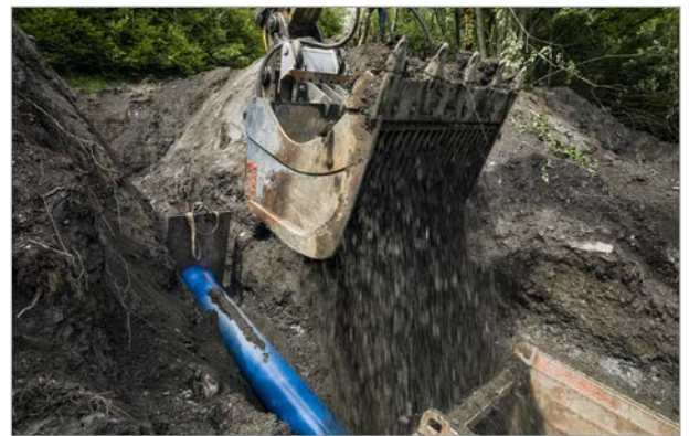
Verfüllen des Leitungsgrabens mit dem vorher entnommenen Boden
