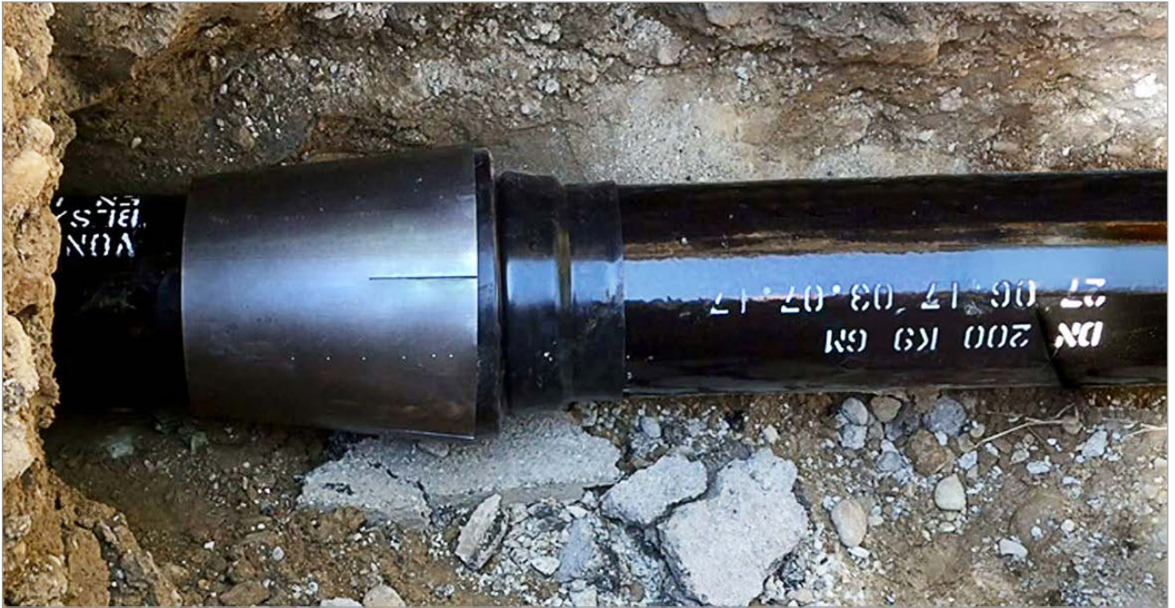
Einzug der duktilen Gussrohre ECOPUR in die aufgeborstene Altrohrleitung aus Grauguss
