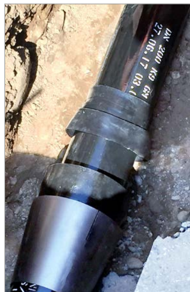
Steckmuffen-Verbindung HYDROTIGHT grabenlos
