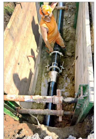
Montage ECOPUR Grabenlos-Verbindung HYDROTIGHT
