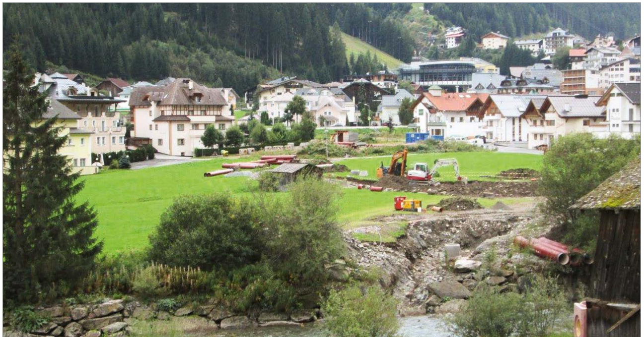
Verlauf der Rohrtrasse am Ortsrand von Ischgl
