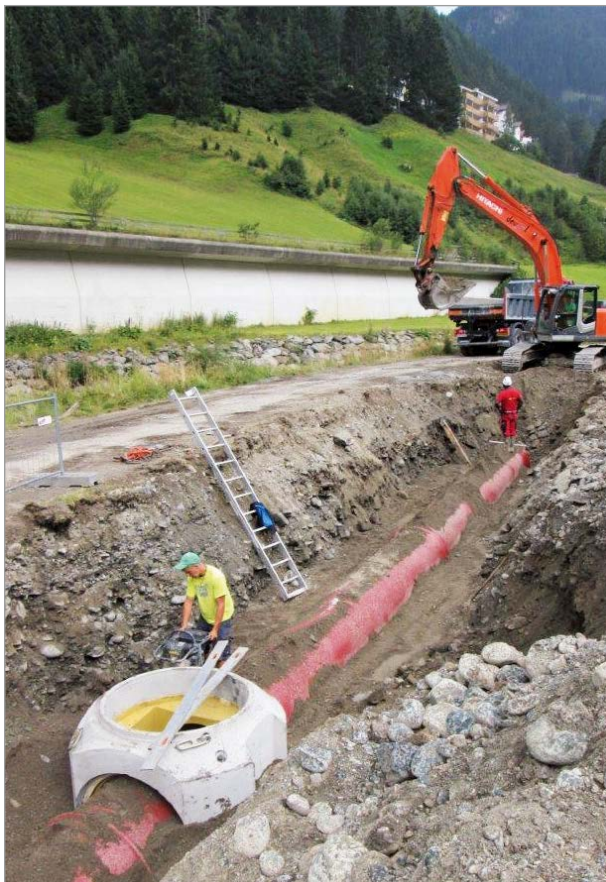
Verfüllen des Leitungsgrabens nach dem Einbau der Schächte und der fremdwasserdichten Rohre.
