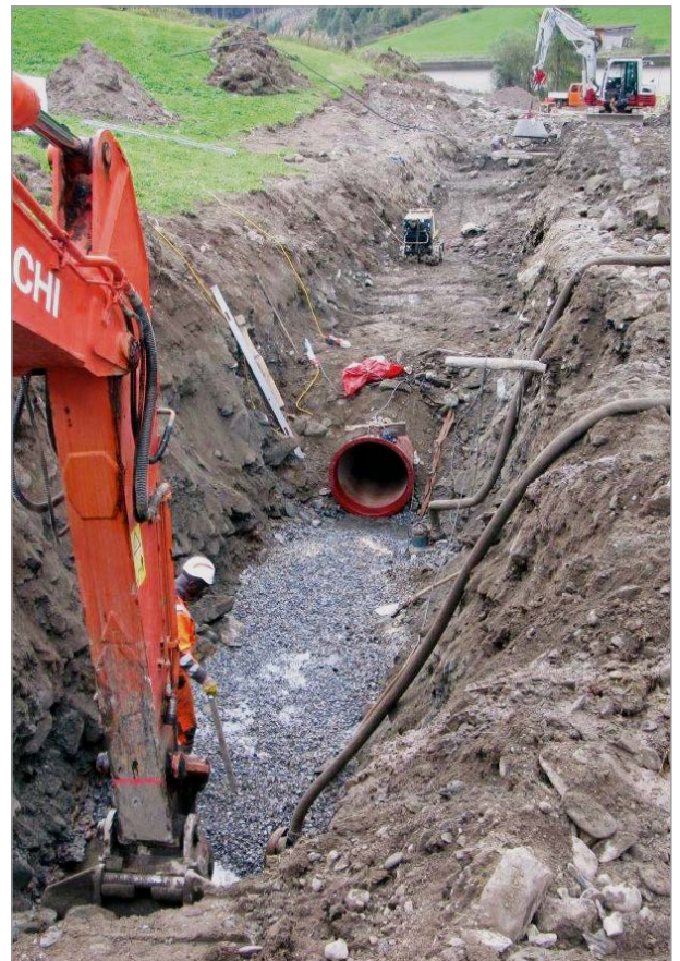
Einbau der duktilen Gussrohre in einem Bereich mit anstehendem Grundwasser
