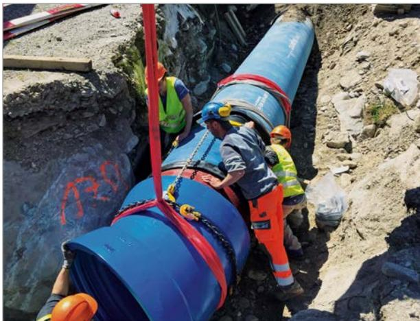
Einbau eines Doppelmuffen-Bogens in einer Turbinenleitung.
