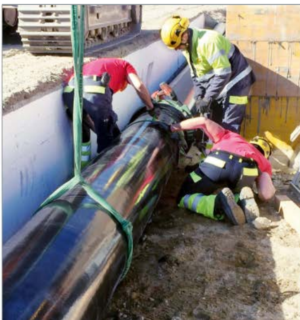
Montage einer längskraftschlüssigen Steckmuffen-Verbindung HYDROTIGHT
