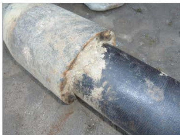
PLUG & DRIVE ® Verbindung eines nach 30 Jahren gezogenen Gussrammpfahls
