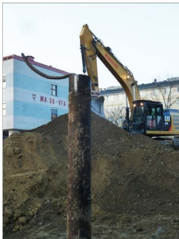
Nach 30 Jahren freigelegter Gussrammpfahl
