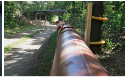
Verlauf der Interimsleitung entlang eines Forstwegs
