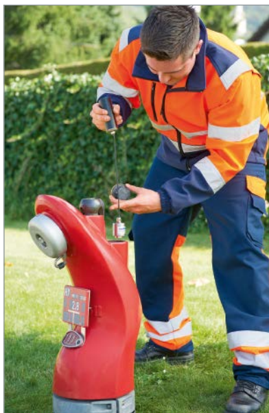
Sensoreinbau in einen Überflurhydranten
