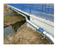
hydraulischen Berechnungen und wegen der geografischen Lage wurde die Leitung mit einem Druck bis zu PN 40 ausgelegt; eine Pumpstation sowie vier Wassertürme wurden in das Projekt integriert. Für die teils steinigen Böden innerhalb der Leitungstrasse wurden duktile Gussrohre mit einer Zementmörtel-Umhüllung und BLS®-Verbindung gewählt. Bei der Überguerung von Flüssen wurden Brücken genutzt, an wärmegedämmte duktile Gussrohre (WGK) zum Einsatz kamen.
