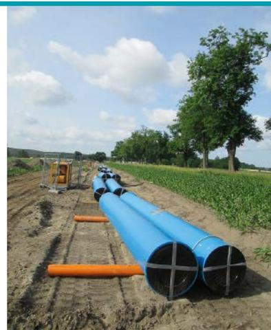
von Rohr zu Rohr werden Verriegelungssegmente aus duktilem Gusseisen verwendet. Mit dem BLS®-System können unvorhergesehene Setzungen und damit verbundene Längenänderungen sicher kompensiert werden. Die Montage des BLS®-Systems ist einfach und dauert kaum länger als die beim BRS®-System.
