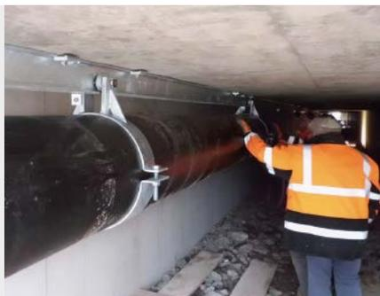
◆ Im Rahmen der Baumaßnahme musste im Schwarzbachtal eine circa 300 m lange Trinkwasserleitung DN 300 umgelegt werden. Der Zweckverband zur Wasserversorgung der Aschaffalgemeinden, Goldbach, wählte die neue Trasse der Trinkwasserleitung so, dass ein 160 m langes Teilstück der Rohrleitung in offener Bauweise gebaut werden konnte. Für diesen Bauabschnitt wurden duktile Gussrohre DN 300, K 9, PN 10 mit
