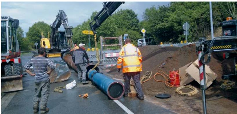
◆ Die Führung des Kreiswasserwerks Neuwied hatte sich dazu durchgerungen, einen Teil der bestehenden Wassertransportleitung DN 400 durch eine neue Trinkwasserleitung zu ersetzen. Das neue Teilstück führt durch den Neuwieder Stadtteil Block (Krasnaerstraße) und durch
