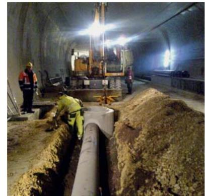
fallende Regenwasser wird vor dem Tunnelbauwerk in einem Regenklärbecken gesammelt und vorgereinigt. Das so gereinigte Wasser wird anschließend von einer Pumpstation über eine 540 m lange Druckleitung aus duktilen Abwasserdruckrohren DN 200 mit längskraftschlüssiger BLS® - Steckmuffen-Verbindung in den Vorfluter Rems eingeleitet. Alle eingebauten duktilen Gussrohre sind außen mit Zink/Epoxidharz beschichtet und mit Zementmörtel ausgekleidet.
