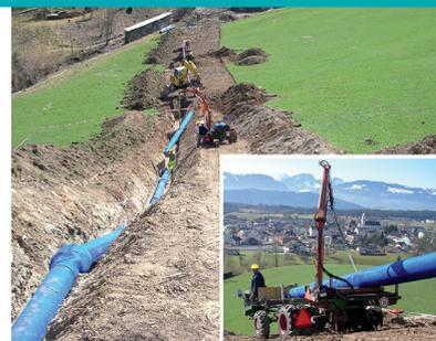
Rohre wurden mit einem zum Spezialfahrzeug mit Kran umgebauten geländegängigen, landwirtschaftlichen Allradfahrzeug transportiert. Dieses Fahrzeug musste mit einer Forstseilwinde gesichert werden. Wegen der leichten Montage der Rohre konnte eine kurze Bauzeit verwirklicht werden.
