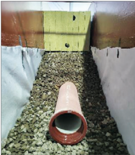
Abb. 6: Das Boden-Rohr-System im Straßenraum. Links: Aufbau des Leitunggrabens von oben nach unten mit Steinwolle-Elementen, grobkörnigem, gut belüftbarem Substrat und duktilem Gussrohr.
