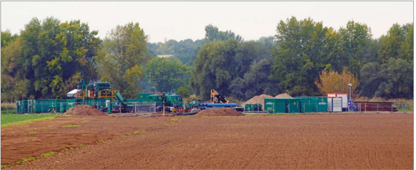
Abb. 2: Baustelleneinrichtung für die Großbohranlage, Platzbedarf. (Quelle: MIDEWA GmbH, Merseburg)
