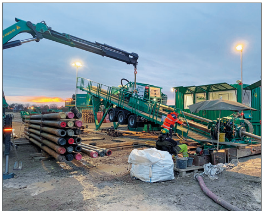
Abb. 1: Bohranlage HK 250 HT mit Steuercontainer und Widerlager mit Lagerkapazität 2.500 m 2 . (Quelle: Beermann Bohrtechnik GmbH, Hörstel)
