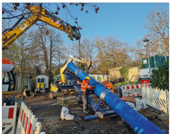
Abb. 11: Rohrmontage am Tag. (Quelle: vonRoll hydro (deutschland) gmbh & co kg, Wetzlar)
