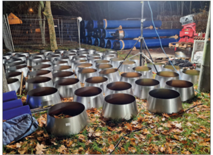
Abb. 7: Ausgelegte Stahlblechkonen. (Quelle: vonRoll hydro (deutschland) gmbh & co kg, Wetzlar)
