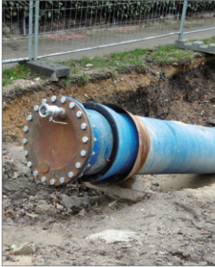
Abb. 12: Rohrleitungsverschluss für die Druckprüfung. (Quelle: vonRoll hydro (deutschland) gmbh & co kg, Wetzlar)
