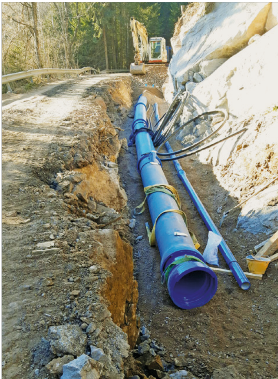
Abb. 1: Parallel zur neuen Wasserversorgungsleitung wurde in den beiden Gemeinden Jenesien und Sarntal auch eine Trinkwasserleitung mitverlegt. Erstmals werden damit auch entlegene Höfe ans Trinkwassernetz angeschlossen.
