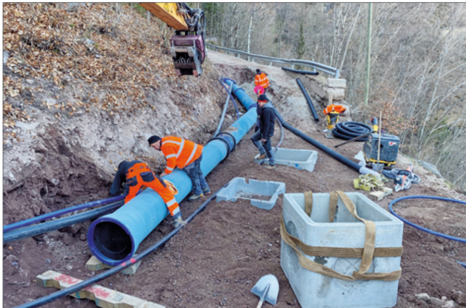
Abb. 8: Vorbereitung für die Setzung der Abnahmestationen, die mit moderner Technik ausgestattet wurden.
