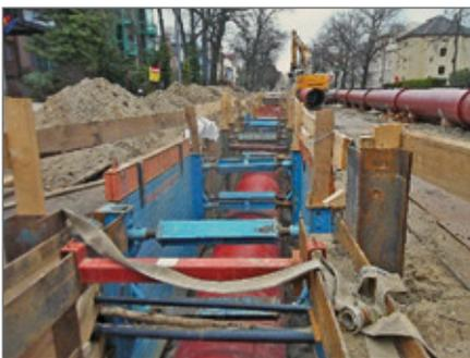
Neue Abwasserdruckrohrleitung DN 1200 GGG und rechts Interimsleitung DN 1000 GGG.
