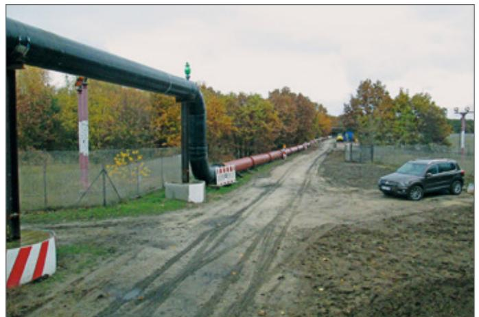
Rohrbrücke aus Stahlrohren sichern die Zugänglichkeit.
