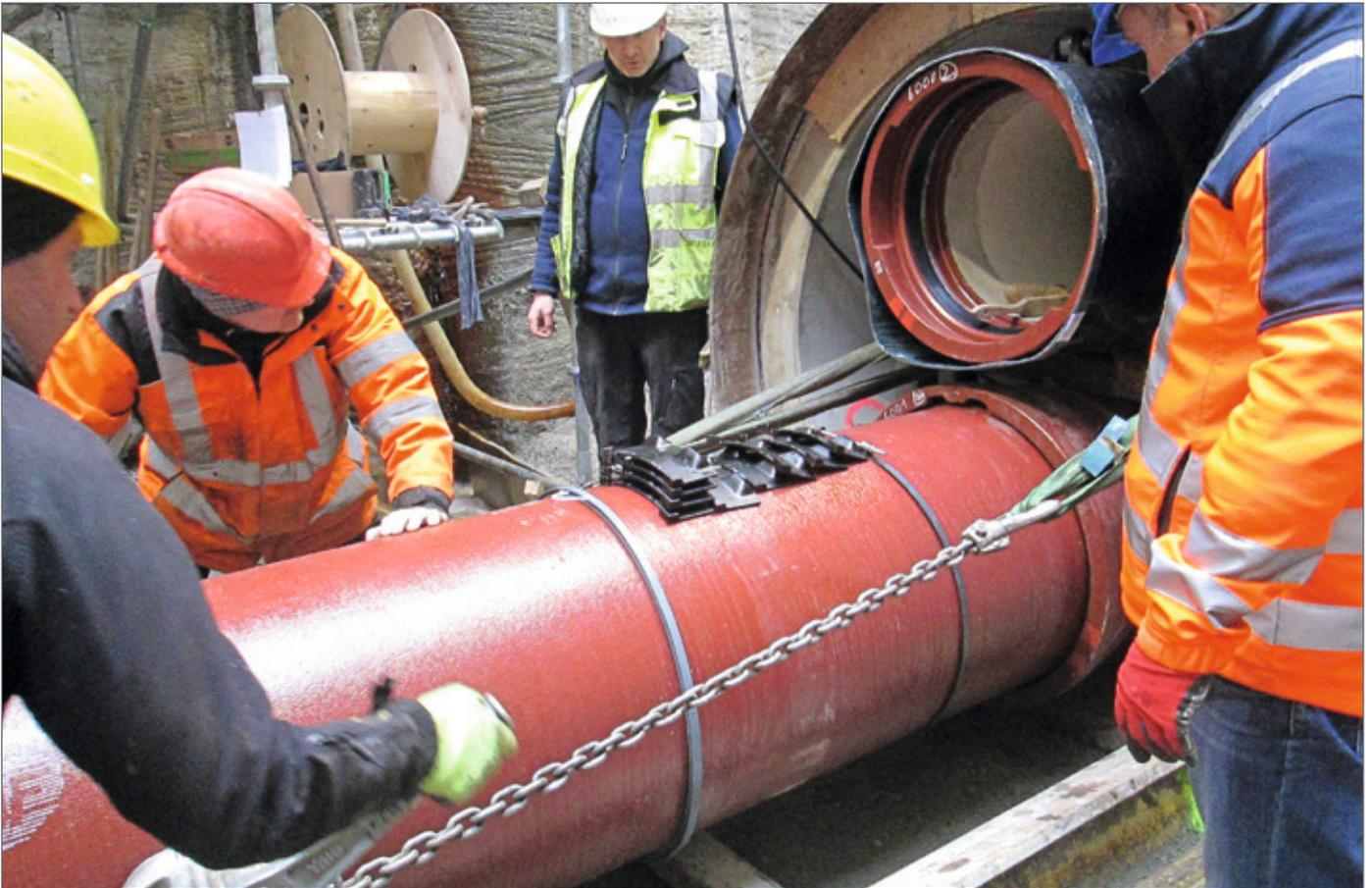
Einsatz duktiler Gussrohre mit längskraftschlüssigen Verbindungen.
