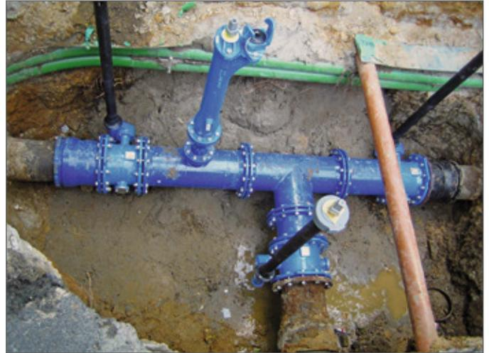
Mit Sicherheit: Einbau von Formstücken und Armaturen im erdverlegten Rohrleitungsbau.
