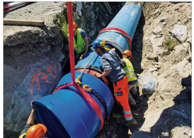
Bild 3: Einbau eines Doppelmuffenbogens 22° (MMK 22) und eines Passrohres an einem Richtungswechsel
