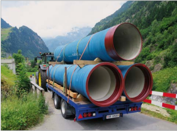
Bild 1: Transport der duktilen Gussrohre DN 1000 in das Maderanertal
