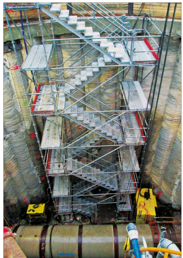
Bild 3: Blick in die Startgrube mit Stahlbetonvortriebsrohren
