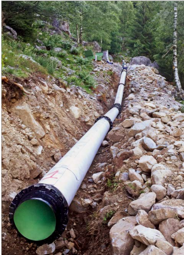
Bild 9: ECOPUR-Vollschutzrohre mit Felsschutzhülle ROCK und außenliegender Schubsicherungen HYDROTIGHT Fig. 2805
