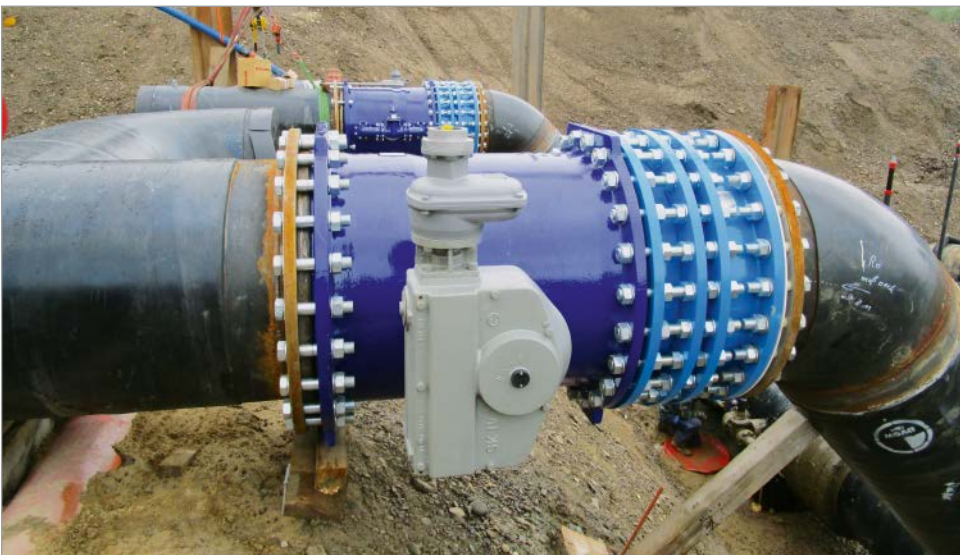
Bild 2: Detailansicht einer emaillierten Absperr- klappe DN 800 mit seitlicher Umföhrung und Austauschstück zur UV Anlage im Wasserwerk Halingen der WWWW
