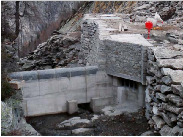
Bild 2: Wasserzulauf in das Einlaufbauwerk
