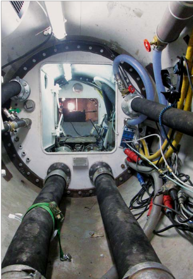
Bild 4: Blick in die Schleusenammer
