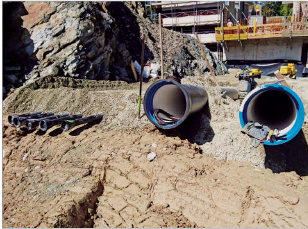
Bild 1: Duktile Gussrohrleitungen – fünf Teichleitungen DN 80 und zwei Entnahmeleitungen DN 600
