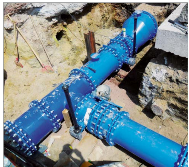
Bild 2: Armaturen und Formstücke DN 500 aus duktilem Gusseisen – Wiener Straße
