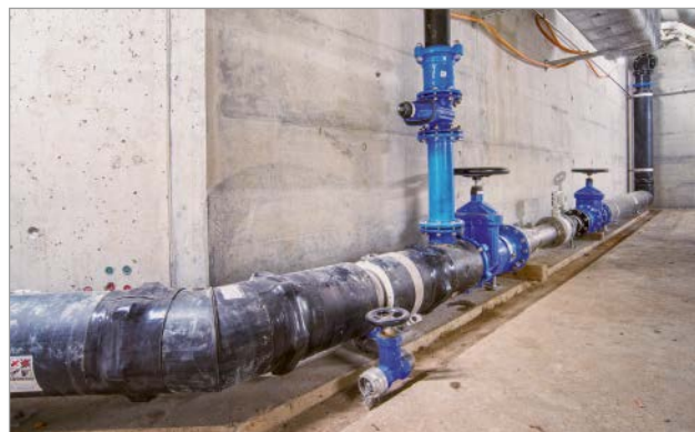
Bild 15: vonRoll Armaturen im Einsatz – Streckenschieber, Absperrschieber für Stichleitungen sowie Anbohrarmatur zur Entleerung
