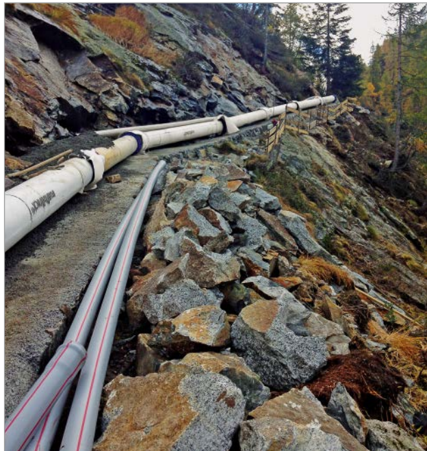
Bild 7: Druckleitung ECOPUR oberirdisch auf Fels eingebaut
