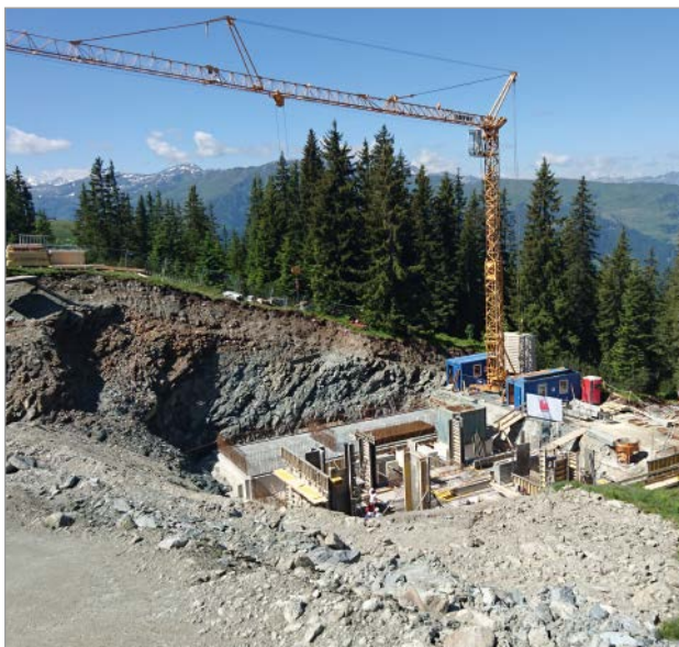
Bild 2: Errichtung der neuen Pumpstation
