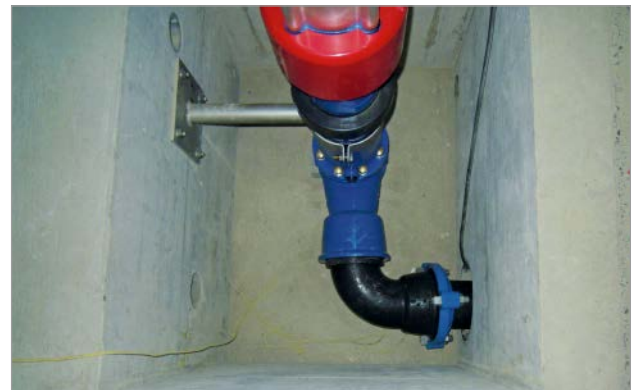
Bild 12: Hydranten-Nische mit Anschluss des Hydranten-Unterteils VARIO 2.0 an die Stichleitung DN 125
