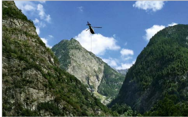
Bild 6: Transport und Einbau der ECOPUR-Rohre mit Helikopter
