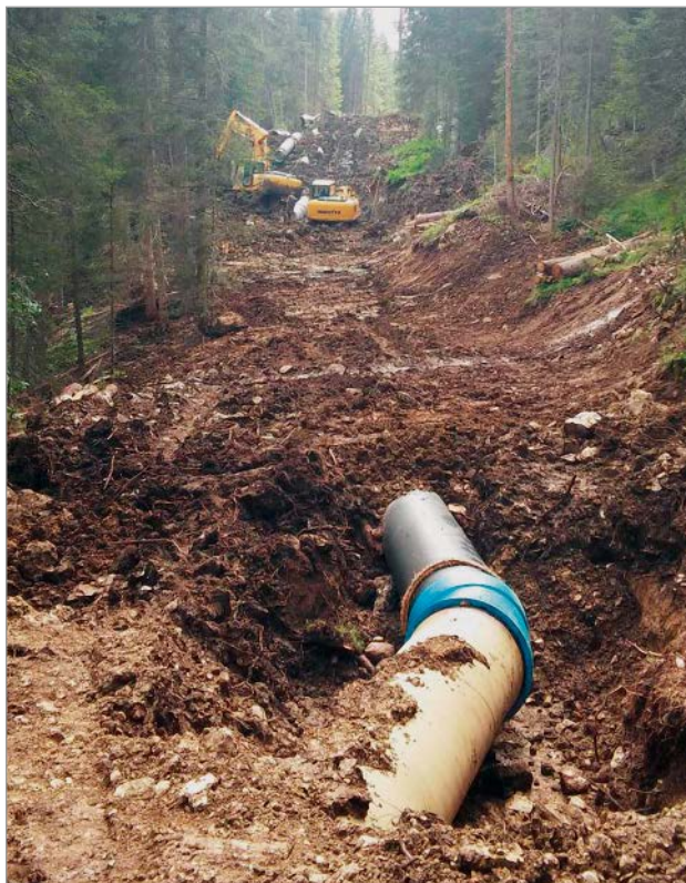
Bild 6: Rohrleitungsbau im Rutschhang
