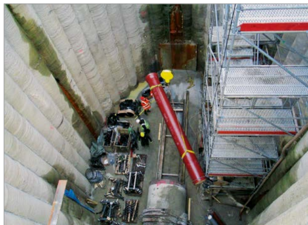
Bild 2: Herablassen eines duktilen Gussrohres zur Montage
