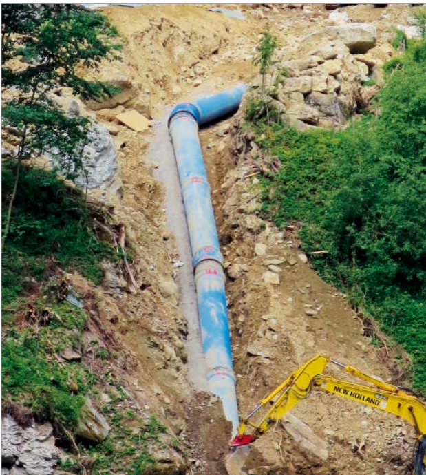
Bild 6: Verfüllen des Rohrgrabens und Wiederherstellung der Oberfläche im schwierigen alpinen Gelände
