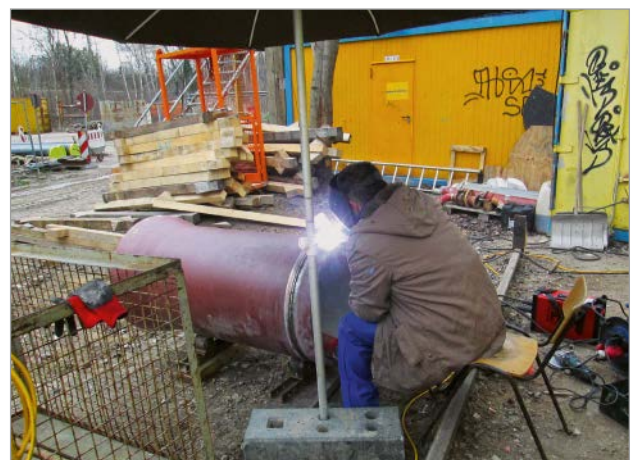
Bild 8: Nachträgliches Aufbringen der Schweißraupe durch den Anwendungstechniker des Rohrherstellers
