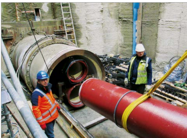
Bild 1: Einbau eines duktilen Gussrohres DN 600 (unteres Rohr) mit längskraftschlüssiger BLS® - Steckmuffen-Verbindung
