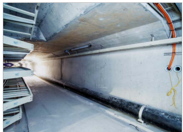
Bild 5: Wärmedämmte duktile Gussrohre DUCPUR im Werkleitungskanal
