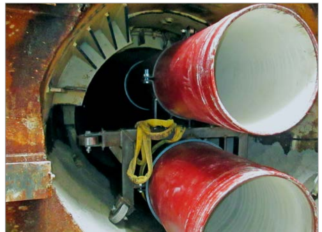
Bild 7: Zum Einzug vorbereitetes Rohrbündel
