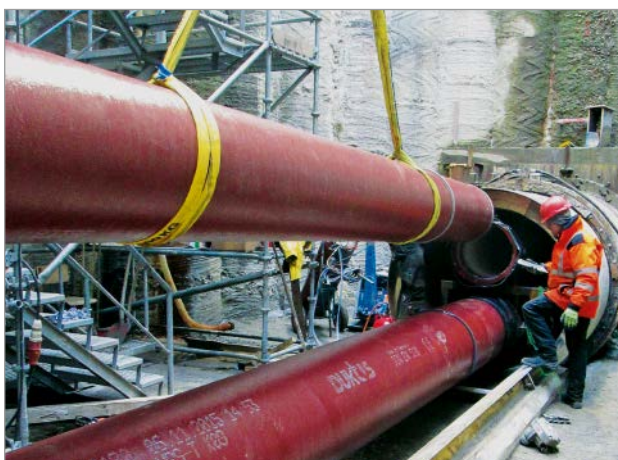
Bild 6: Montage der duktilen Gussrohre im Startschacht
