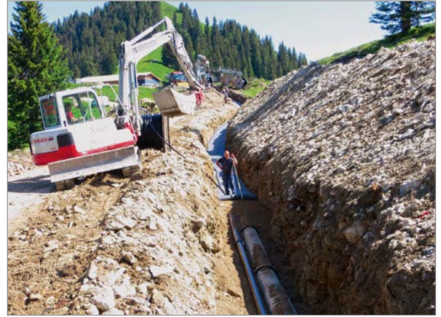
Bild 3: Feldleitungsbau – Transportleitung DN 500
