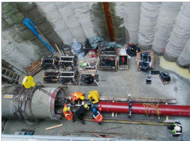
Bild 5: Blick in die Startgrube bei der Zugkopfmontage
