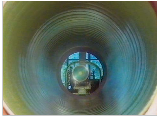
Bild 4: Spiegelglatte PUR-Auskleidung, hydraulisch glatt mit Rauheit k \leq 0,01 mm
