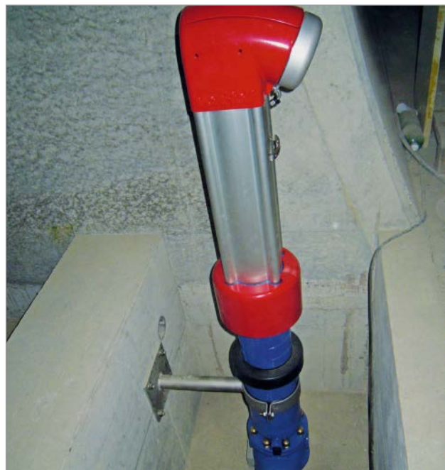
Bild 14: Hydranten-Unterteil vonRoll VARIO 2.0 und Hydranten-Oberteil vonRoll HYTEC nach der Endmontage
