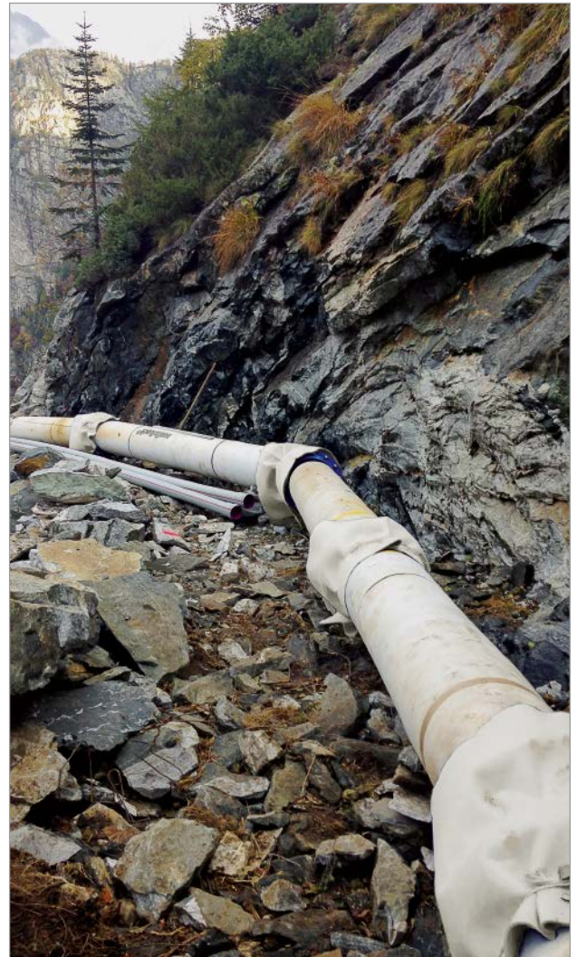
Bild 5: Abwinkelbare Steckmuffen-Verbindung HYDROTIGHT
