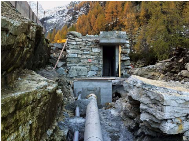
Bild 3: Einlaufbauwerk mit Tessiner Naturstein verkleidet
