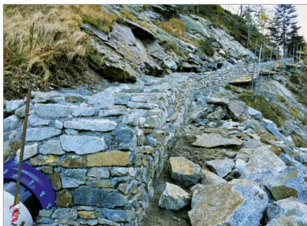
Bild 8: Naturnahe Widerinstandsetzung mit Bruchsteinmauer um die Druckleitung herum
