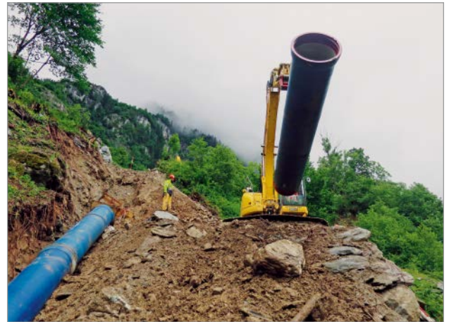
Bild 2: Montage eines duktilen Gussrohrs „über Kopf“
