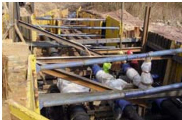
**Bild 8:** Leitungsneulegung von drei Strängen duktiler Gussrohre
