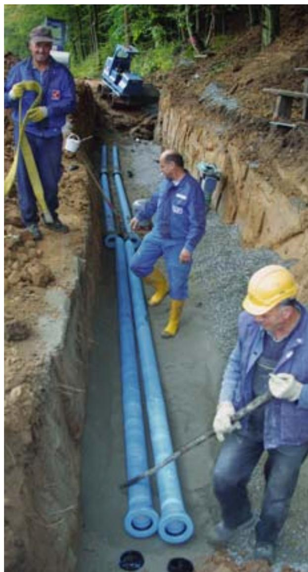
**Bild1:** Paralleleinbau duktiler Gussrohre DN 100 zwischen Hochbehälter Gronau und Prevorst
