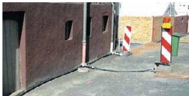
Bild 4: Ersatzversorgungsleitungen
