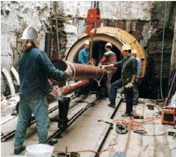
Bild 2: Montage der Rohre vor dem Dükereingang
