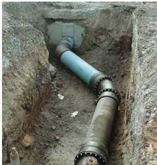
Bild 7: Übergang der WKG-Brückenleitung in den erdüberdeckten Bereich
