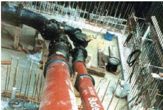
Bild 4: Richtungsänderung im Revisionsschacht
