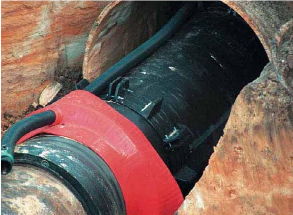
Bild 5: Gleichzeitig mit der Leitung wird das Steuerkabel eingebaut.
