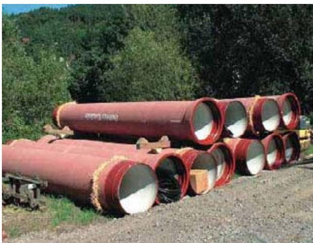
Bild 1: Rohre DN 800 BLS mit Zementmörtelumhüllung an der Baustelle
