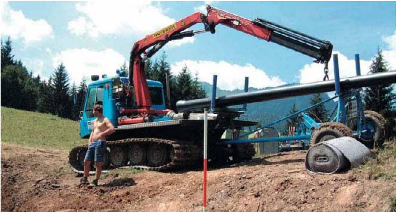
Bild 4: Rohrtransport in schwierigem Gelände
