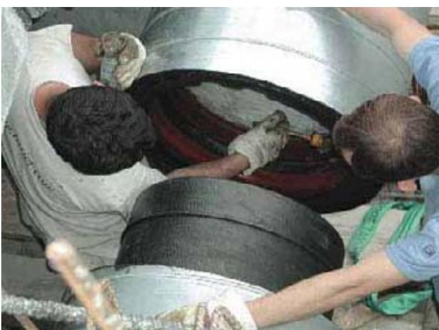
Bild 4: Montage der längskraftschlüssigen Verbindung
