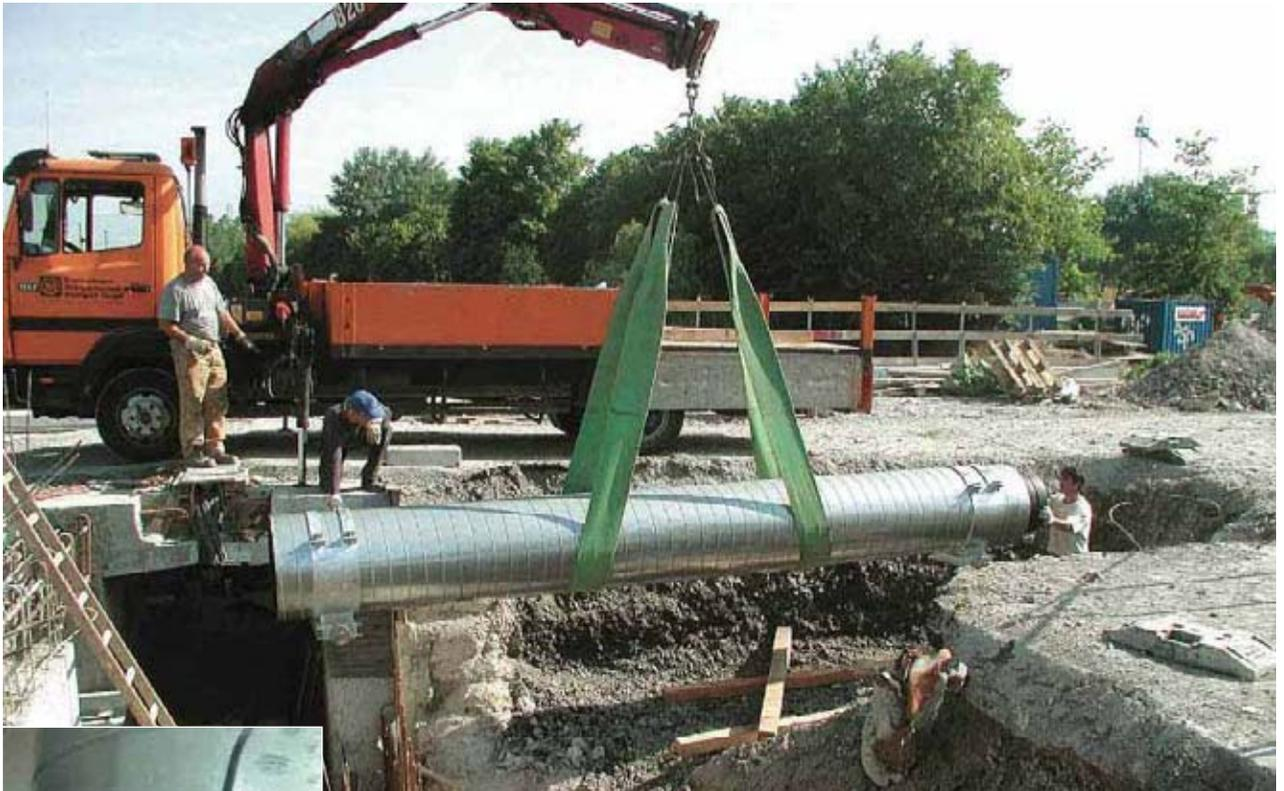
Bild 2: WKG-Rohr mit Montageschellen
