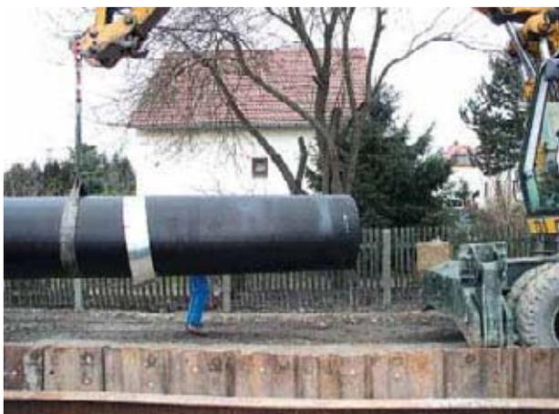
Bild 4: Rohr wird in die Startgrube abgelassen
