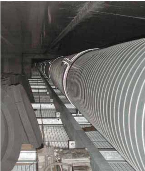
Bild 6: Rohrleitung in der Brücke mit Einziehwinde
