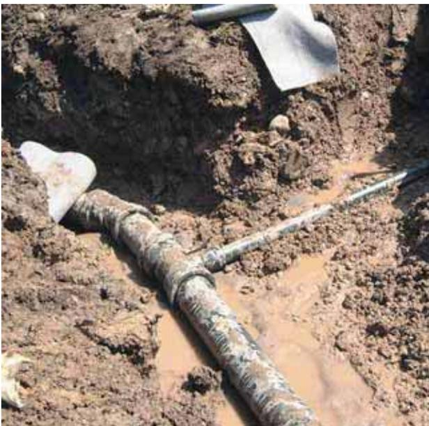
Bild 5: Abzweig für Hydrantenanschluss
