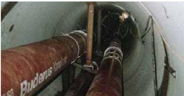
Bild 3: Abstützung des Rohrbündels im Düker
