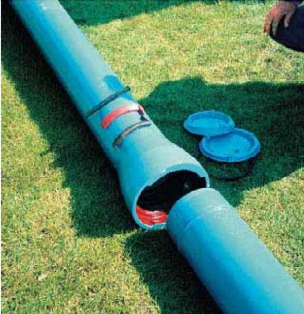
Bild 4: Montage der BLS-Verbindung
