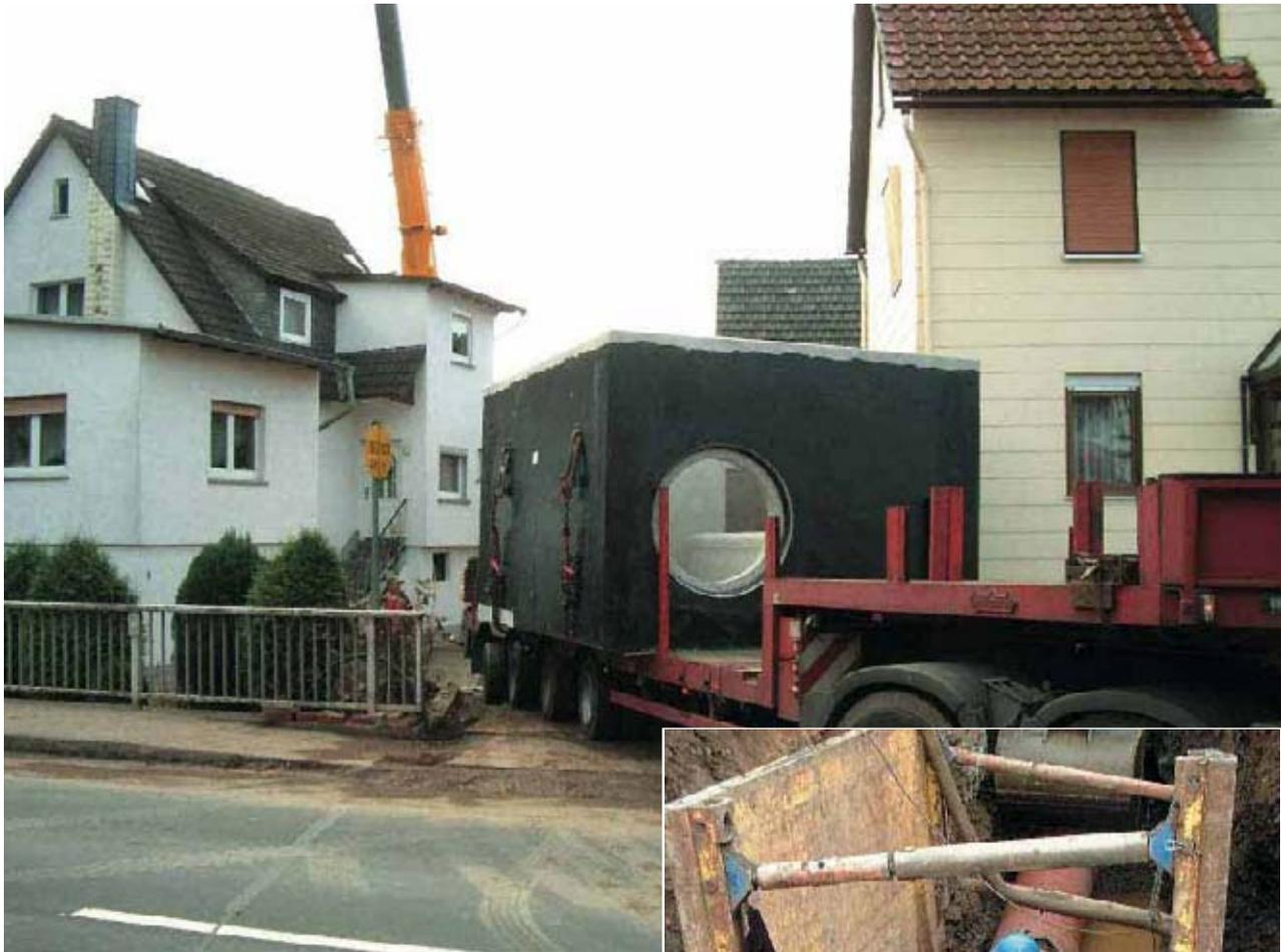
Bild 2: kniffliger Transport des Fertigschachts
