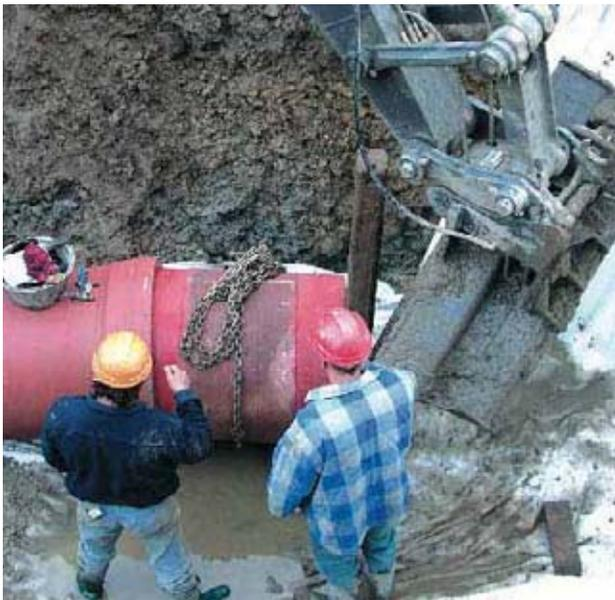
Bild 6: Einbau von Passrohren
