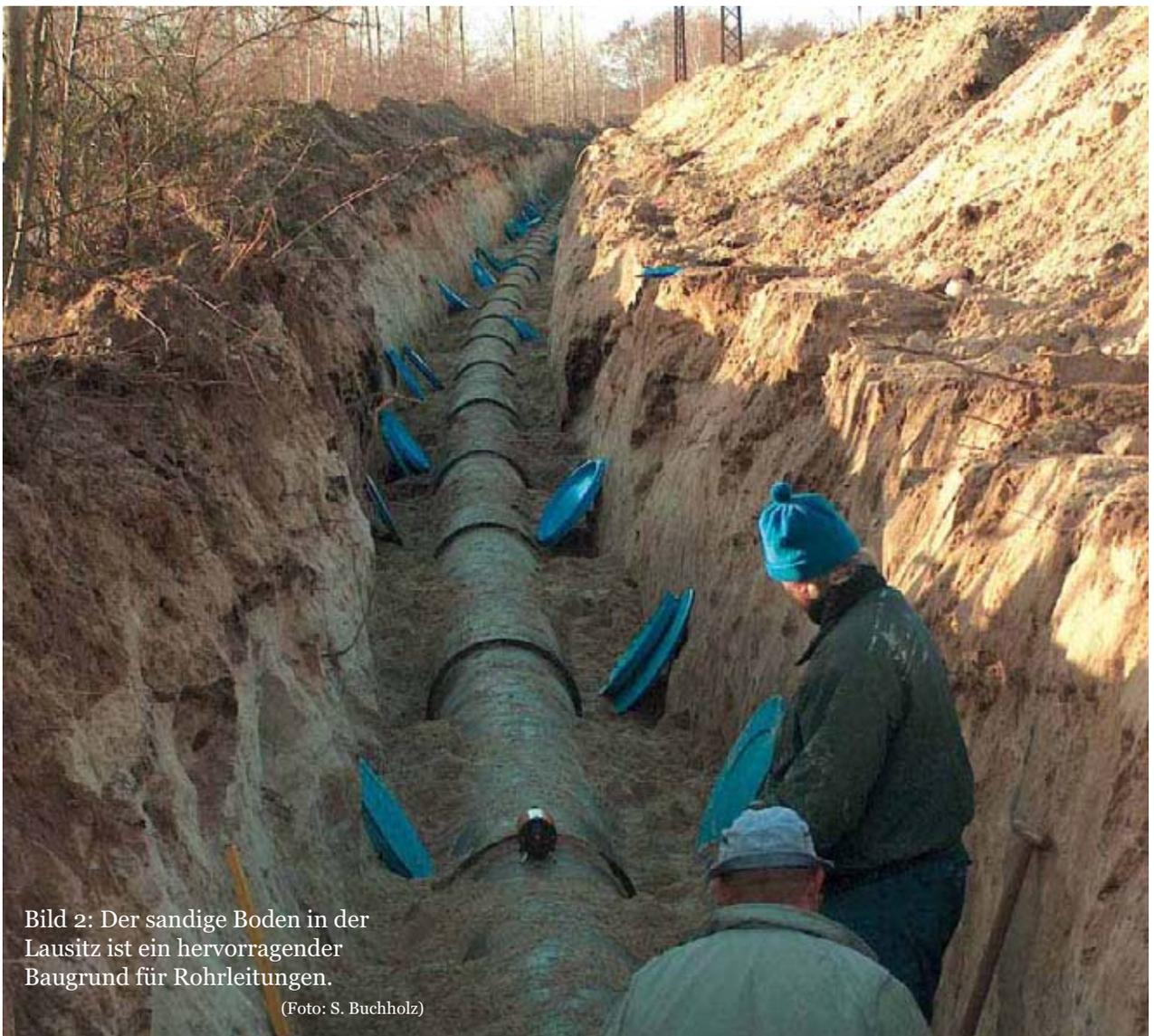
Bild 2: Der sandige Boden in der Lausitz ist ein hervorragender Baugrund für Rohrleitungen.
