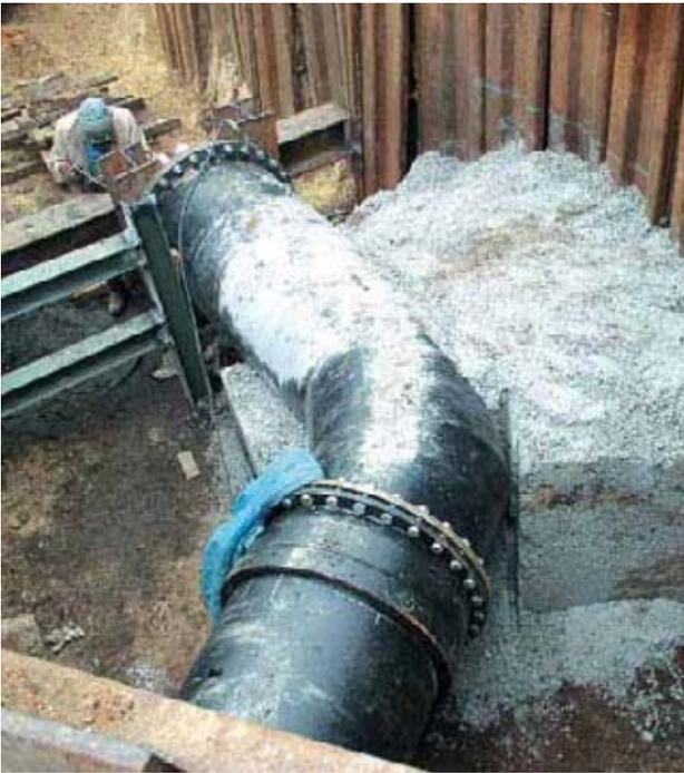
Bild 9: Einbindung in die bestehende Leitung
