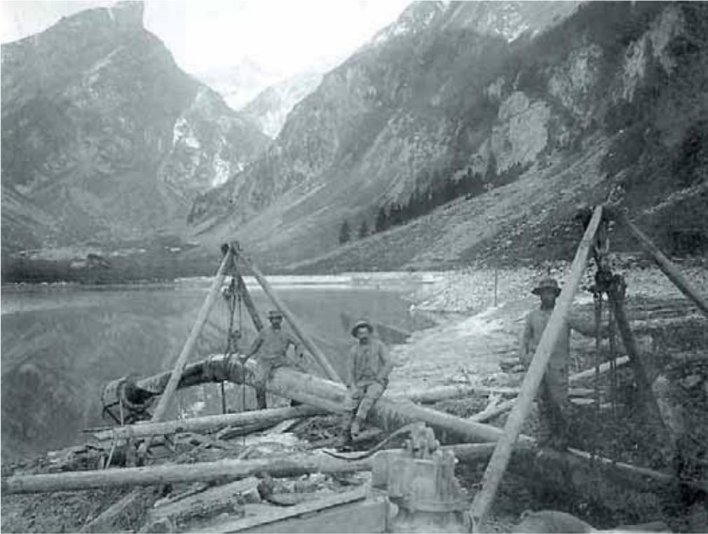
Bild 10: Einbau des Entnahmerohrs vor 100 Jahren
