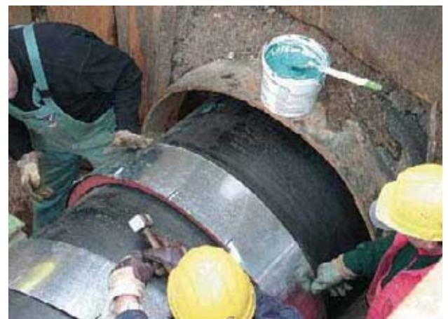
Bild 5: Montage der Rohrverbindung
