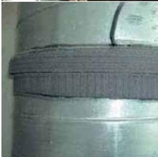
Bild 3: Weich-PE-Ring zur Isolierung des Verbindungsspalts
