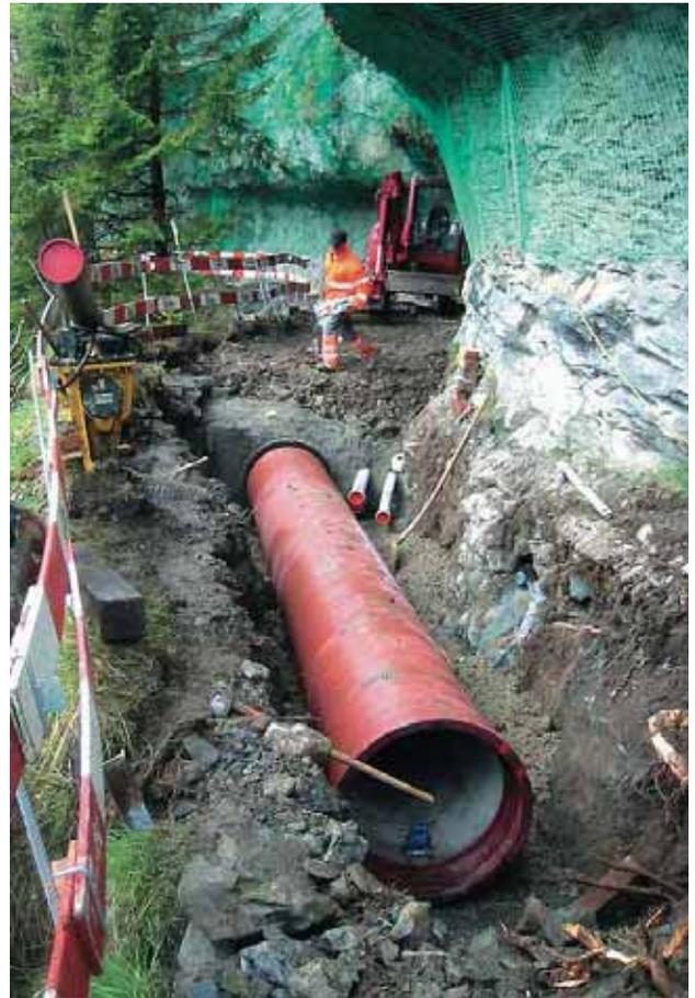
Bild 3: Rohreinbau in der Felspassage
