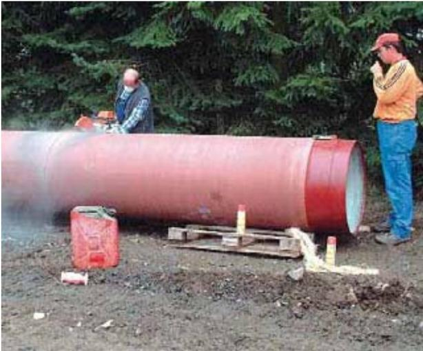
Bild 4: Schneiden von Passrohren
