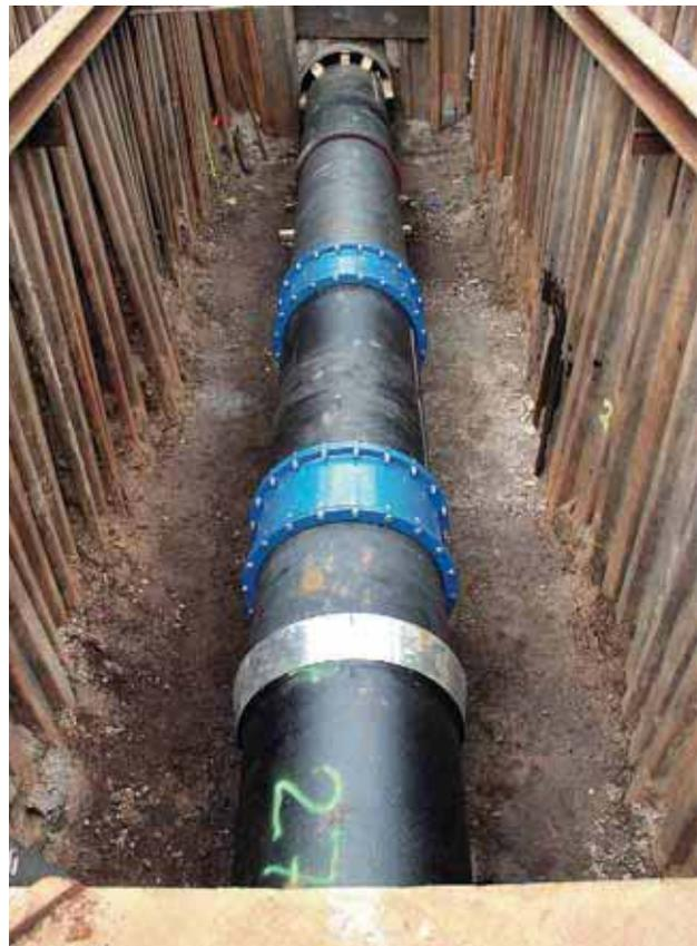
Bild 8: Verbindung der beiden Teilstrecken
