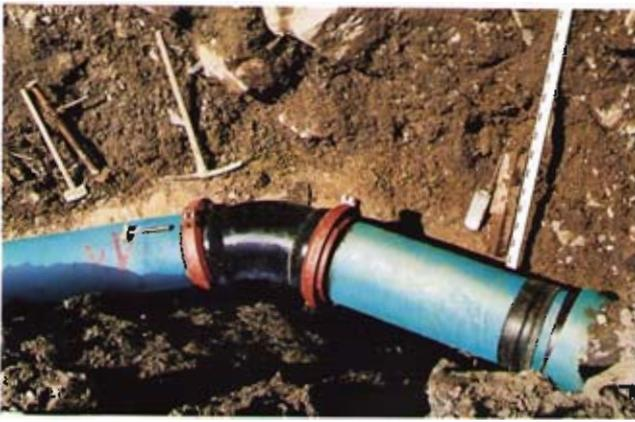
Bild 4: Bogen MMK 11° mit Schubsicherung TKF
