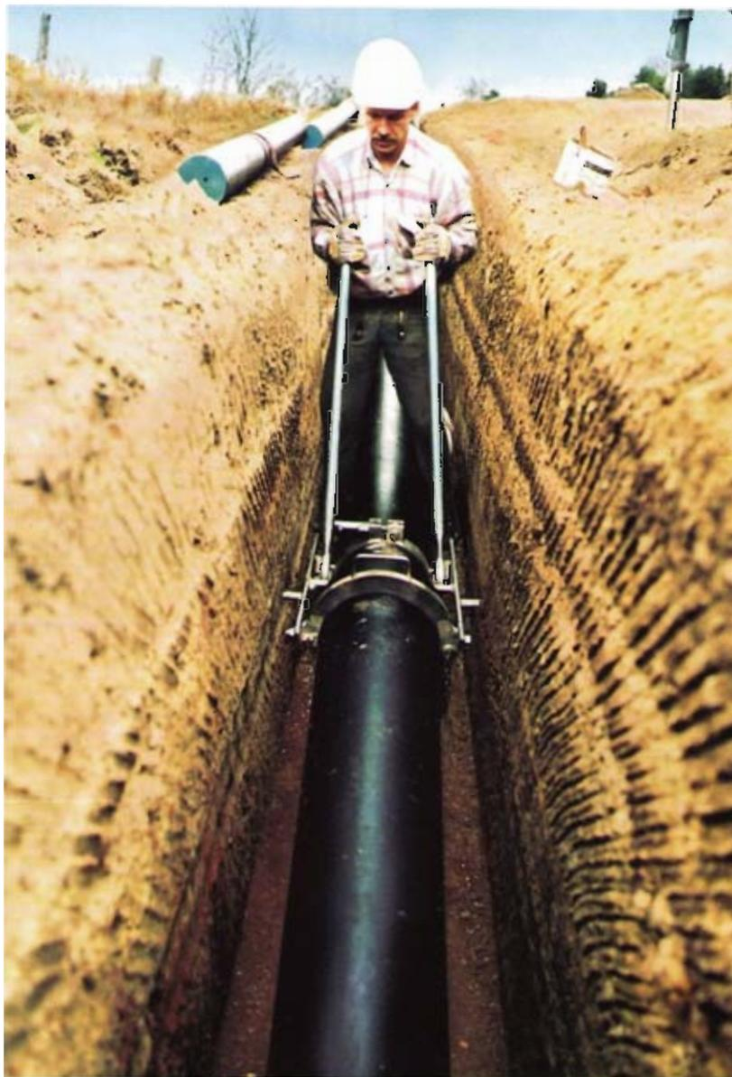
Bild 4: Rohrmontage im gefrästen Graben
