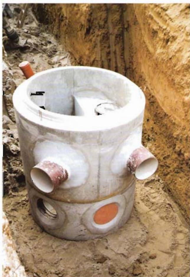
Durch die Integration von zwei Entwässerungsleitungen in einen Rohrleitungsgraben ergibt sich zusätzlich ein schonenderer Umgang mit einem wertvollen Baustoff, dem Boden. Dieses System stellt somit eine Optimierung der abwassertechnischen und ökologischen Forderungen dar. Es ist jedoch mit Mehrkosten im Vergleich zum Mischsystem von ca. 25–35% zu rechnen.
