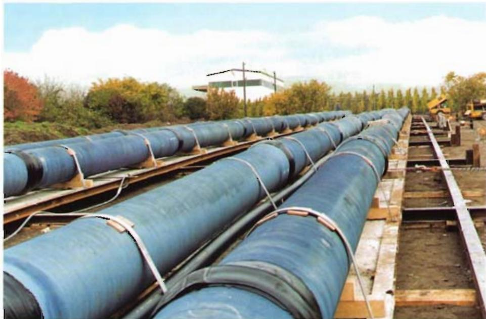
Bild 5: Verschieben eines montierten Stranges; die Komponenten des Dükers sind deutlich zu erkennen.
