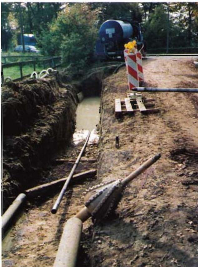
Nach allen bisherigen Erfahrungen mit dem Einbau duktiler Gußrohre im Horizontal-Spülbohrverfahren wird dieser Wert in der Praxis auch nicht annähernd erreicht, nicht zuletzt deshalb, weil die Rohre in der Bentonit-Suspension „schwimmen“.
