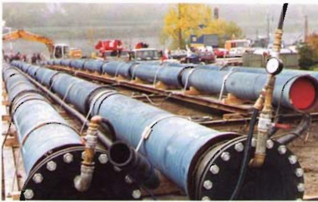
Bild 6: Erste Druckprobe nach der Montage
