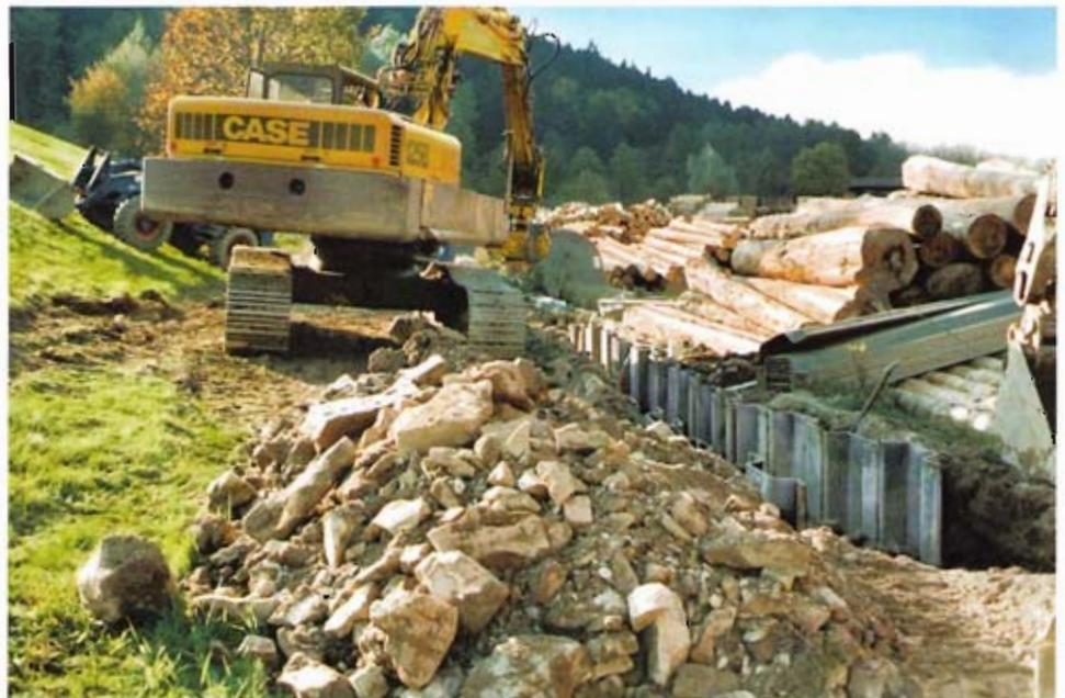
Bild 3: Aushubarbeiten im bereits gespundeten Rohrgraben
