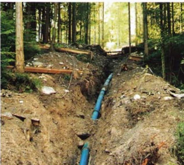
Bild 5 zeigt einen auf die Rohrleitung gerutschten Felsblock von ca. 250 kg Gewicht. An der ZM-Umhüllung waren keine Beschädigungen feststellbar. Die ZM-Umhüllung ermöglicht den Verzicht auf Kieseinbettung, weshalb schwieriger Antransport von teurem Bettungsmaterial und Abtransport von Erdmassen entfallen kann. Der vorhandene Aushub kann zur Verfüllung des Rohrgrabens wieder verwendet werden.
