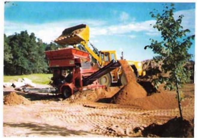
Bild 5: Fahrbare Siebanlage zur Gewinnung des Bettungsmaterials aus dem steinigem Aushub
