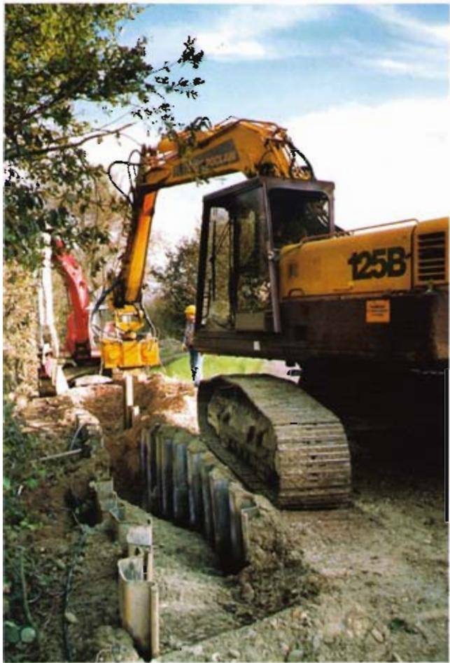
Bild 2: Einbringen der Spundwände mittels Vibrationsramme
