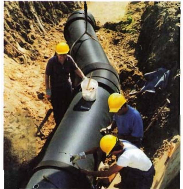
Bild 4: Schelle zur mechanischen Vorreckung der TKF-Schubsicherung wird aufgespannt
