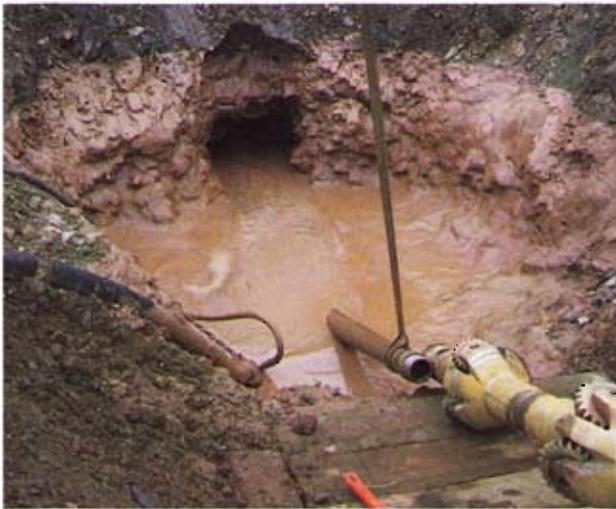
Bild 8: Aufweitkopf (Backreamer) in der Rohrmontagegrube
