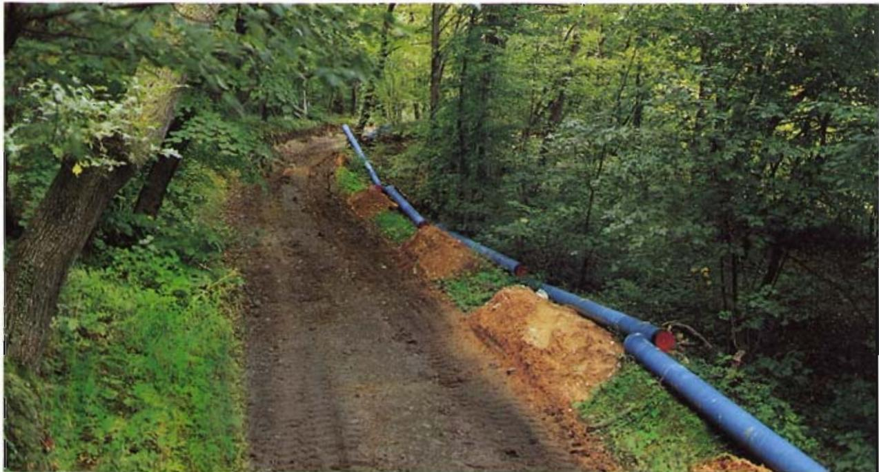
Bild 3: Vorheriges Auslegen der Rohre und des Kieses vermeidet Transporte während der Baudurchführung auf beengtem Bauraum
