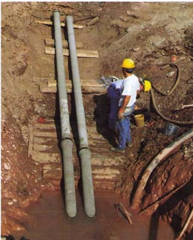
Bild 11: Austritt des Rohrstranges nach 186 m unter der Mosel
