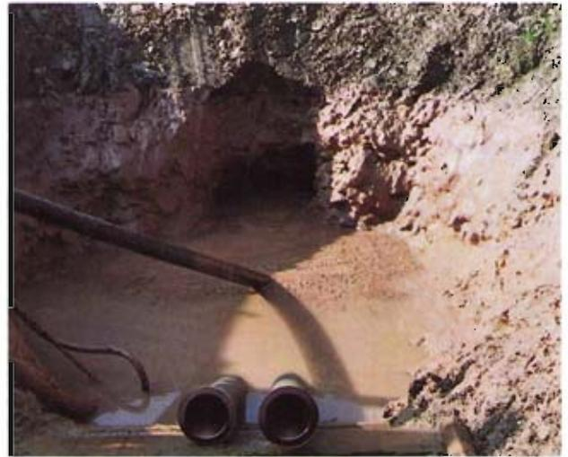
Bild 9: Einziehen des 1. Rohrpaars
