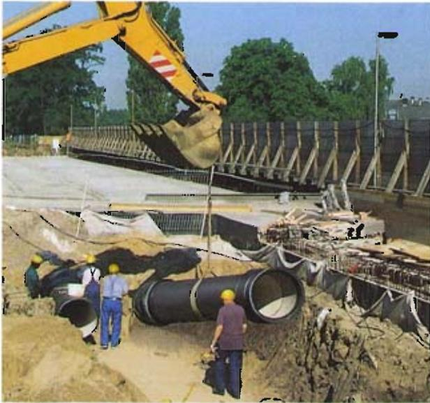
Bild 5: Rohr mit vormontiertem Bogen wird in den Graben gelassen
