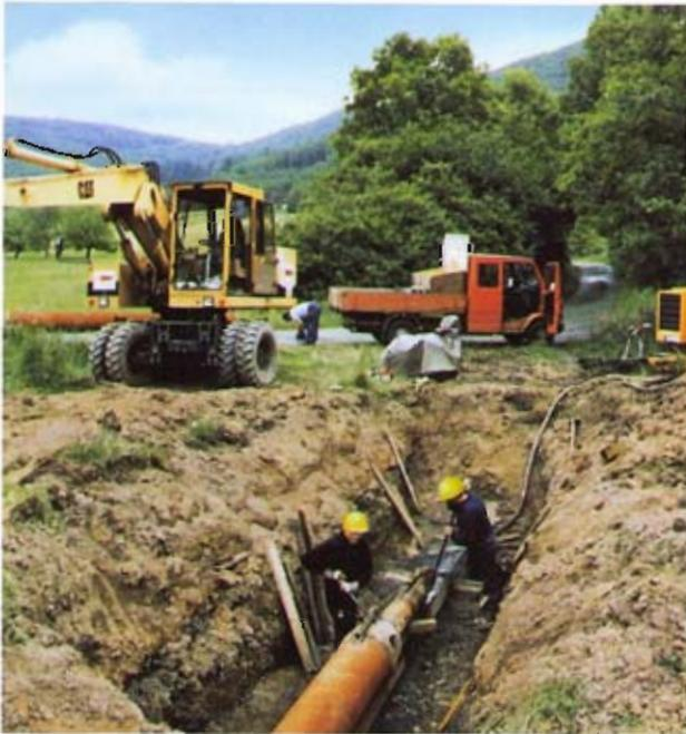
Bild 9: Durchpressung unter Benutzung spezieller Transportschellen für das Einziehen ins Mantelrohr.
