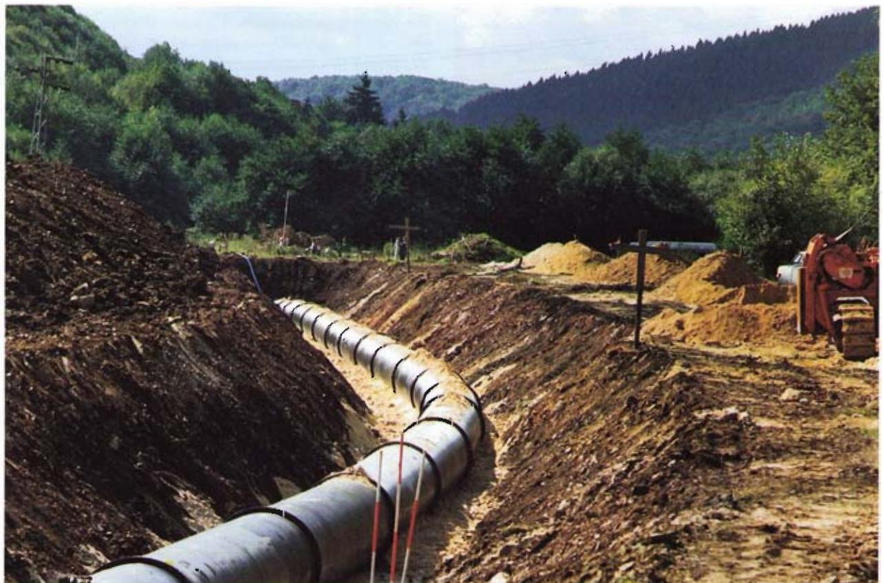
Bei nicht vermeidbaren Bogen-Formstücken, z. B. bei örtlichen Zwangspunkten, bieten diese durch die beidseitige TYTON-Muffe neben der vorgegebenen Richtungsänderung eine Vielzahl weiterer Abwinkelungsmöglichkeiten:
