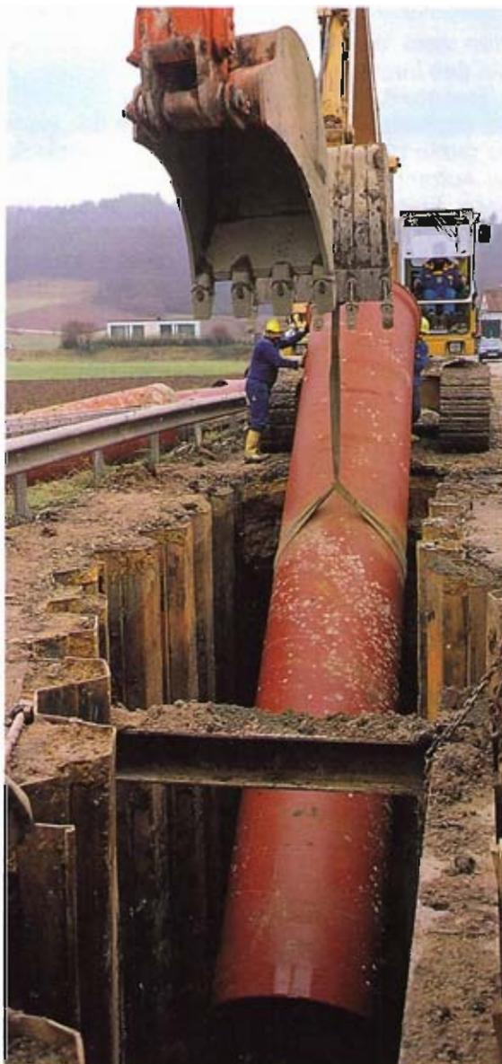
Die Zementmörtel-Umhüllung mit Kunststoffmodifizierung bietet ein hohes Maß an Korrosionsbeständigkeit und mechanischem Schutz. Durch Einsparung der Sandbettung leistet sie beim Einbau selbst in steinigem Boden ihren Beitrag zur Senkung der Baukosten und darüber hinaus zur Einsparung von Deponieraum und Schonung der Ressourcen. Seite 52
