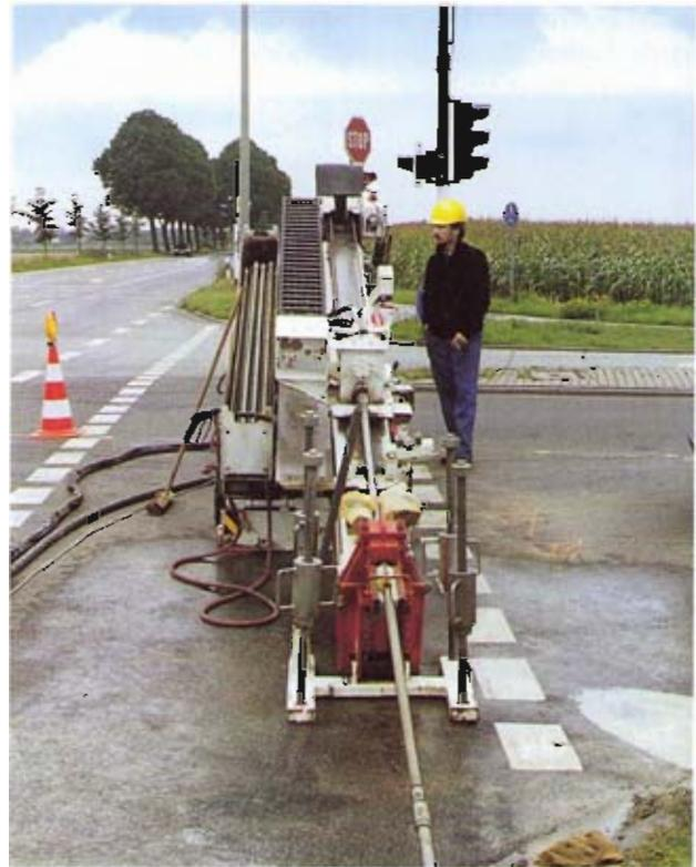
Bild 4: Bohrgerät an der Startgrube
