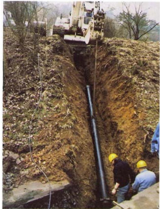
Bild 4: Schubsicherung TIS-K im Steilhang
