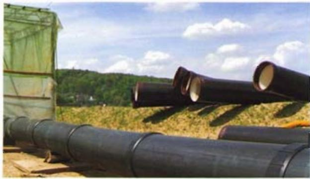
Bild 6: Duktile Gußrohre und PE-HD-Rohre vor der Montage zum Doppelrohrsystem
