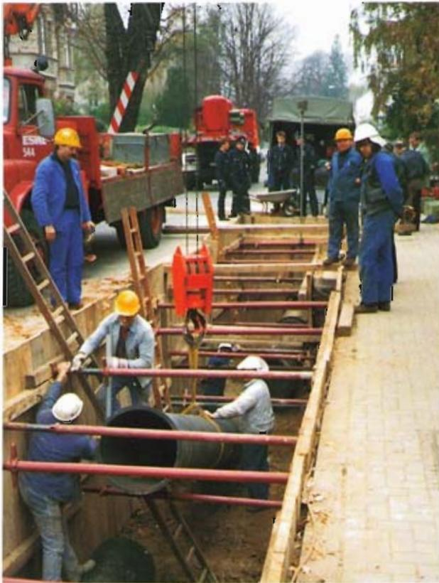
Bild 6: Das neue Gußrohr wird in den Graben abgesenkt
