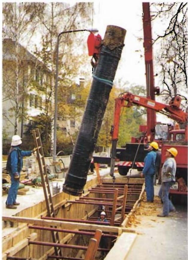
Hausanschlüsse in den Dimensionen  $\geq$  DN 80 werden aus duktilen Gußrohren hergestellt, die ebenso wie das Hauptversorgungsnetz mit einem PE-Mantel versehen sind.
