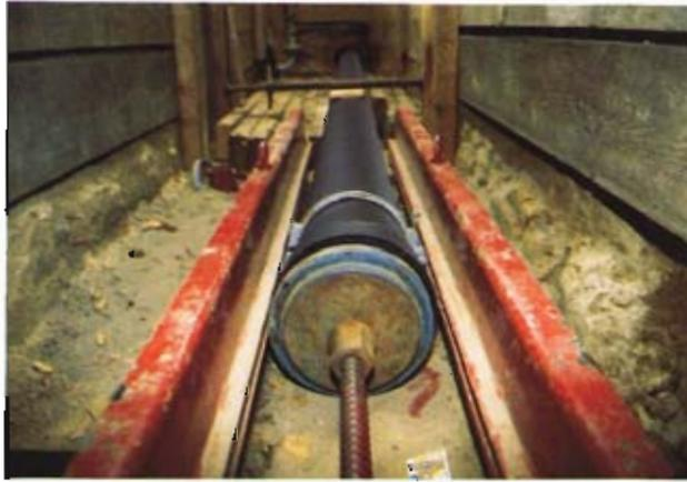
Bild 2: Führungsschiene mit neu einzuziehendem Rohr vor Beginn des Ziehvorganges
