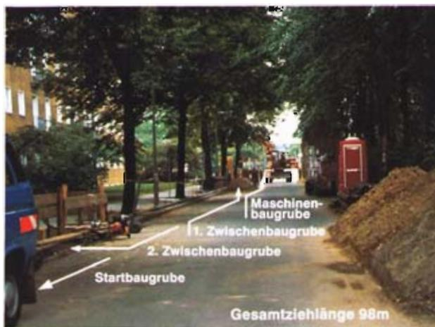
Bild 4: Auswechslung einer 98m langen Versorgungsleitung aus GG DN 100 gegen GGG DN 200. Für die Unterfahrung von sieben Bäumen, vier Laternen, einer Telefonzelle, eines oberirdischen Postverteilerkastens und drei Regenabläufen waren neben der Start- und Zielbaugrube (Maschinenbaugrube) zwei Zwischenbaugruben zur Einbindung von Anschlußleitungen notwendig.
