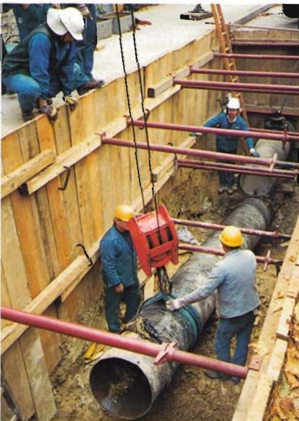
in einer Leitung DN 600 dargestellt. Eingebaut wurden Rohre aus duktilem Gußeisen mit PE-Ummantelung. Auf einigen Bildern ist zu erkennen, daß die Berufsfeuerwehr während dieser Reparaturarbeiten in Bereitschaft stand.
