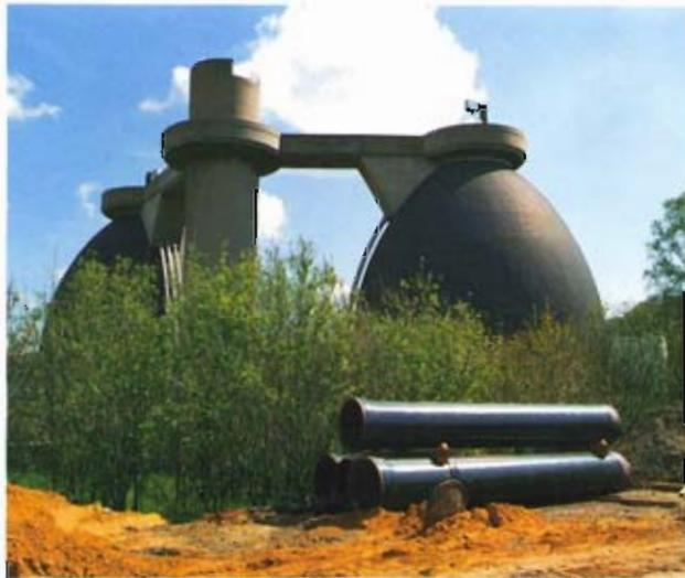
Bild 7: Duktile Gußrohre vor den Faultürmen
