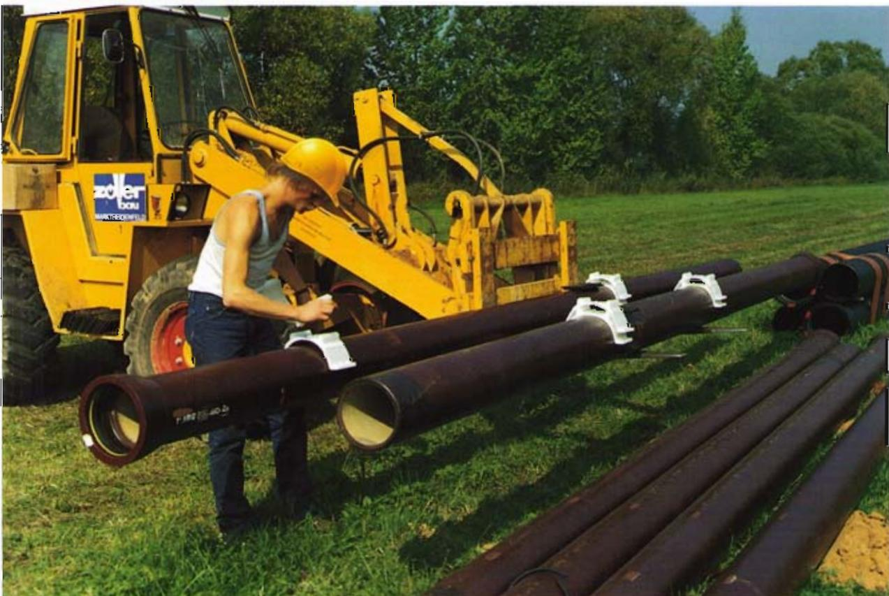
einem Arbeitsgang im Graben verlegt (Bild 4). Für das Zentrieren wurden Kunststoff-Gleitkufen verwendet (Bild 5).
