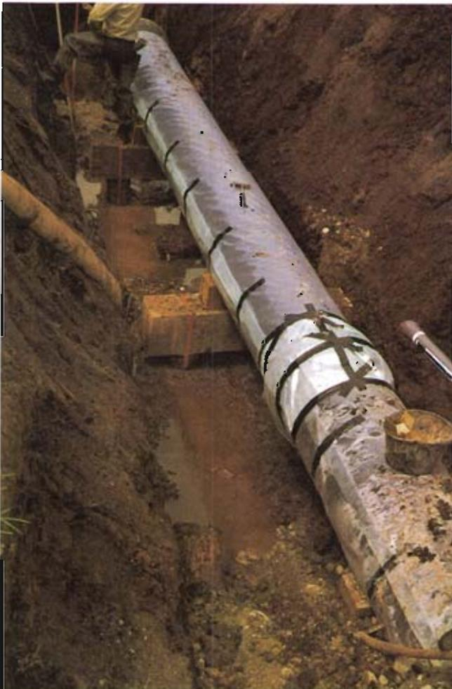
Bild 6: Fertig verlegte Rohrleitung in der Pfahljochstrecke
