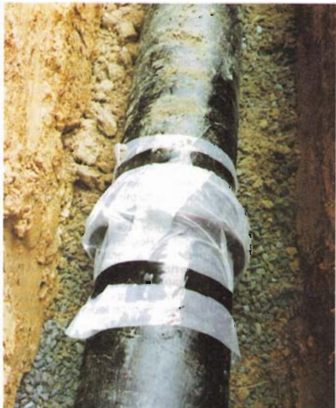
c) Fertig mit PE-Schlauchfolie geschützte Muffenverbindung
