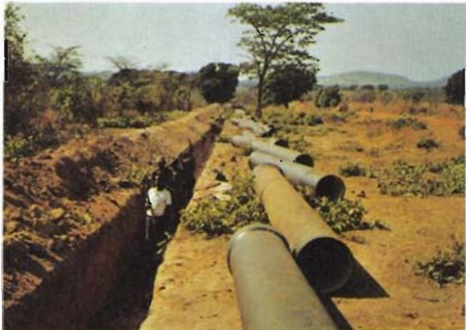
Bild 2: Längs der Trasse ausgelegte duktile Gußrohre
