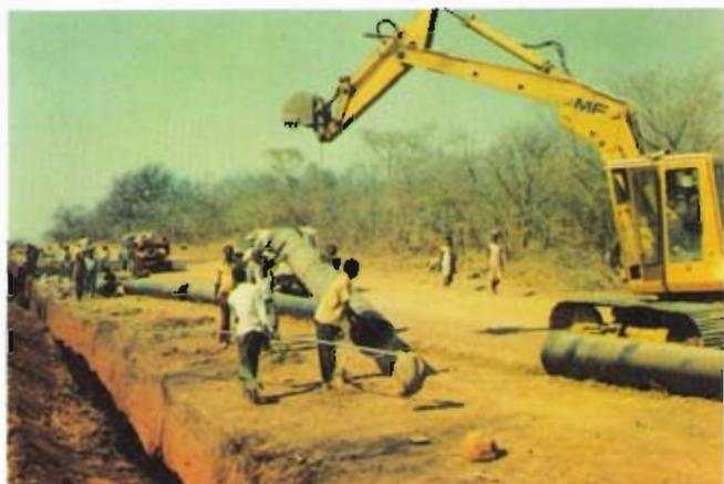
Bild 4: Verlegung mit Bagger
