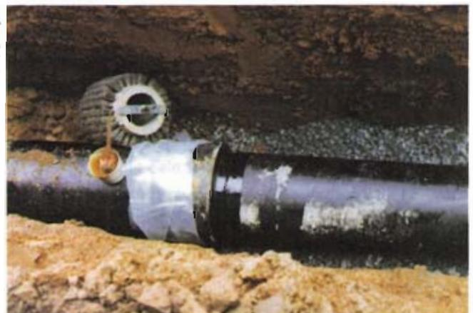
Bild 6: Schutz der TYTON-Muffenverbindung
