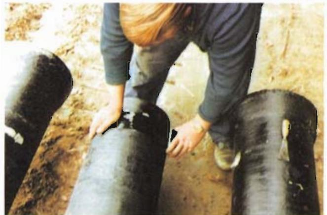
Bild 5: Umwickeln des Einsteckendes mit einem 100 mm breiten Korrosionsschutzband
