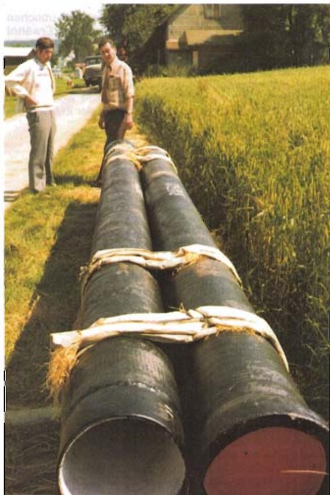
Bild 3: Rohrbündel DN 300
