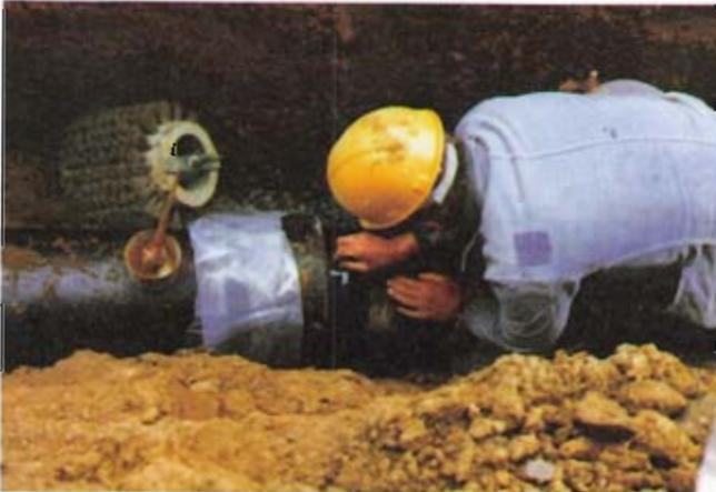
b) Überprüfen des Dichtringsitzes mit dem Taster
