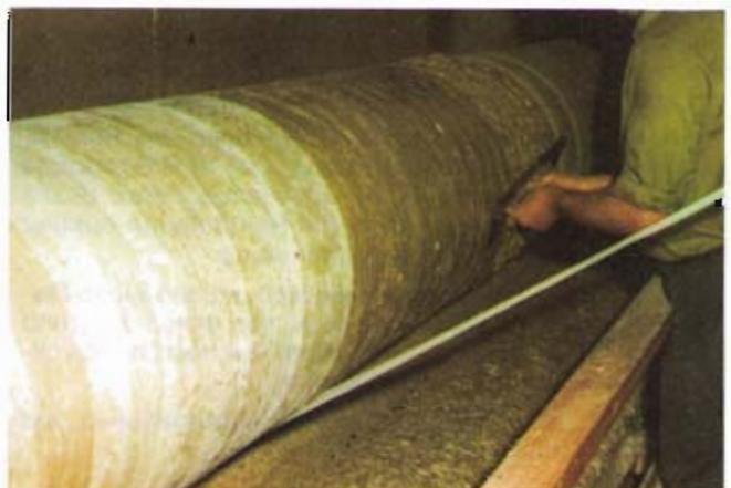
Bild 5: Bandagieren mit PE-Netzgewirk
