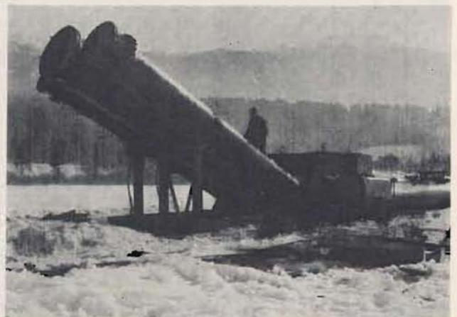
Bild 8: Endschlitten mit den ansteigenden Rohrkräften vor der Betonierung mit noch fehlenden aufgelegten Polyäthylen-Rohren
