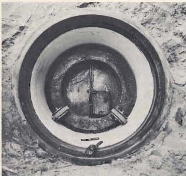
Duktiles Gußrohr mit TYTON-Muffe NW 1000 mit eingelegetem Gummiring und Rohrbürste
