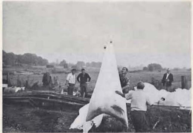
Bild 8: Mit Beton gefüllter Nylonsack
