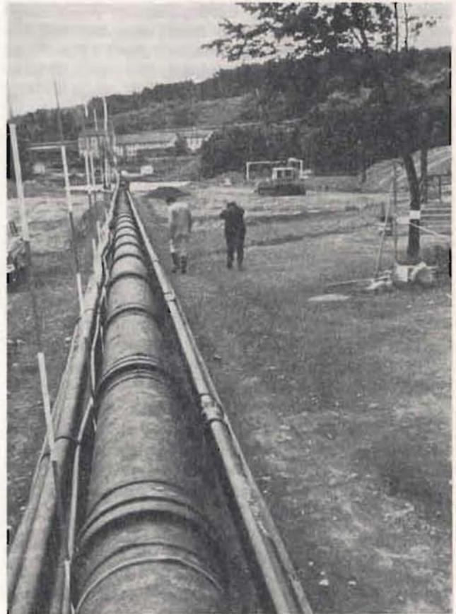
Bild 13: Lahndücker Wetzlar, u. a. mit Poly-TYTON für Gashochdruck
