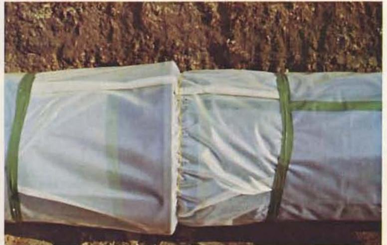
Bild 8: PE-Folienschutz für Rohrverbindung
