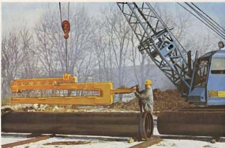
Bild 1: Verlegevorrichtung (am Kran hängend)
