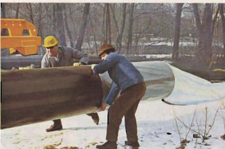
Bild 4: PE-Schlauchfolie wird auf Rohr gezogen
