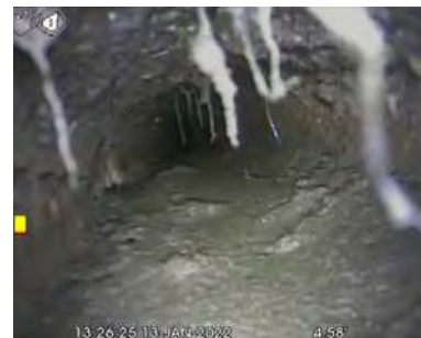
Abb. 8: Beispiel für eine Sedimentschicht von über 2 cm
