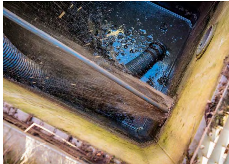
Abb. 13: Sedimente werden aus dem Kanal in den Schacht geschoben
