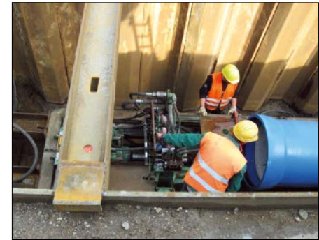
Bild 22.55: Einschieben eines Rohres
