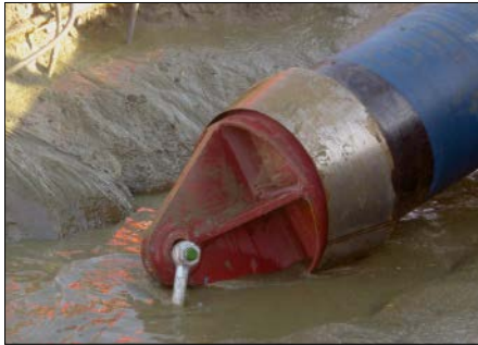
Bild 22.28: Zugkopf mit Stahlblechkonus
