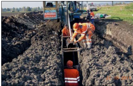
Bild 22.33: Einfräsen – Einzelrohrmontage in Gleitschalung
