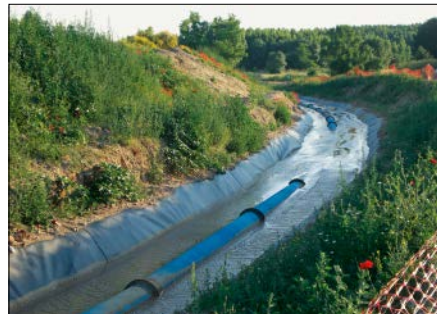
Bild 22.31: HDD – vormontierter Rohrstrang in der Bentonitsuspension schwimmend
