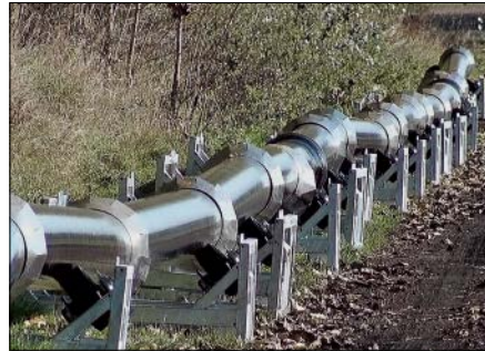
Bild 22.30: HDD – vormontierter Leitungsstrang aufgeständert
