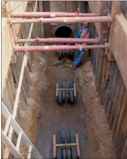
Bild 22.48: Startgrube
