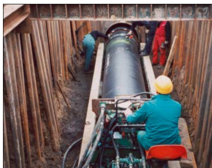
Bild 22.3: Langrohrrelining – Einschieben duktiler Gussrohre
