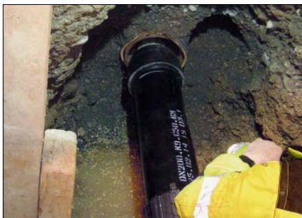
Bild 22.47: Relining DN 200 (neues Gussrohr) in ein altes Gussrohr DN 300
