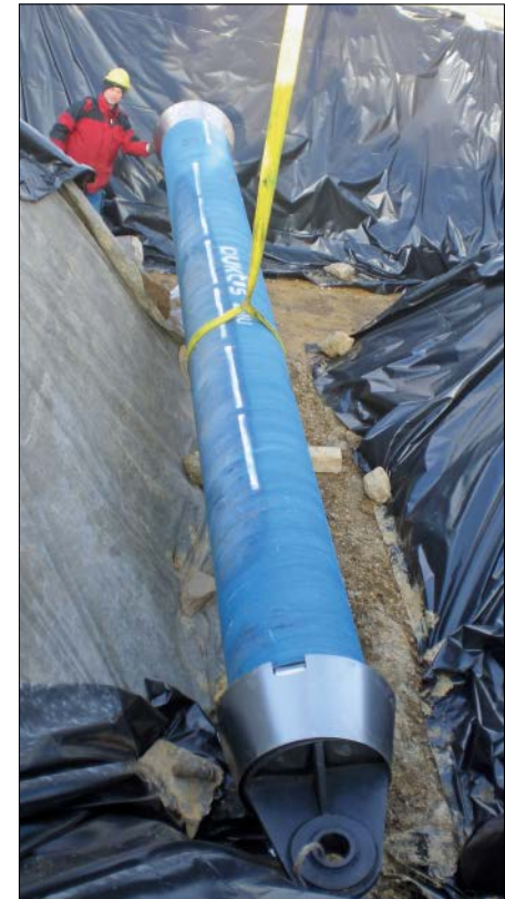
Bild 22.58: Rohr mit Zugkopf und Stahlblechkonus
