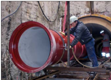
Bild 22.52: Abwasserleitung – Montage der Rollenschellen
