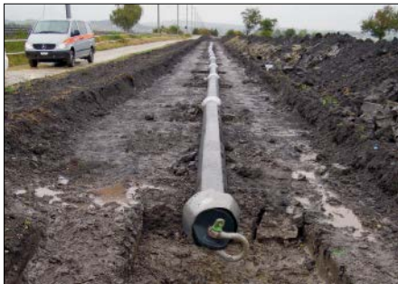
Bild 22.29: HDD – im Graben vormontierter Rohrstrang
