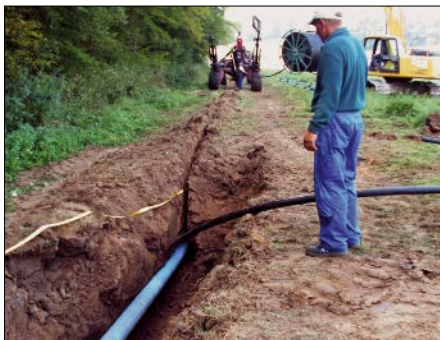
Bild 22.41: Eingepflügte Rohrleitung
