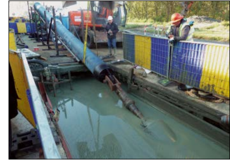
Bild 22.32: HDD – in Einzelrohrmontage mit Hilfe einer Montagerampe
