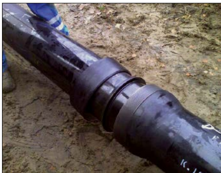
Bild 22.5: Formschlüssige Steckmuffen- Verbindung HYDROTIGHT
